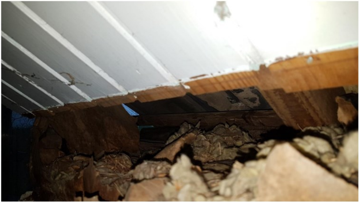
Foto 5: gat in de noordelijke gevel waardoor je naar buiten kan kijken.
