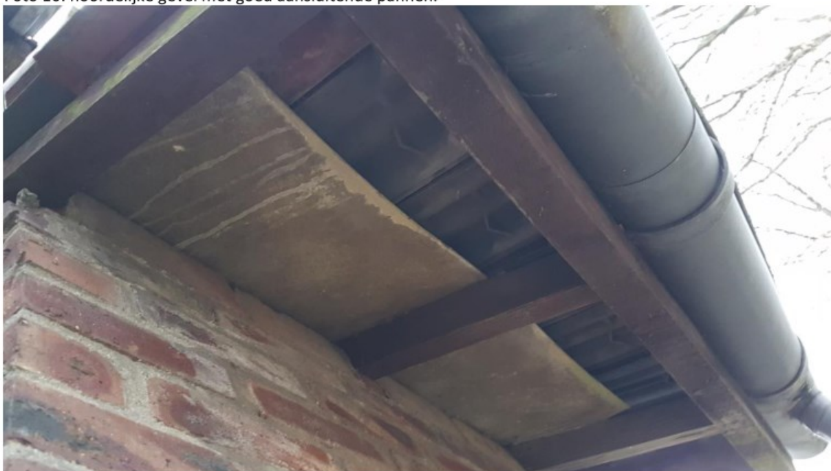
Foto 17: dakbeschot onder de pannen.
