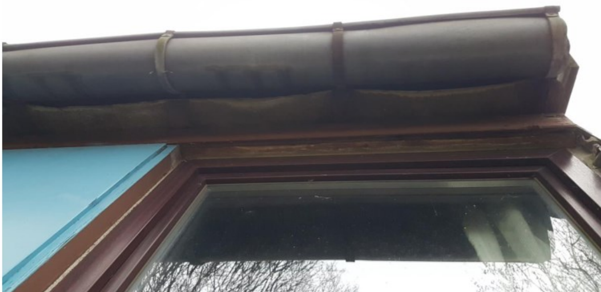
Foto 18: dakbeschot onder de pannen bij de dakkapel.
