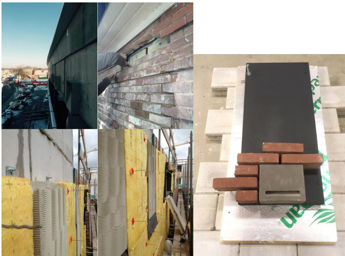
Voorbeeld inbouwmodules vleermuisverblijfplaatsen in nieuwbouw
