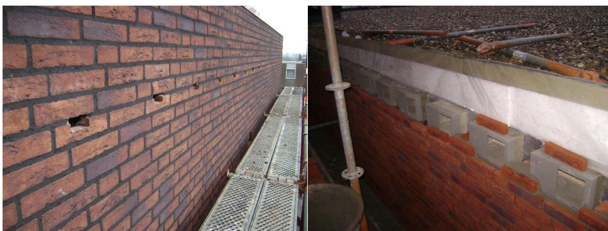
Voorbeeld inbouw gierzwaluwneststenen in nieuwbouw
