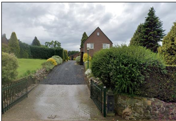
Foto's bestaande situatie met op de achtergrond de schuur welke bij de woonbestemming wordt getrokken.
