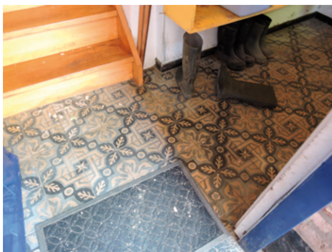
27. De gehele begane grond van de vleugel is bij de renovatie voorzien van oude, nieuw gelegde cementtegels
