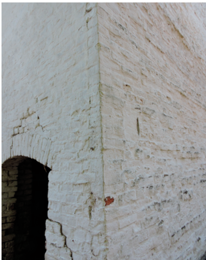
62. De buitenhoek van de schuur is deels vernieuwd, zoals te zien is aan de jongere baksteen
