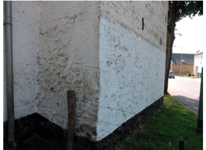
57. Het bovendeel bestaat uit 19de eeuwse bakstenen, maar de begane grond bestaat vrijwel tot op verdiepingsniveau uit metselwerk in Maaskeien en vuursteen. Hoewel dit een oplossing is die lange tijd gebruikelijk was kan niet uitgesloten worden dat die veel ouder muurwerk, en dan gemakkelijk 16de of 17de eeuws kan zijn
