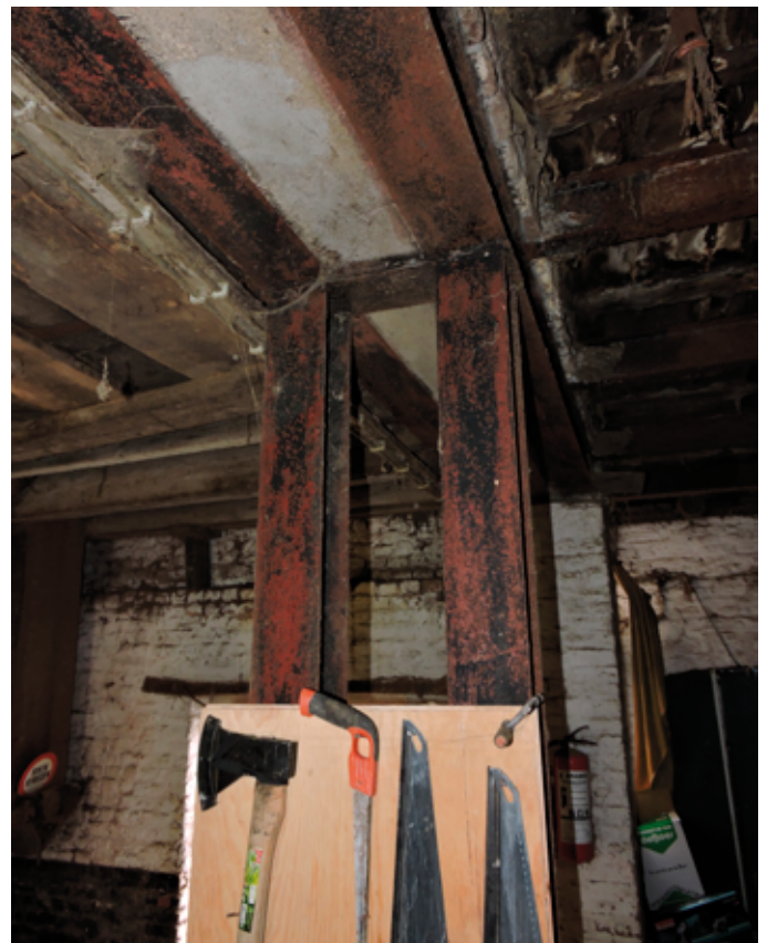
84. Daar is de oorspronkelijke constructie deels verzwaaard en verstevigd
