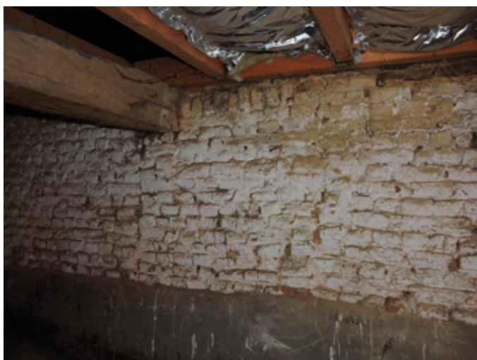
54. Het binnenblad van de muur aan de buitenzijde vertoont het gebruikelijke rommelige verband, dat in de hand werd gewerkt door het gebruik van tweede-keusstenen
