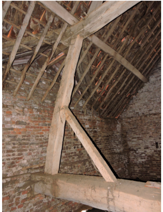
75. De aanhechting van de aanbouw achter de schuur. Het dak van de schuur liep aanvankelijk door, hetgeen er op wijst dat de aanbouw van jonger datum is, zoals ook is te zien aan het slordige metselwerk
