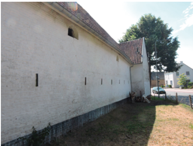
58. De lange gevel vertoont 19de eeuwse ankerijzers, en eenvoudige halfronde beluchttingsopeningen
