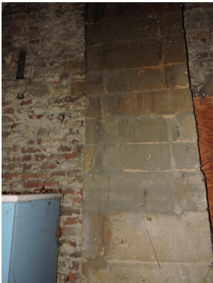
44. De door de ruimte lopende schoorsteen is opgetrokken in mergel
