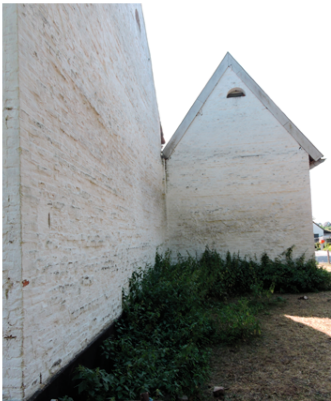
12. De topgevel van de schuur aan de zijde van de doorgaande weg van Sint Geertruid naar Mheer sluit met een hoek aan op de stalvleugel links van de poort, gezien vanaf de straat
