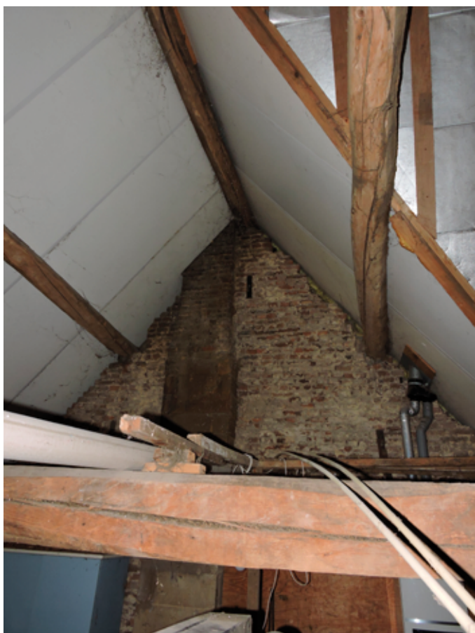
42. De topgevel op de scheiding naar de rest van de vleugel, met rechts de aanzet van het dak van de straatvleugel
