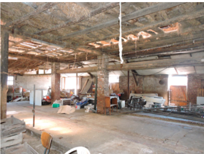
82. De aanbouw naar de veldzijde gezien...
