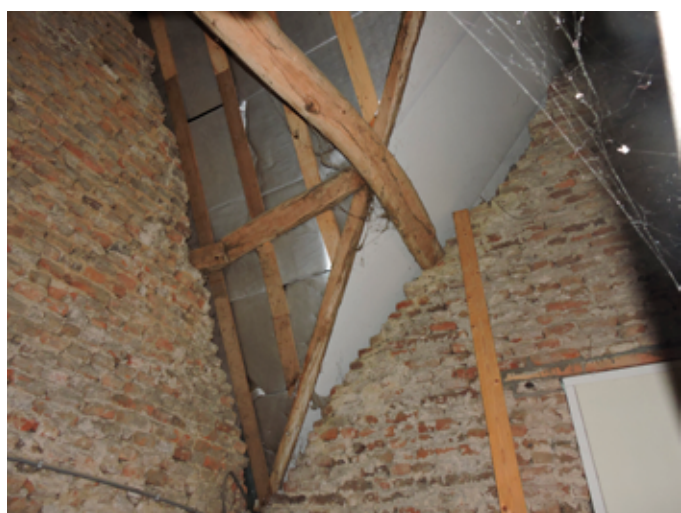
43. De constructie van de kilgoot aan de binnenplaatszijde
