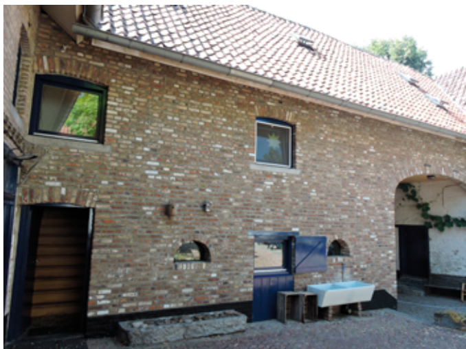
24. De vernieuwde vleugel aan de straat, met op de achtergrond de stalvleugel links van de poort
