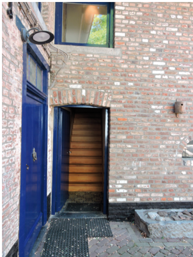
25. Ter plekke van het voetgangerspoortje dat een gangetje van de straat naar de binnenplaats ontsloot is nu de deur van de als kantoor gebruikte ruimte op de verdieping
