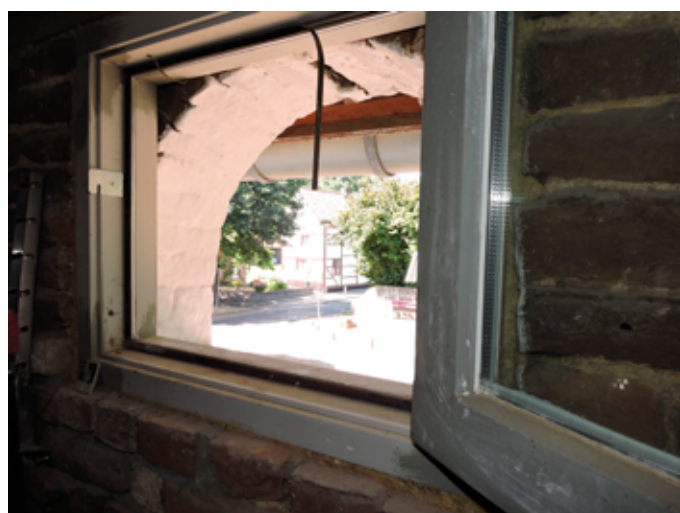
47. De luchtopeningen van de stal zijn nu voorzien van kozijnen met raamvleugels met thermopane
