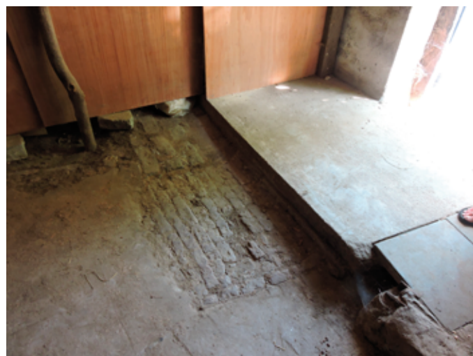
55. De vloer bestaat uit een veelheid aan oplossingen, van klinkers en bakstenen tot beton
