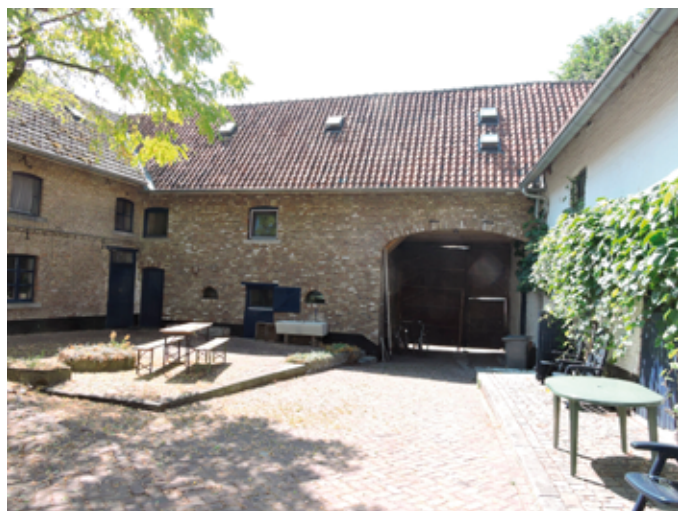
19. De muur van de poortvleugel is aan de binnenzijde rond 2000 helemaal opnieuw opgetrokken, met inbegrip van de poortboog. Links het woonhuis dat toen eveneens gerestaureerd is
