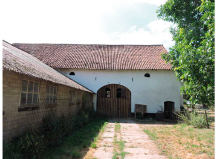
11. De tegenkant is opgetrokken in moderne betonstenen. Op de achtergrond de achterzijde van de schuur
