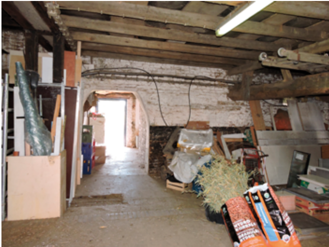
85. Zicht vanuit de paardenstal naar de veldzijde, door de aanbouw aan de buitenzijde heen gekeken
