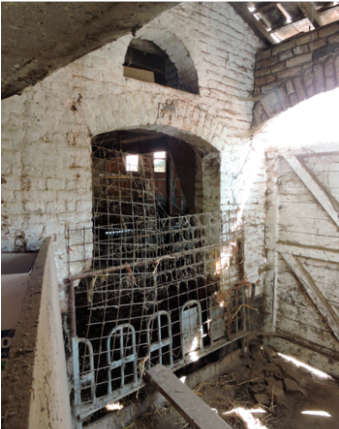
66. Onder het afdak bevindt zich een deur met luchtopening van de stal in de schuur
