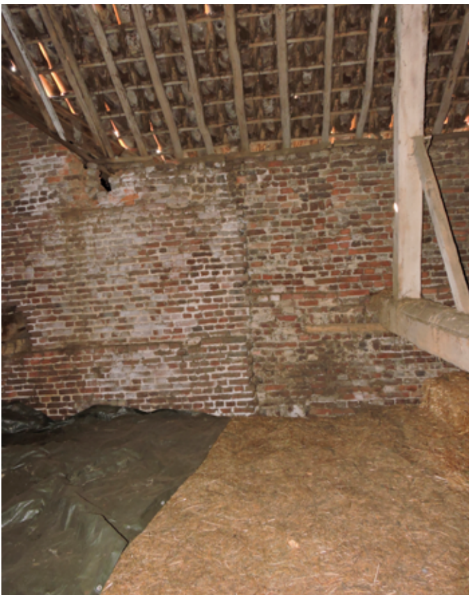
74. Een verspringing in het muurwerk bij de muur van de schuur en de paardenstal: mogelijk een reparatie
