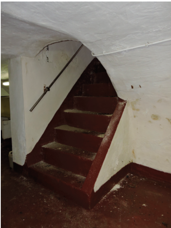
34. Eronder ligt een tongewelfde kelder waarvan het gewelf parallel loopt met de vleugel. Dat wijst op een functie in het agrarisch gebruik, en niet op een woonhuiskelder, die van binnenuit bereikbaar zou zijn, en dan een kwart slag gedraaid zou liggen
