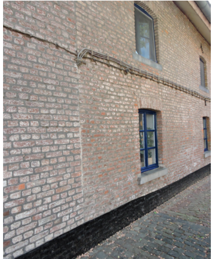
21. De overgang van het huis uit 1750, met kleine bakstenen naar de stal links, van rond 1850, met veel grotere stenen
