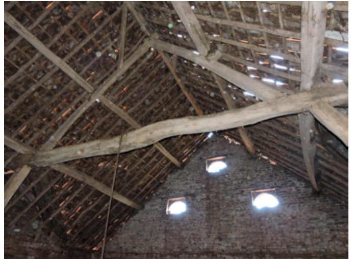
73. De topgevel rechts. Ook hier eenvoudige schaarspanten uit de tweede helft van de 19de eeuw
