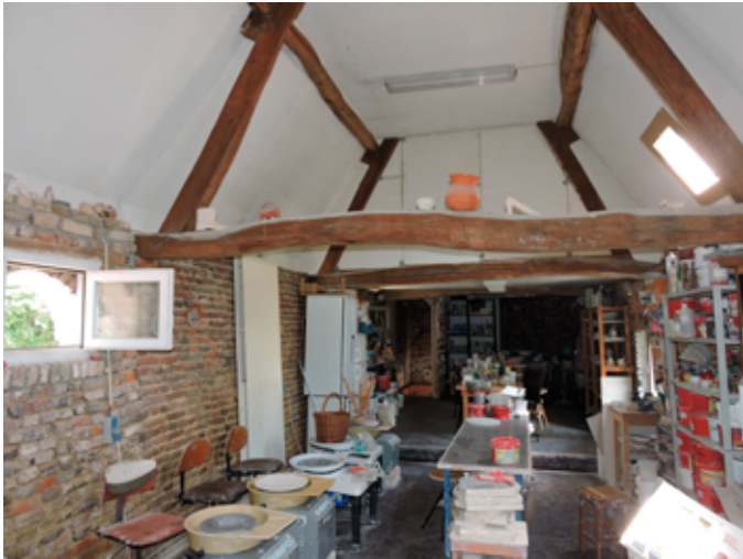
48. De ruimte richting naar achter gezien. In de hoek loopt de trap vanaf de begane grond
