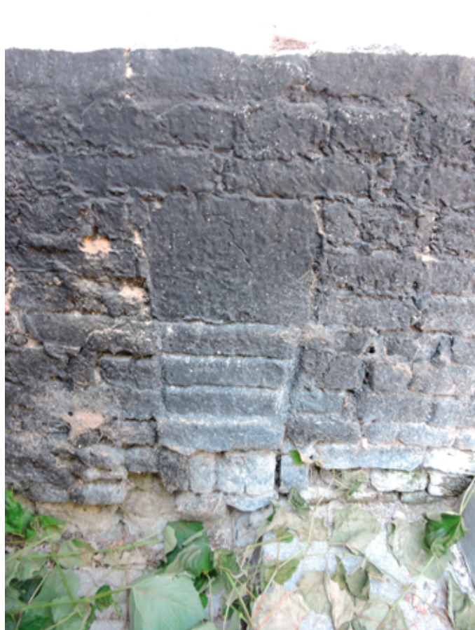
37. In de plint zit een dichtgemetselde beluchtingsopening van de kelder
