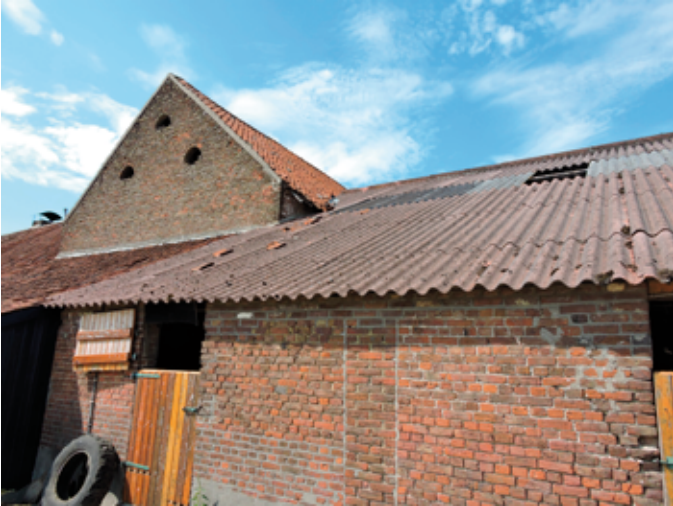
10. Daarachter, tegen de zijkant van de schuur aangebouwd, staat een oudere massa met een modern dak van golfplaten. Aanvankelijk was dit een open stalling op pilasters, die nog zichtbaar zijn in het muurwerk
