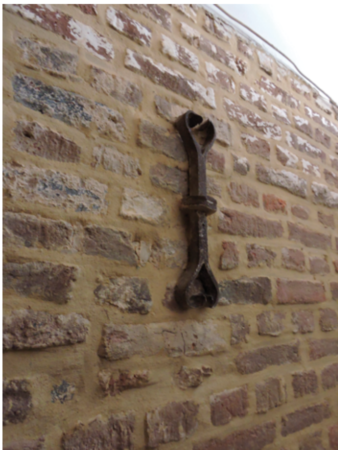
26. Bij de opgang is een ankerijzer uit 1750 zichtbaar
