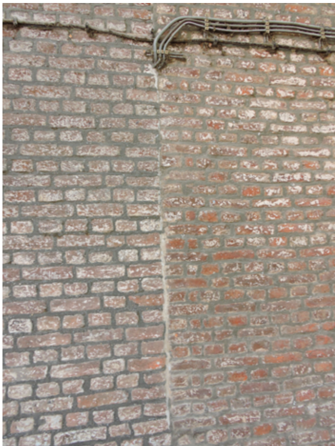
22. De hoek van het oorspronkelijke huis is duidelijk waar te nemen door de aanwezigheid van klezootjes
