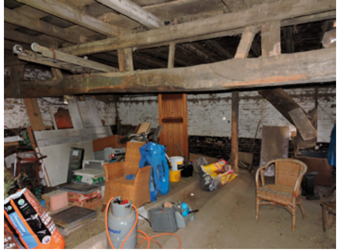
86. Oorspronkelijk spant in de stal
