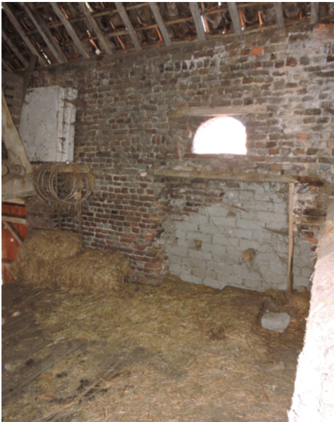
76. Ook hier vergelijkbare beluchtigingsgaten als bij de stallen
