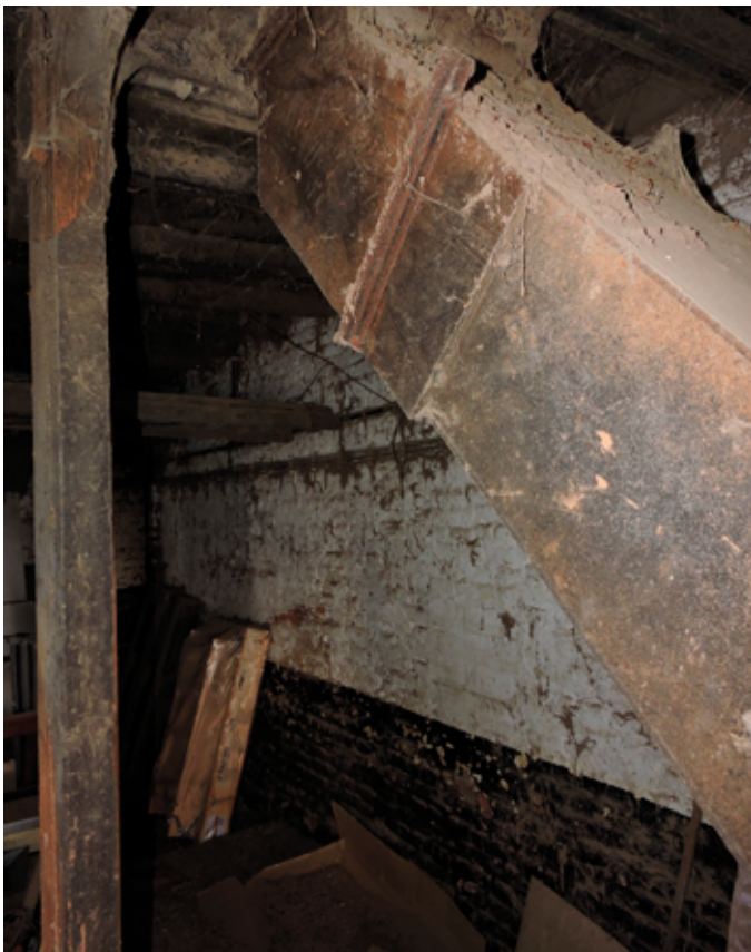
87. Restant van een afvoer van een silo met veevoer op de verdieping
