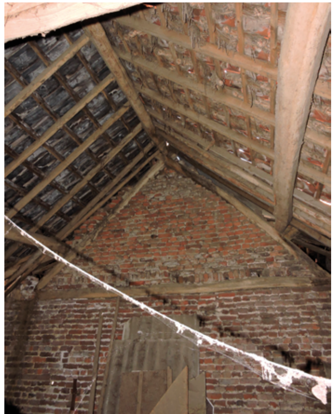
88. De scheidingsmuur met de schuur
