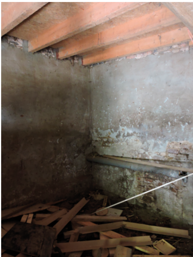
52. Het vernieuwde plafond is deel van het keramiekatelier
