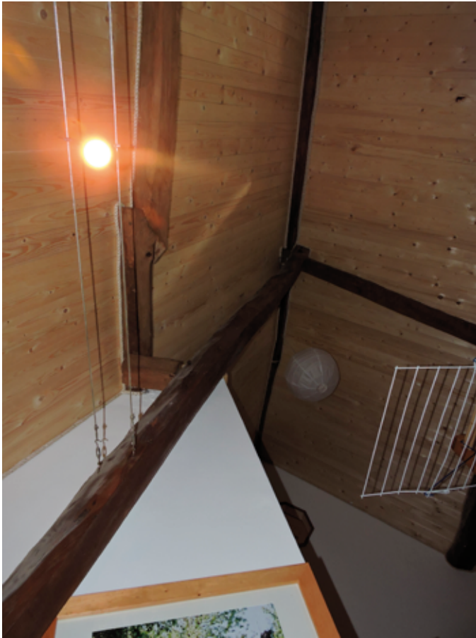
28. De zeer eenvoudige schaarspanten van de herbouw uit 1859
