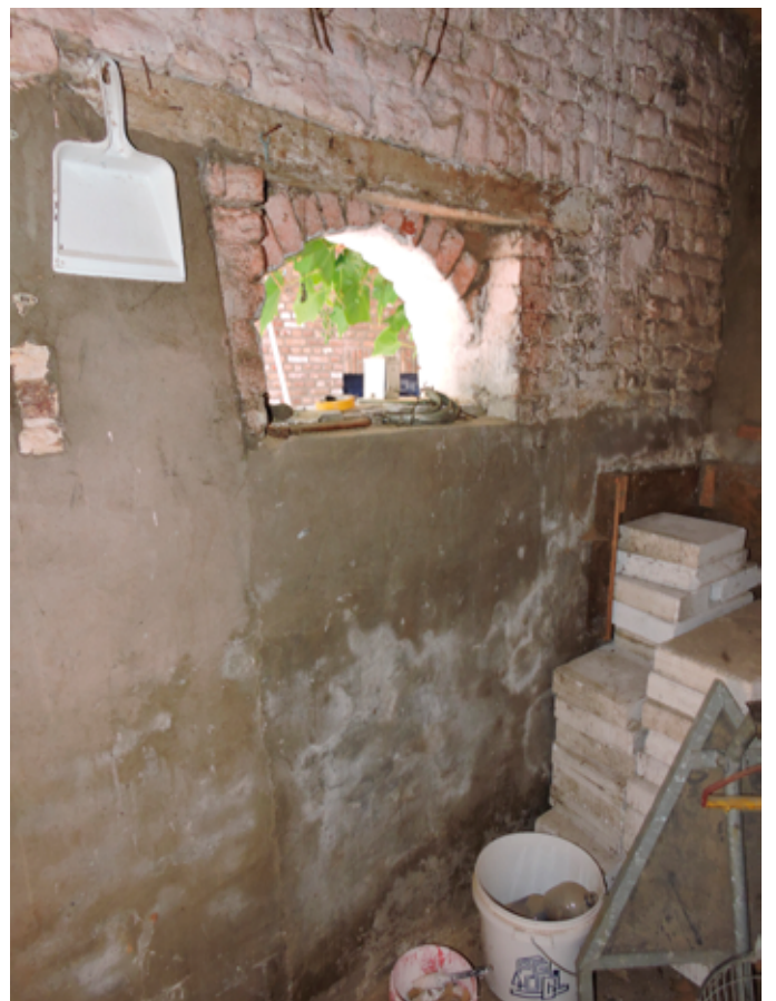
51. De begane grond van de vleugel is nog herkenbaar als veestalling
