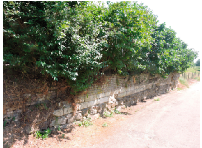
7. Rechts van de oprit staat een restant van het op de Tranchotkaart en de oerkadasterkaart nog aanwezige pand. Maaskeien en mergel in de sokkel, jongere baksteen erboven
