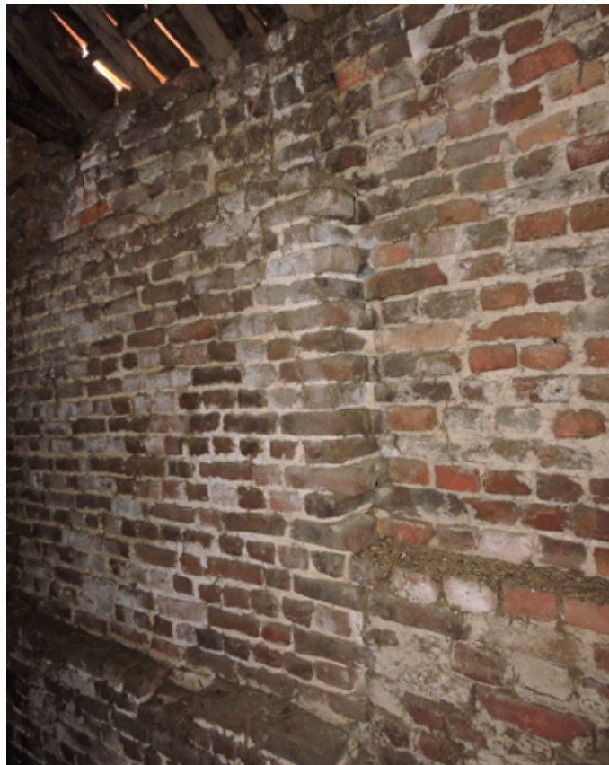
77. Een verjonging in het metselwerk aan de achterzijde
