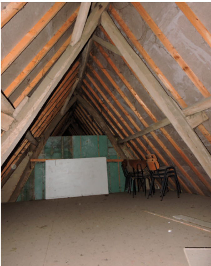
50. De zolder er boven. Ook hier zeer eenvoudige schaarspanten bouten en moeren op de verbindingen
