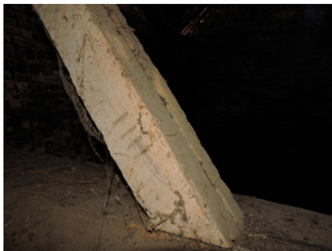
78. De telmerken die hier en daar voorkomen horen niet bij de staande constructie. Het gaat om hergebruikt hout, in dit geval een regel die schoor werd
