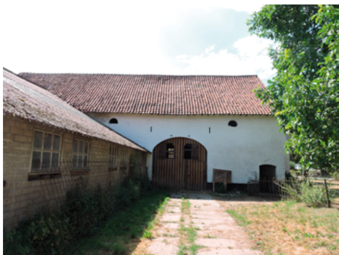
63. Opnieuw, nu als onderdeel van het verhaal van de schuur, de achterkant daarvan. De deur is secundair en bedient in de schuur gelegen stallen
