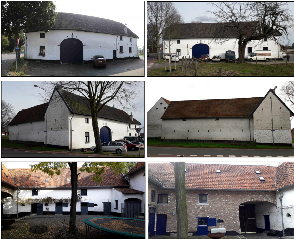
Foto's bestaande situatie
