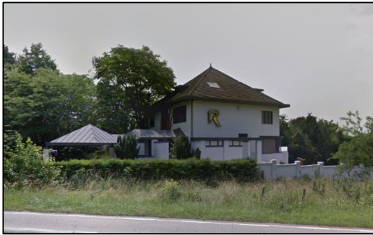
Foto's bestaande situatie
