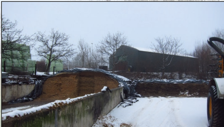
A De hoger gelegen opslag en opslagloods, gezien vanaf het erf.
