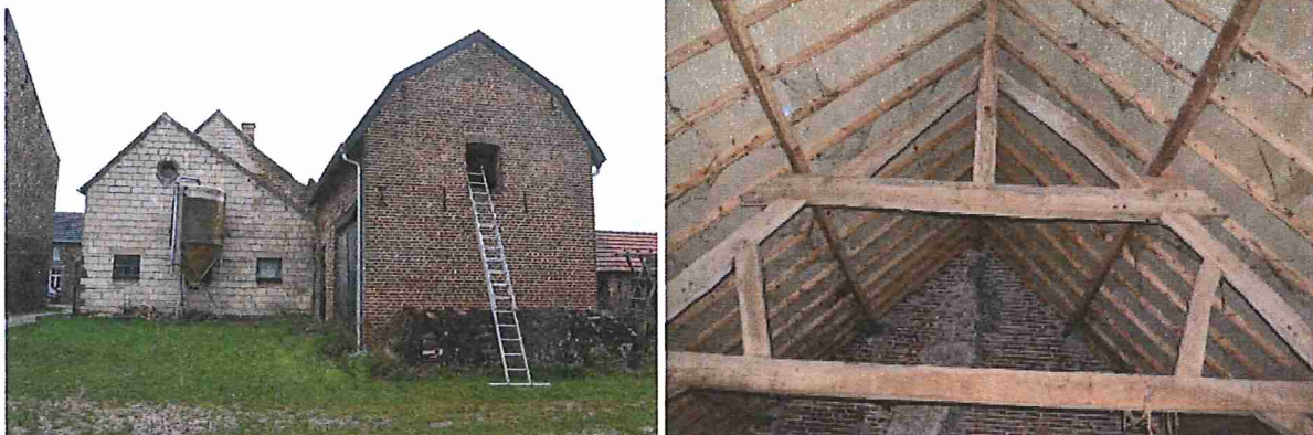
Figuur 1.3 Links: Situatie van de gebouwen horende bij de Roosenhof. Rechts: Situatie van het dak van een hooizolder ondersteund door haar (te behouden) balkenstelsel.
