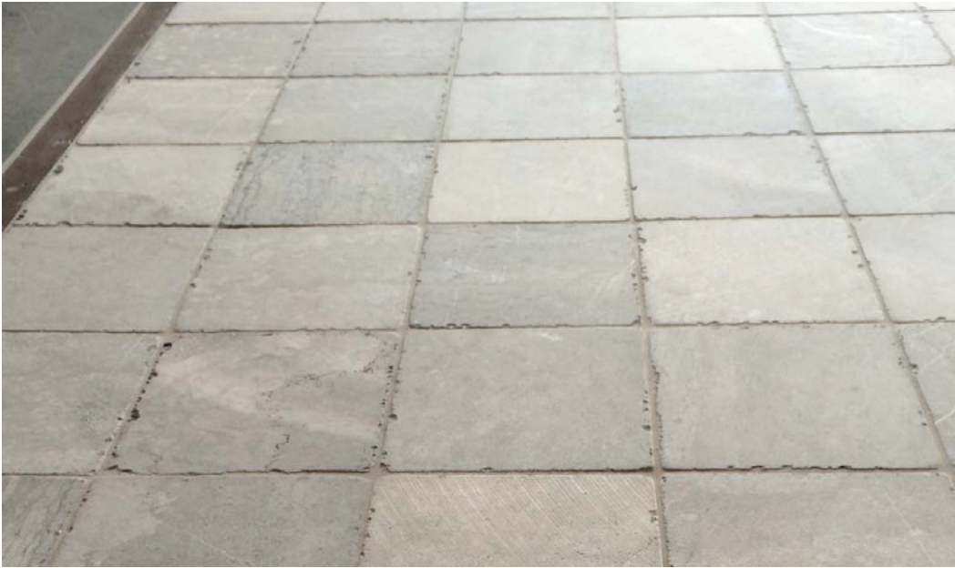
Terrassen nabij de bebouwing; plavuizen
