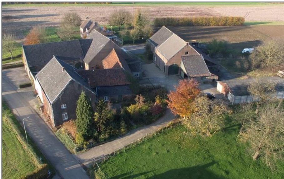
Foto bestaande situatie
