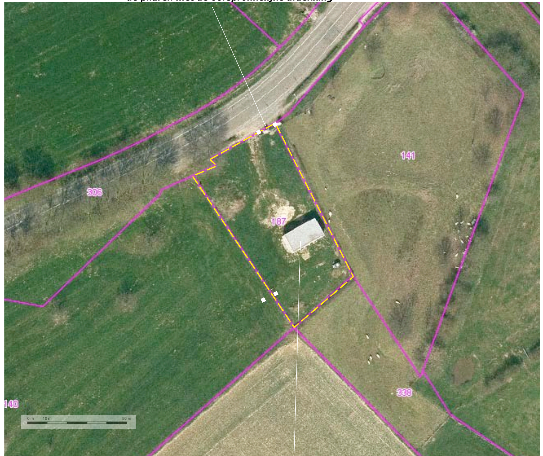
recenter gerenoveerd gebouw
