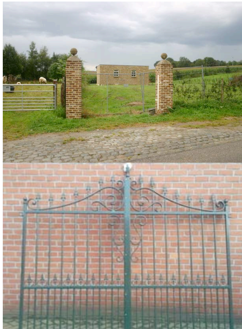
gebouw, pilaren en poort
