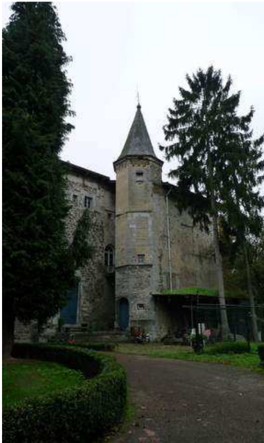
Foto 1. Vooraanzicht van het kasteel Oost. Foto genomen richting het zuidwesten.
