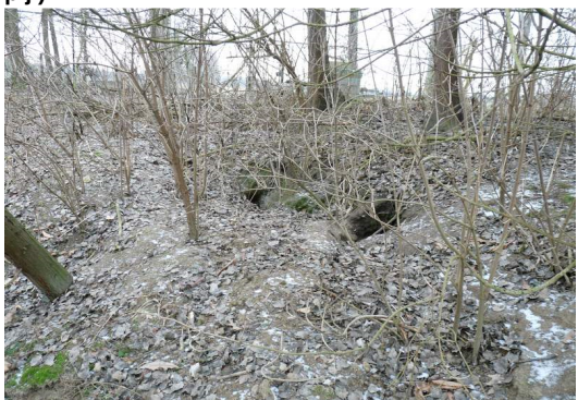
Foto 27. Enkele dassenpijpen in het talud van de voormalige gracht.
