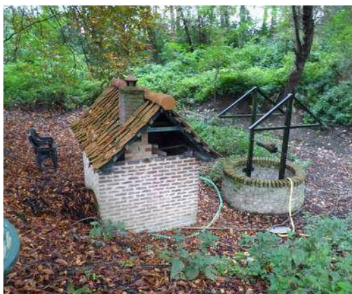
Foto 8. Put in een verlaagd deel van de achtertuin, waar waarschijnlijk vroeger de gracht is geweest. Het is te zien dat de waterstand erg laag is.
