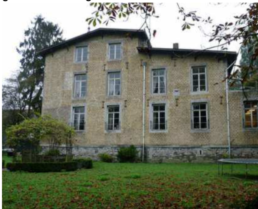
Foto 3. Achteraanzicht van het kasteel. Hier zijn etages weggevallen, en is het oorspronkelijke dak verdwenen. Aan deze kant zal de grootste verandering plaatsvinden. Foto genomen richting het oosten.
