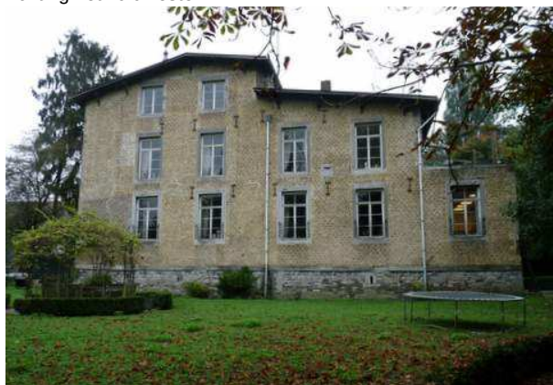
Fig. 5 Achteraanzicht van het kasteel. Hier zijn etages weggefallen, en is het oorspronkelijke dak verdwenen. Aan deze kant zal de grootste verandering plaatsvinden. Foto genomen richting het oosten.
