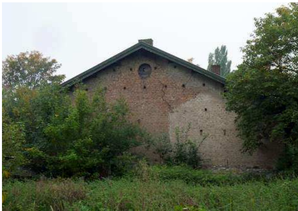
Fig. 11. Achterzijde (noordzijde) van de monumentale schuur.
