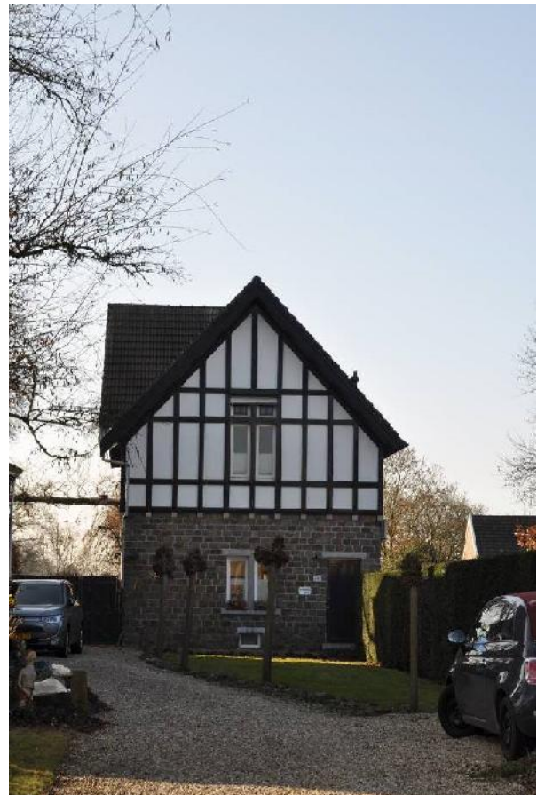
Het bijgebouw nr. 78a
