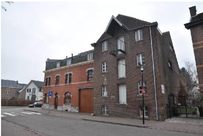
De gevels aan de Dorpstraat met rechts het fabrieksgebouw en links het woonhuis
