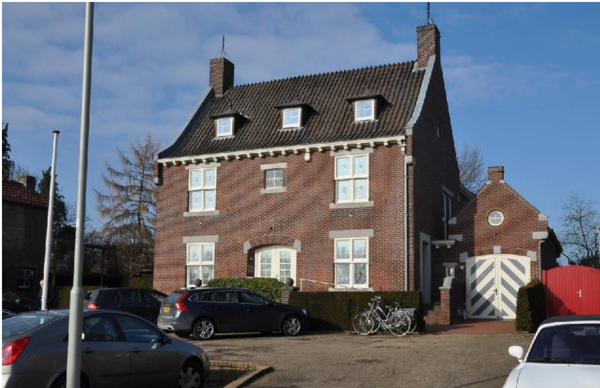
Het voormalige raadhuis uit 1950 en rechts de recent gebouwde garage in historiserende stijl
