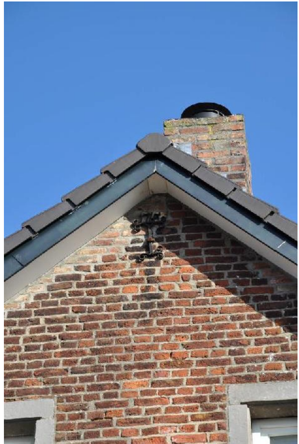
Detail van het jaaranker 1765 in de geveltop
