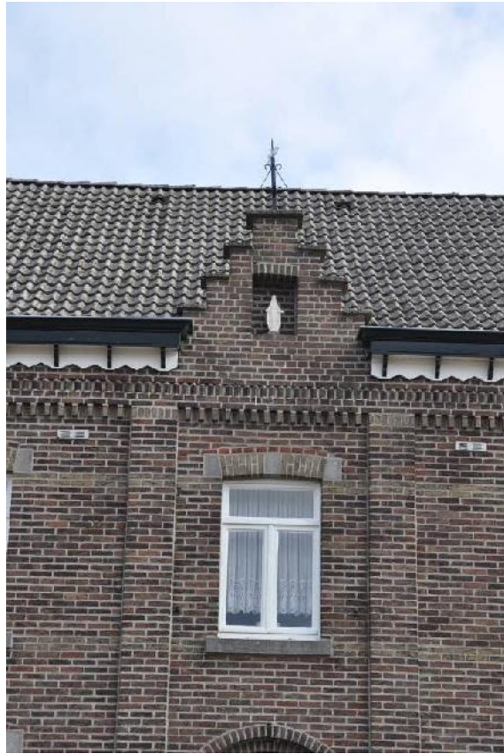
Detail van de trapgevel van de middenrisaliet
