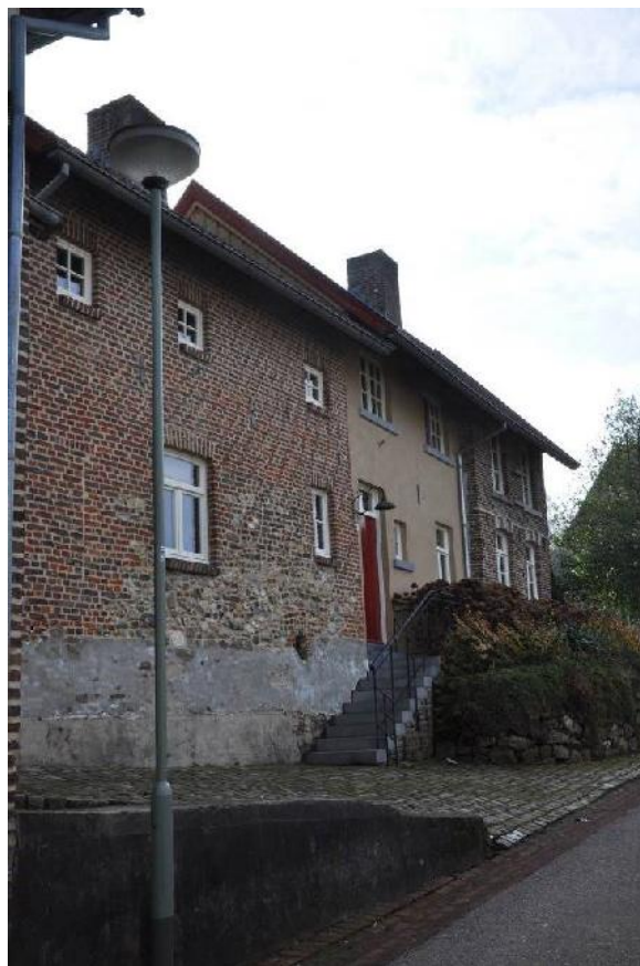
De drie bouwvolumes van de woonvleugel
