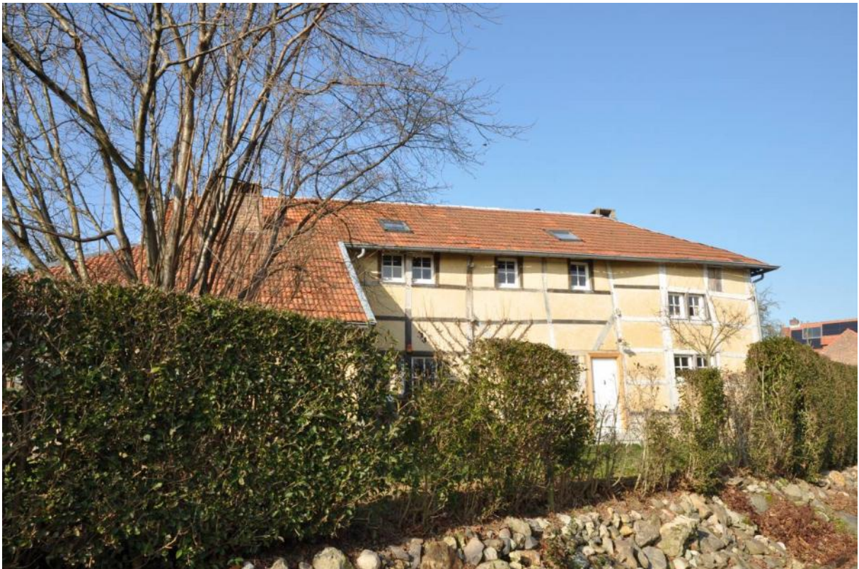
De zuidelijke zijgevel en de afhang van Loverixplein 5
