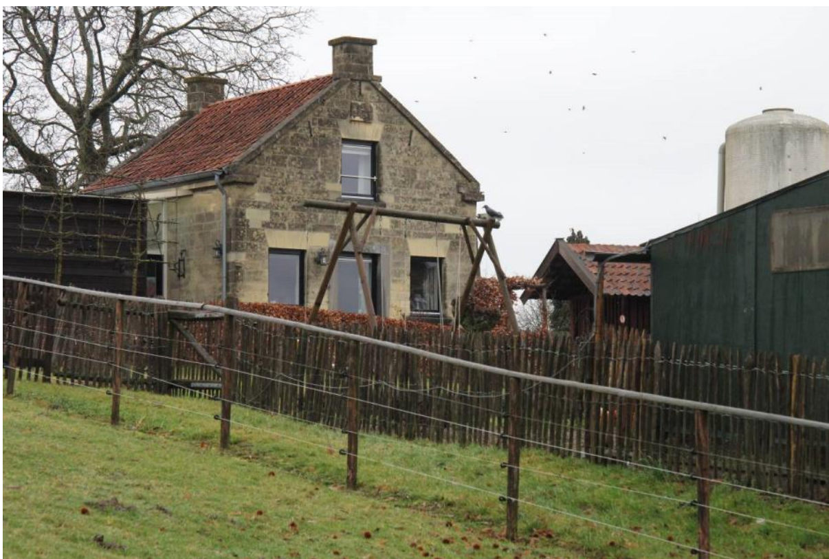
Het voormalige bakhuis en het puthuisje (rechts)
