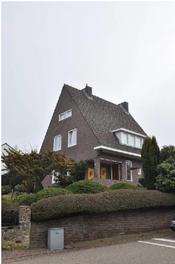
De voorgevel en rechter zijgevel
