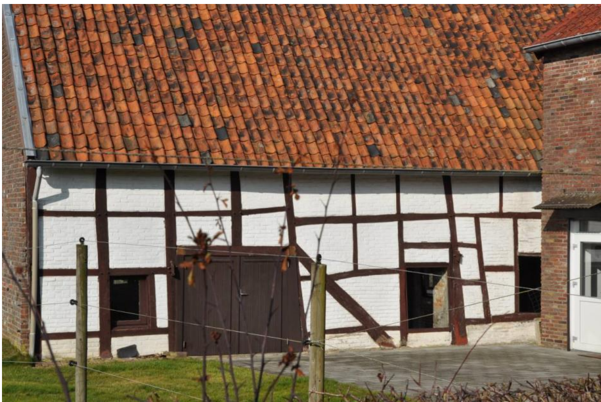
Detail van het vakwerk van de voorgevel: links de twee traveeën uit de 19 e eeuw, rechts twee traveeën van het 18 e -eeuwse deel (gaat deels schuil achter de moderne voorbouw)
