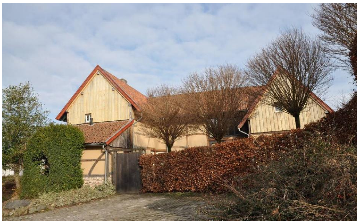
De zuidzijde met links de woonvleugel en rechts de haakse schuurvleugel
