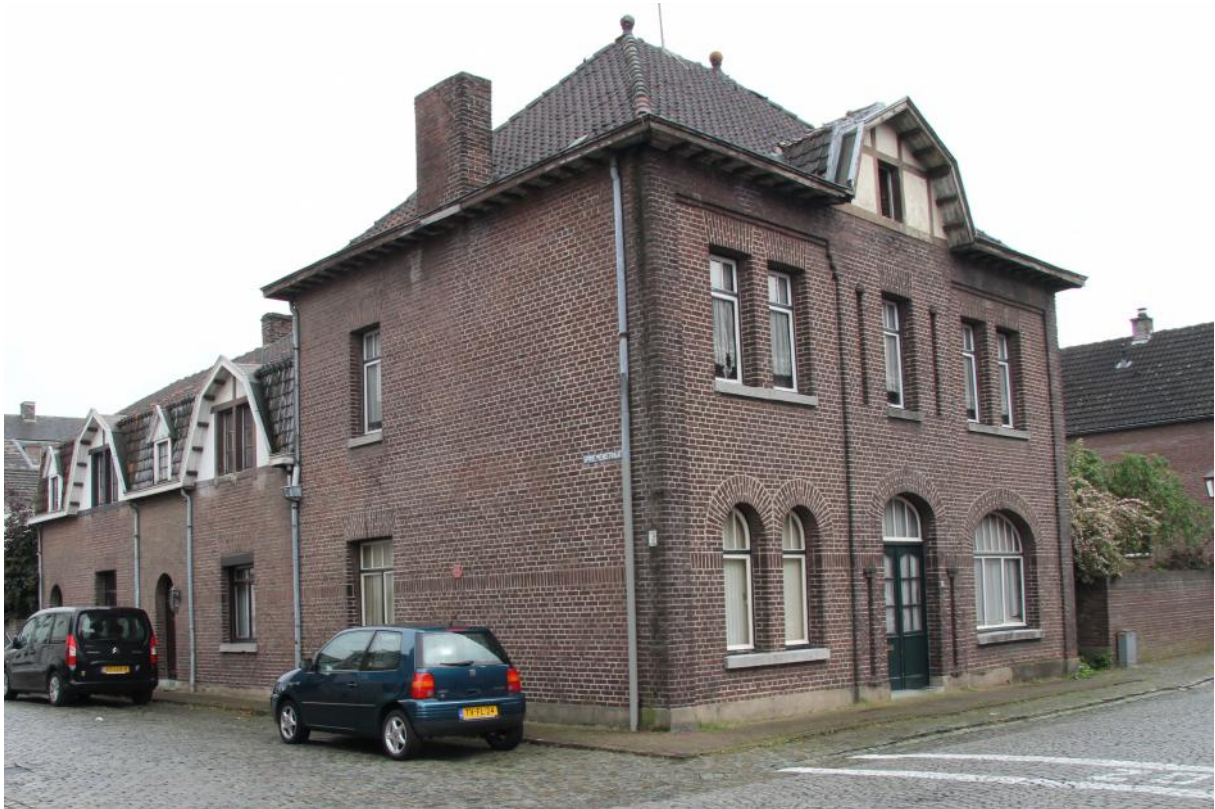
De voorgevel en linkerzijgevel van Vogelzang 1(rechts) en de voorgevel van Spriemelstraat 1-3 (links)
