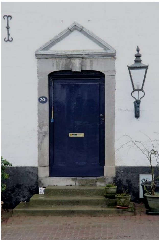
De hardsteen deuromlijsting en oude voordeur
