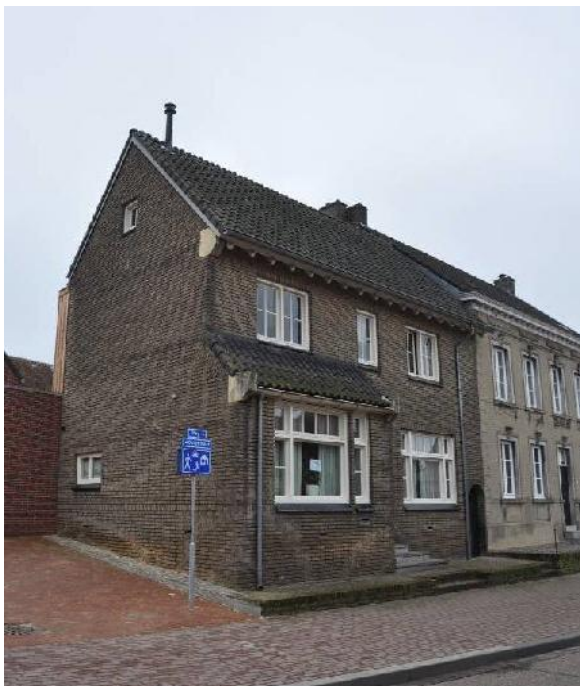
De linker zijgevel en de voorgevel
