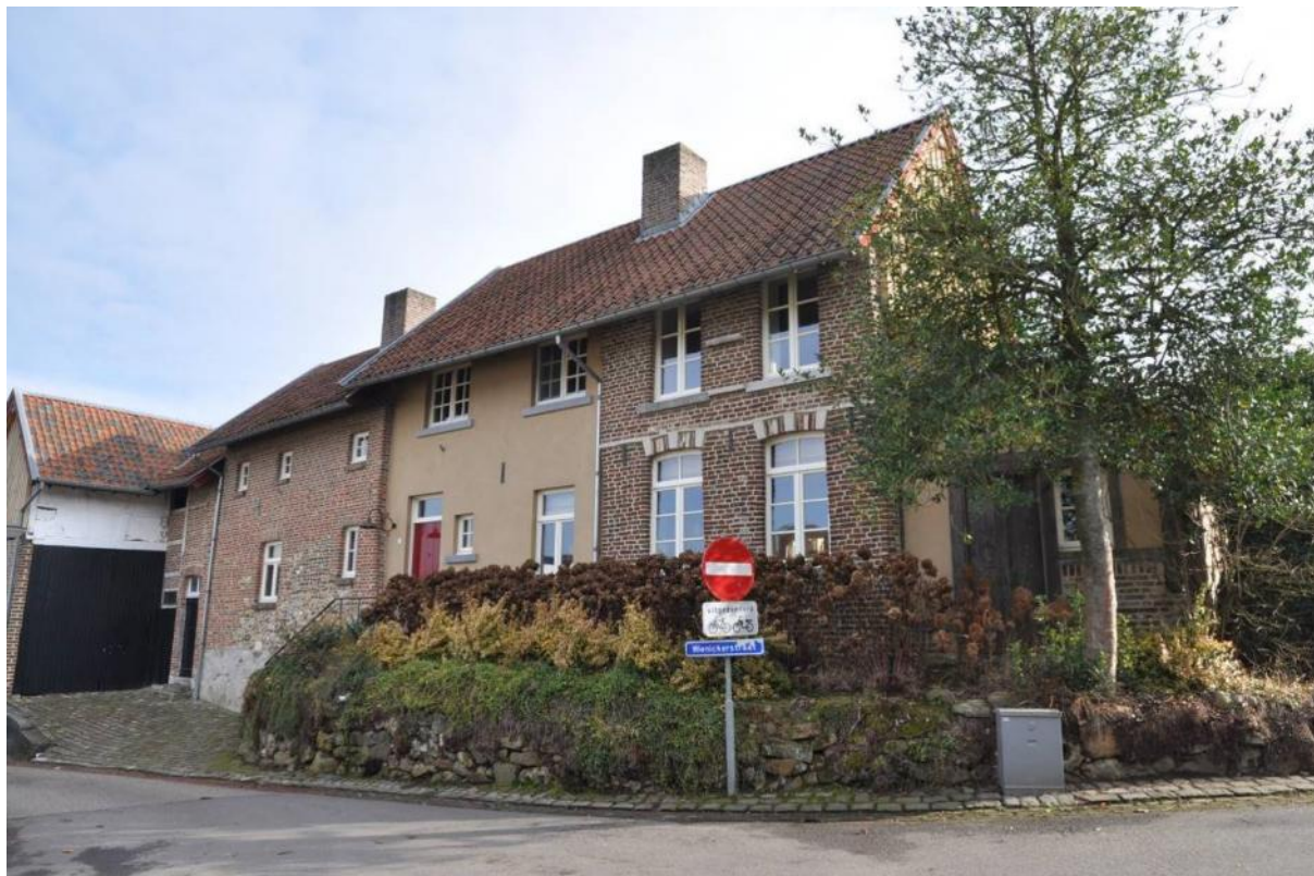
Wienickerstraat 4, woonvleugel aan de straatzijde
