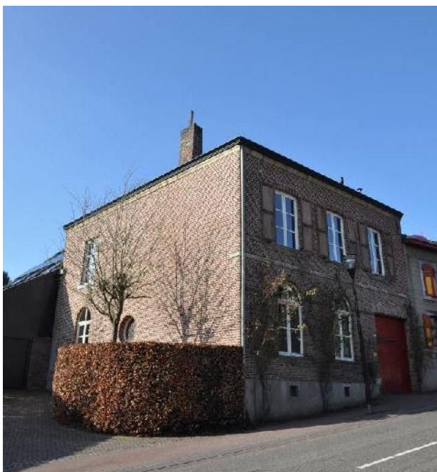
De linker zijgevel en de voorgevel
