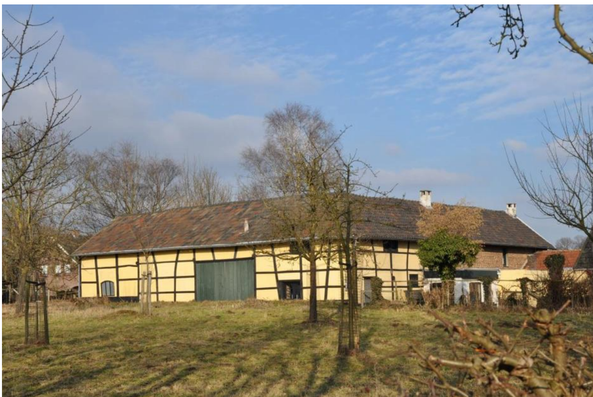
De vakwerkschuur van Honthem 33, rechts de linker zijgevel van het woonhuis in baksteen.
