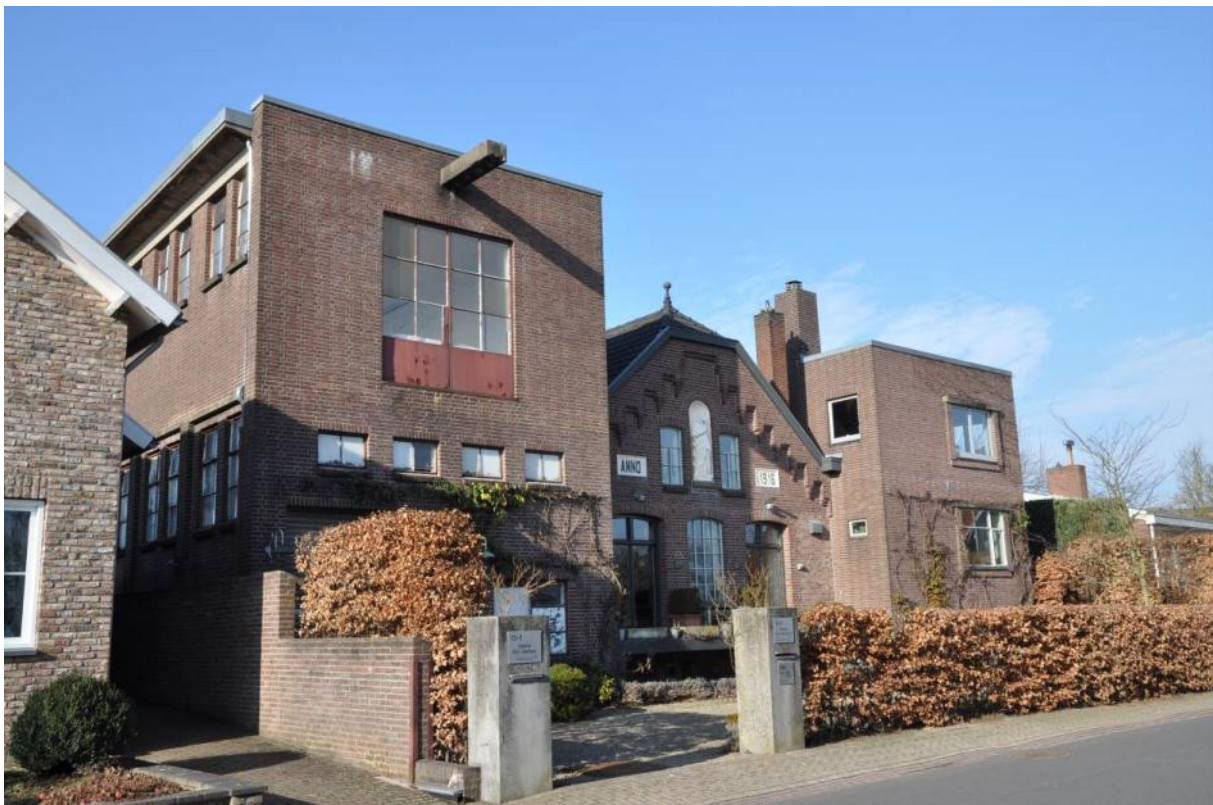
De voormalige melkfabriek St. Barbara: in het midden de vleugel uit 1916, geflankeerd door vleugels uit ca.1950
