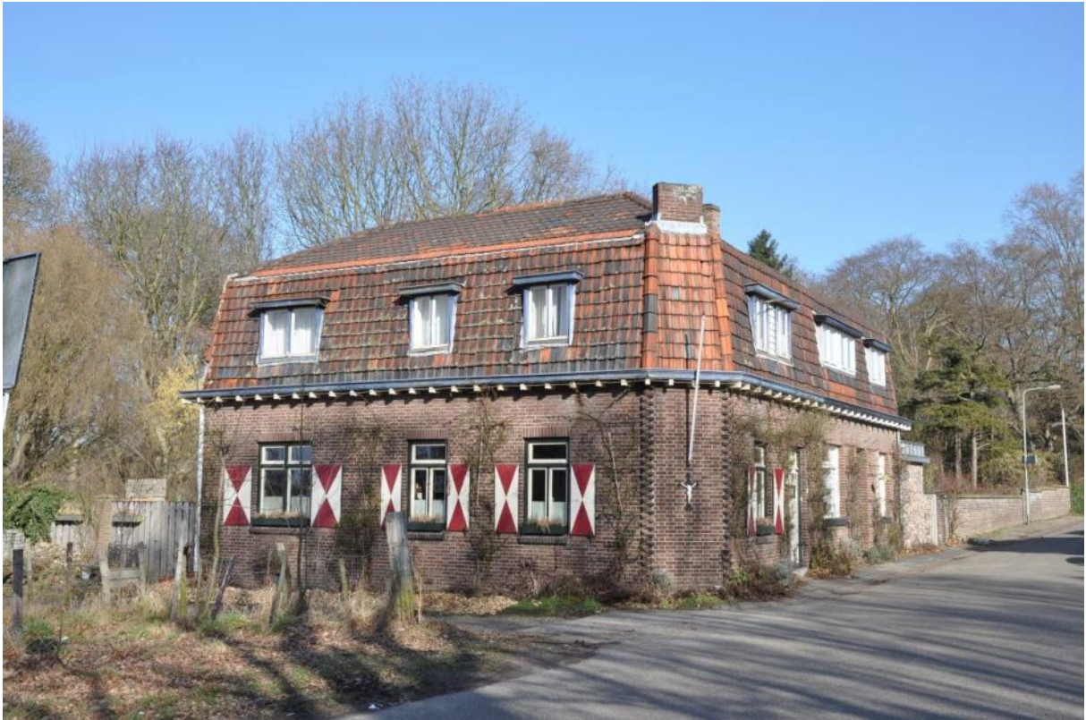
Stationsstraat 2-4, gezien vanuit het westen
