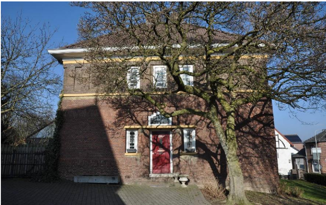
De zuidelijke (voor-)gevel
