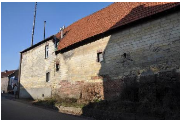
Zijgevel woonhuis en de zuidelijke vleugel
