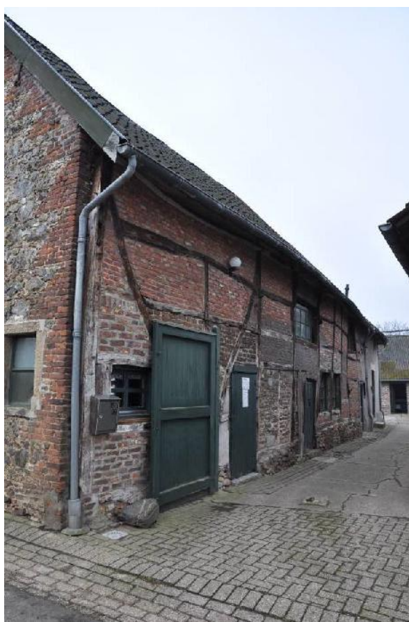
De noordelijke vakwerkgevel van de schuur
