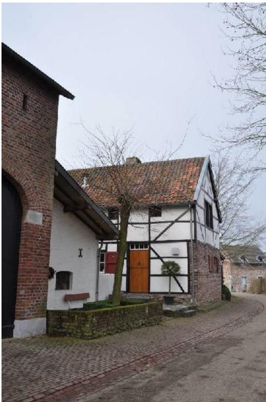
Het woonhuis en het bijgebouw (vooraan)
