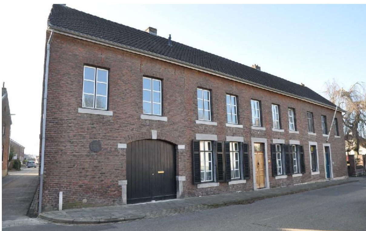
De voorgevel van Breusterstraat 16-18
