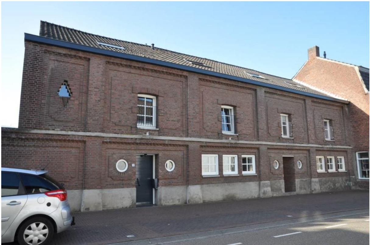
de voormalige paardenstallen
