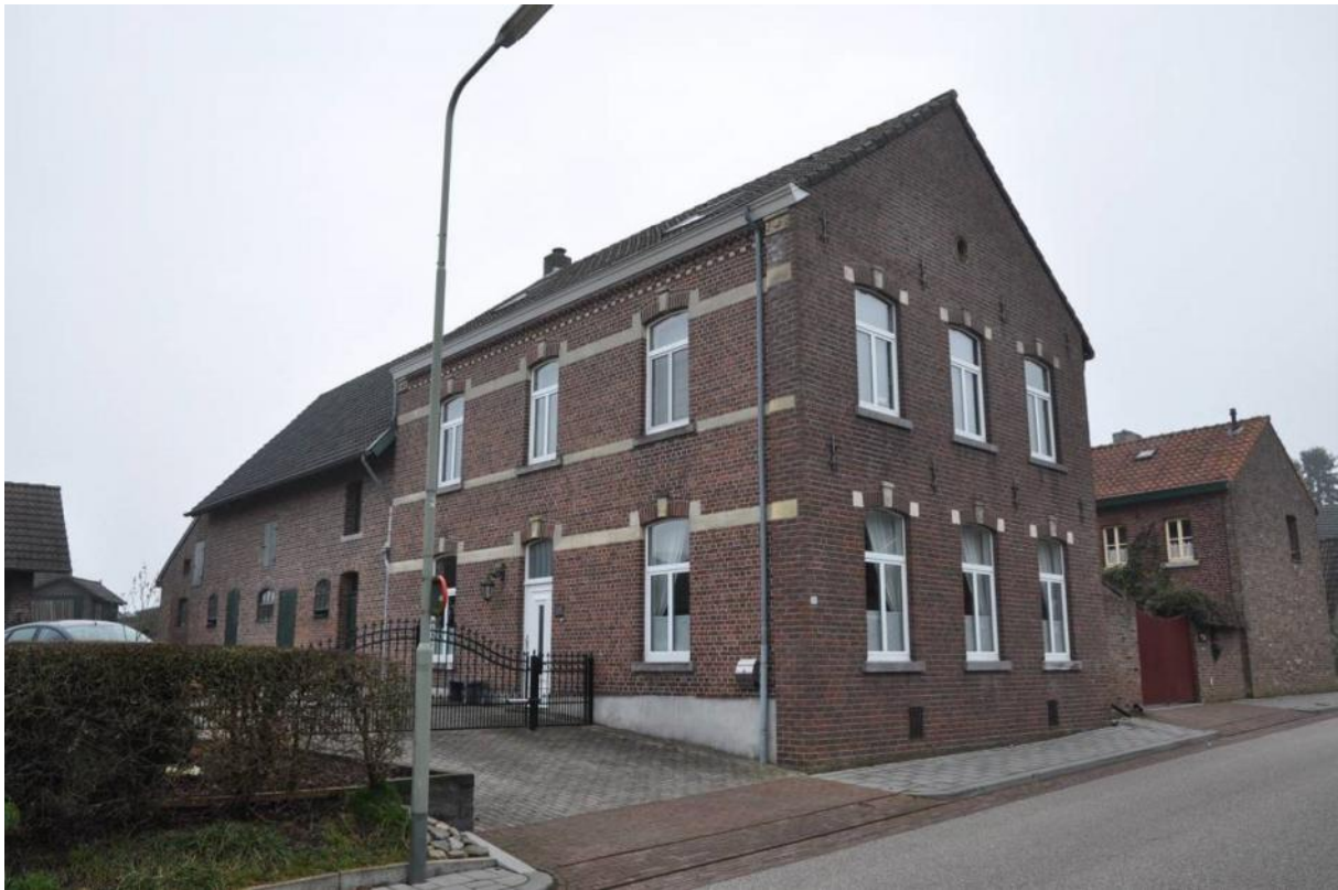
Termaar 31, vooraan het woonhuis, achteraan het stal/schuurgebouw
