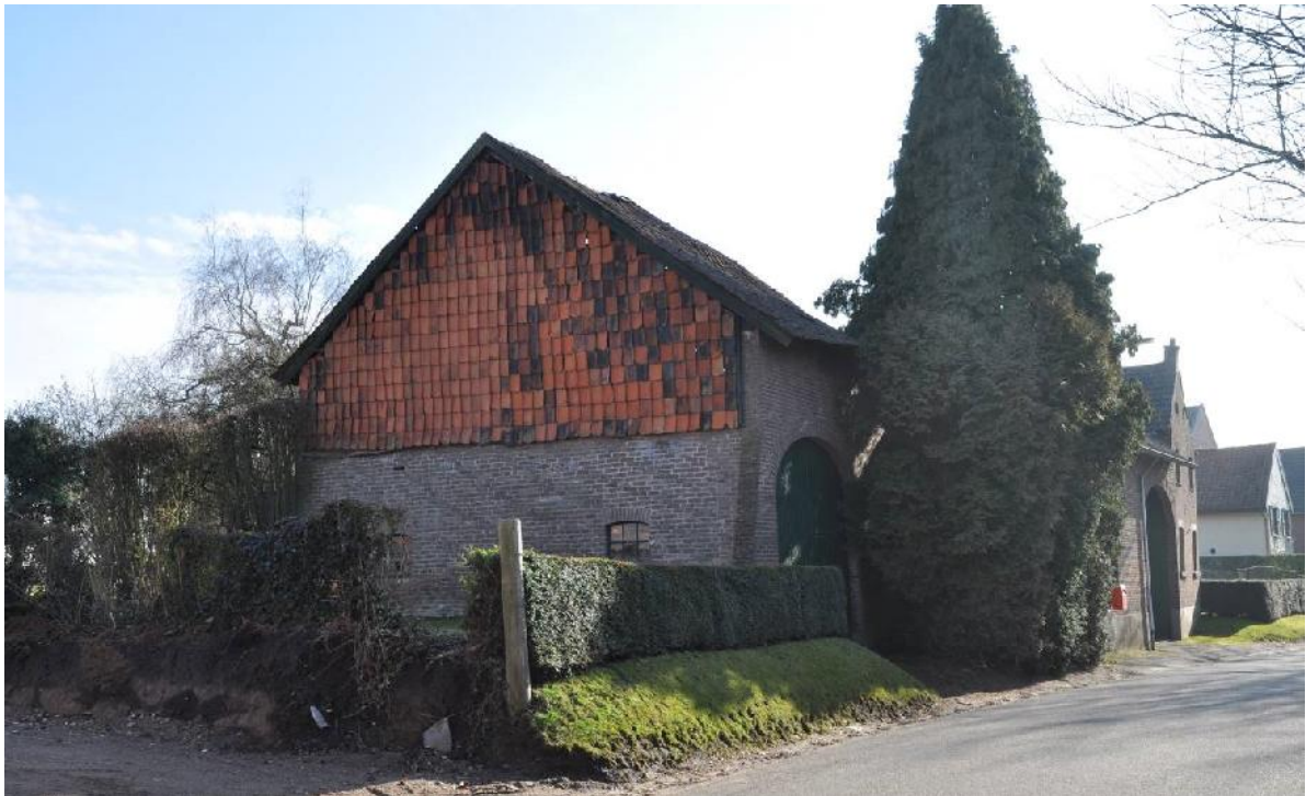
Bruisterbosch 19, de noordelijke schuur en rechts achter het woonhuis met poortvleugel
