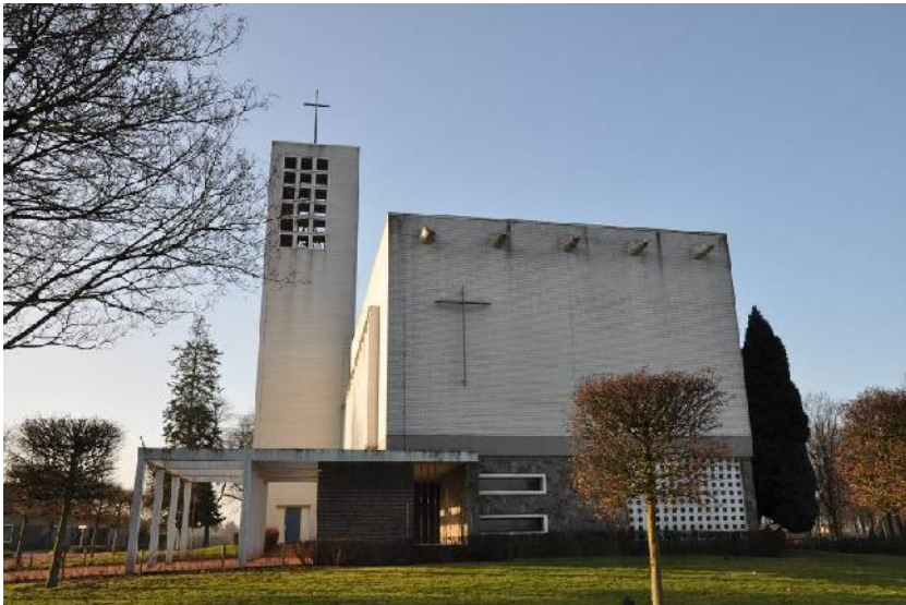
De noordgevel en links de luifel vóór de hoofdingang
