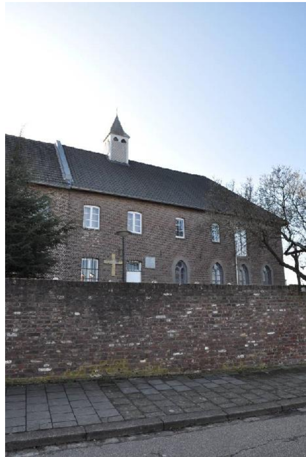
De noordelijke zijgevel van het kloostergebouw
