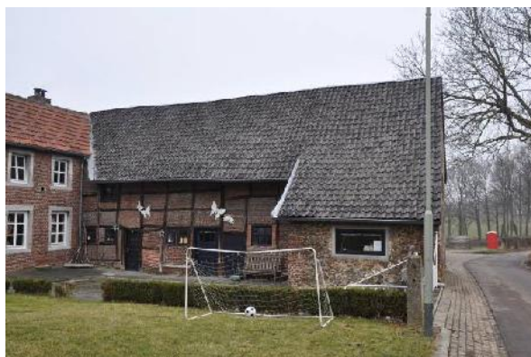
De schuurvleugel met de aanbouw (zuidzijde)
