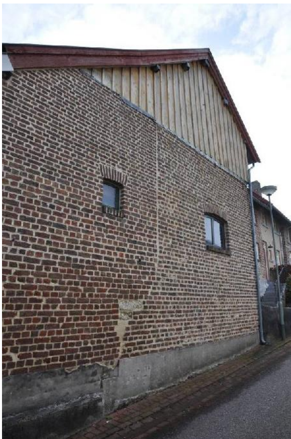
De straatgevel van de linker schuur
