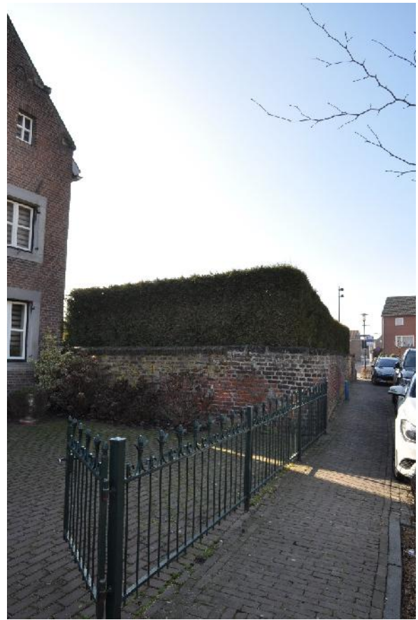
Muur vanuit het oosten
