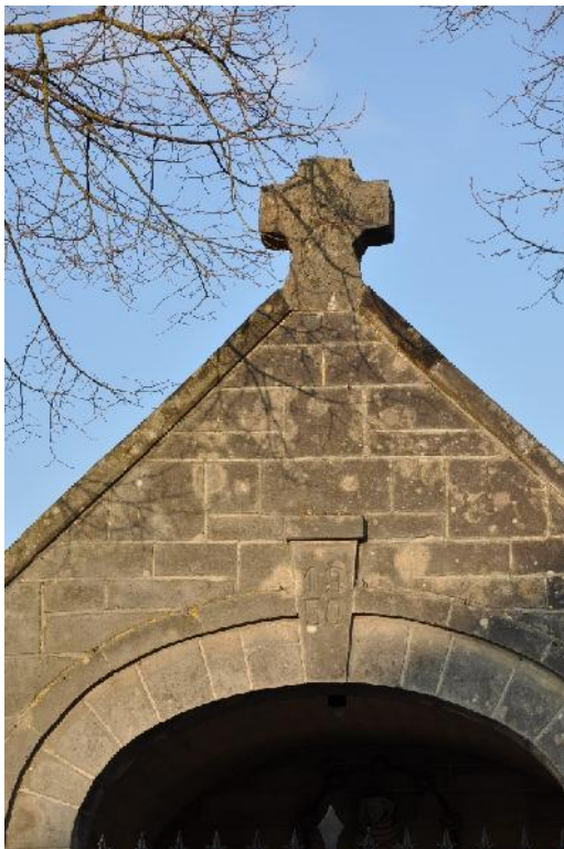
Detail kruis topgevel
