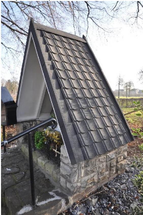
Dak en plint
