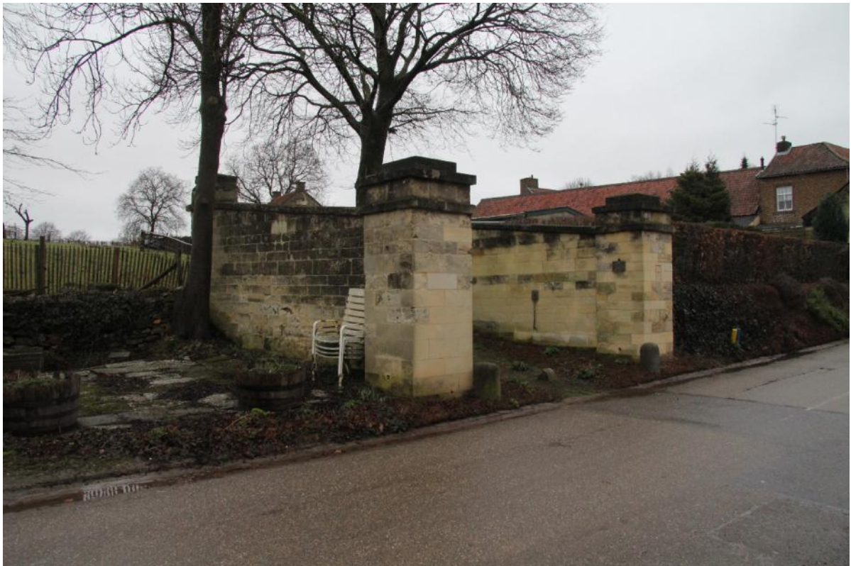
De pijlers met keermuren vanaf straatzijde
