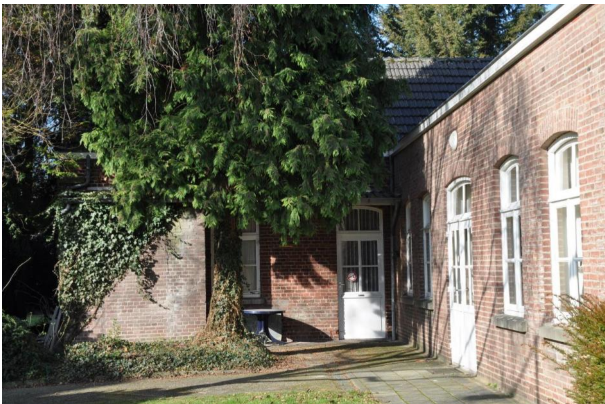
Het bijgebouw (achterste vleugel) uit 1912
