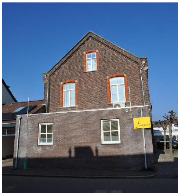
De zuidgevel en de moderne aanbouw (nr.5)
