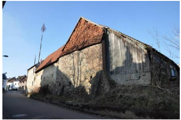
De oostelijke schuur met het breukstenen muurwerk
