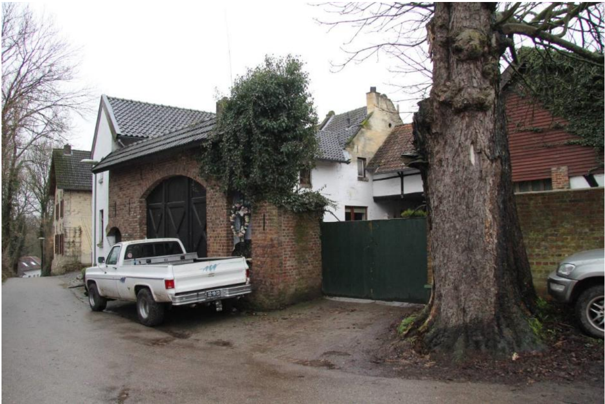
De carréhoeve Groot Welsden 116 met poortgevel aan de straat
