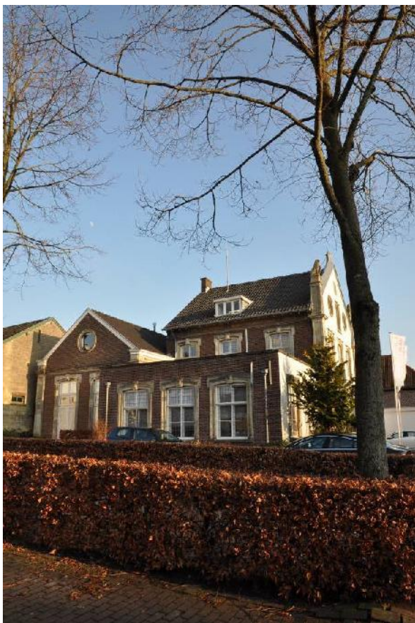
De school (links) en de aanbouw uit 1954
