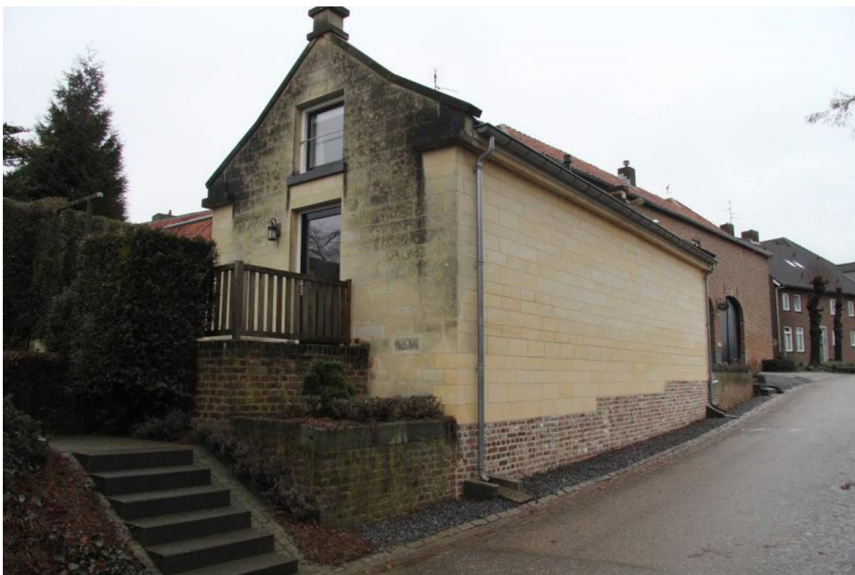
Het mergelstenen bijgebouw aan de straatzijde
