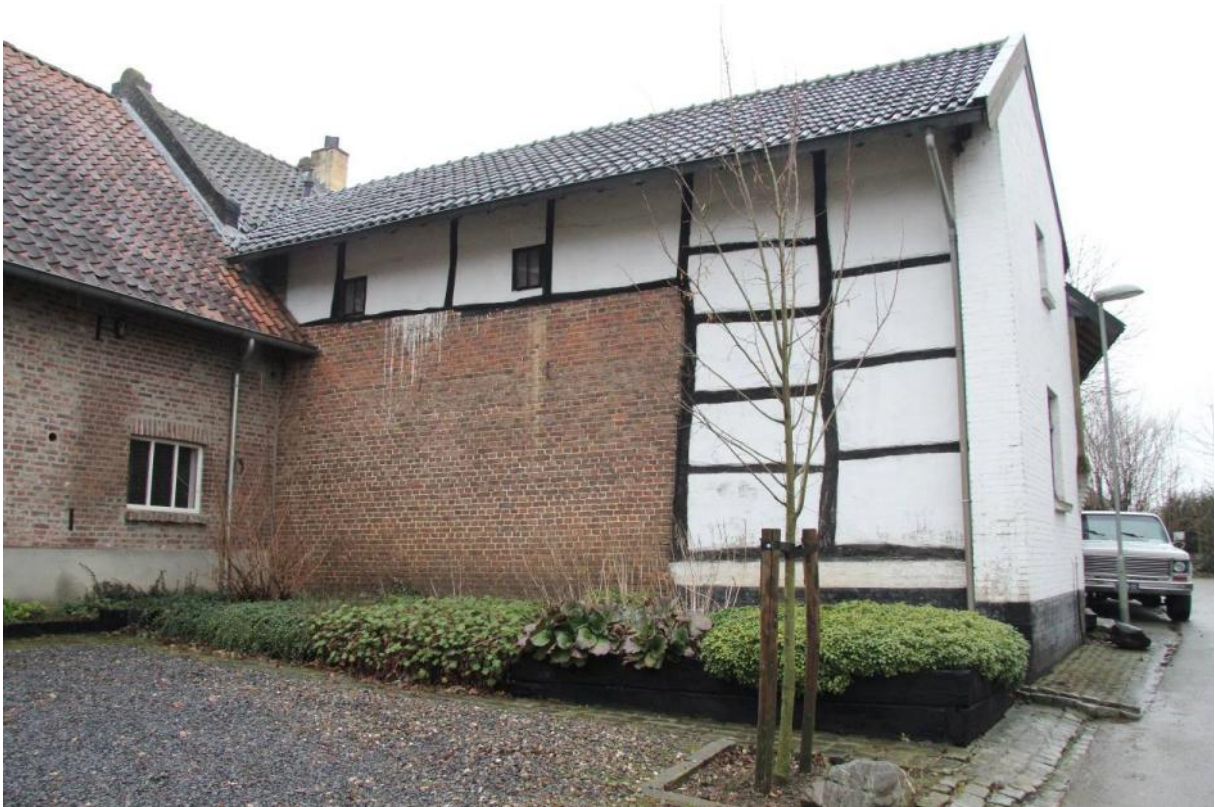
De zijgevel van de dwarsvleugel
