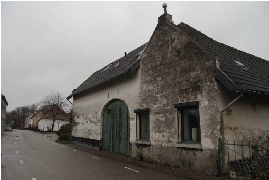
De poortvleugel (links) en de haakse woonvleugel (rechts)
