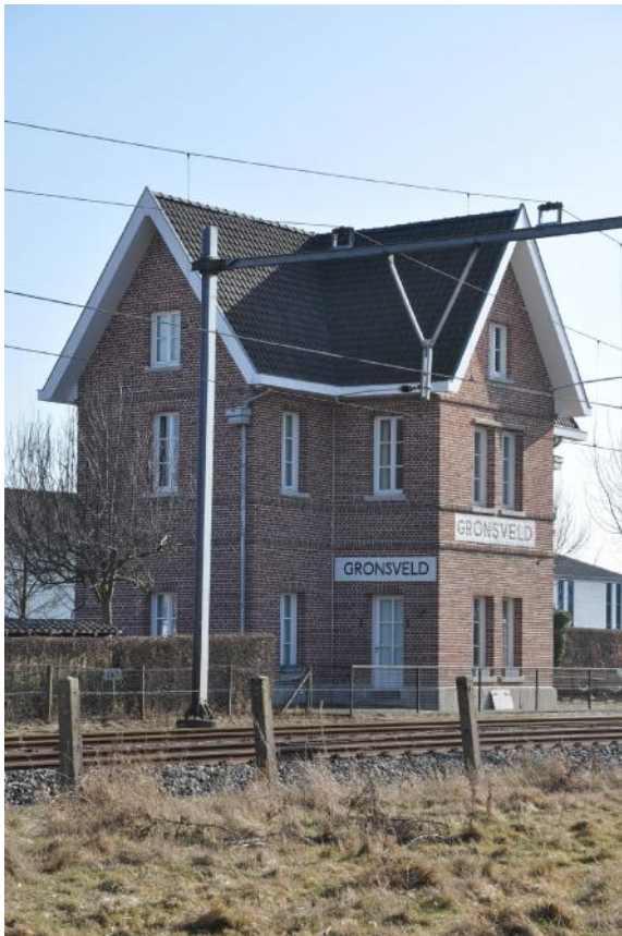
Het voormalige station aan de spoorzijde
