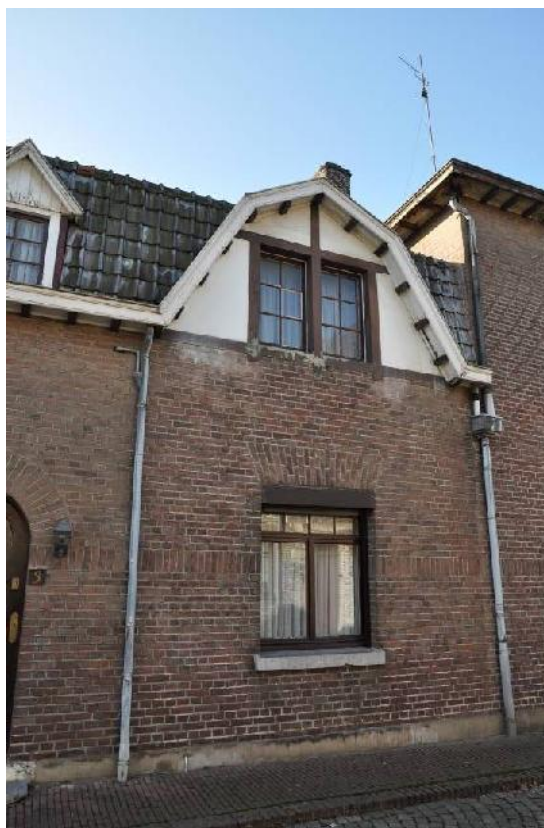
Detail van een topgevel van Spriemenstraat 3
