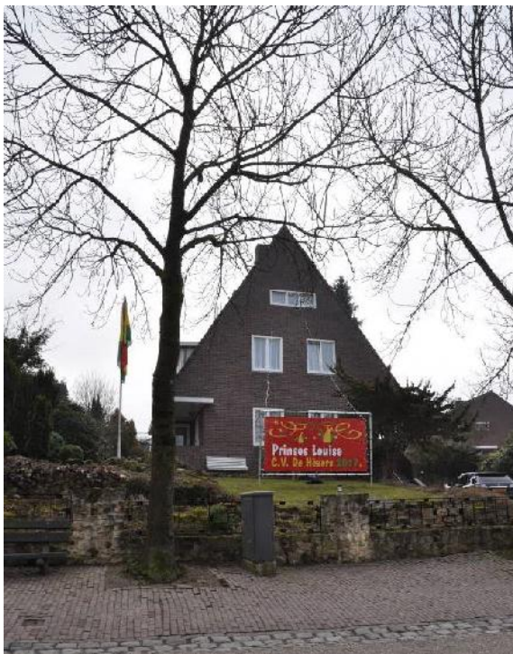
De voorgevel en de erfafscheiding
