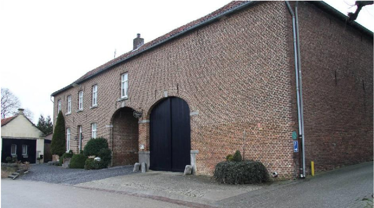
De straatvleugel van de hoeve Groot Welsden 9-11
