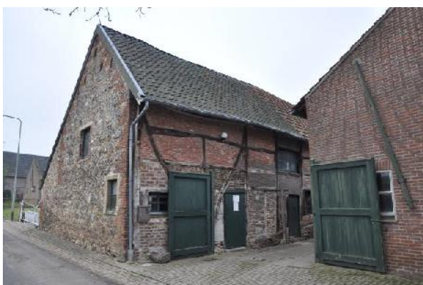
De topgevel en de noordelijke gevel van de schuur
