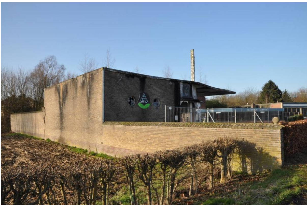
De achtergevel en de tuinmuur
