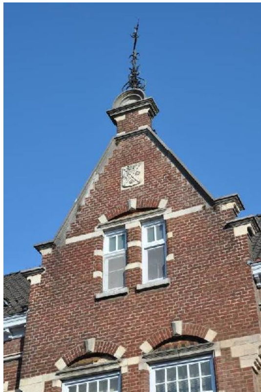
De topgevel van de middenrisaliet
