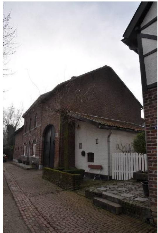
Het bijgebouw tegen nr.4
