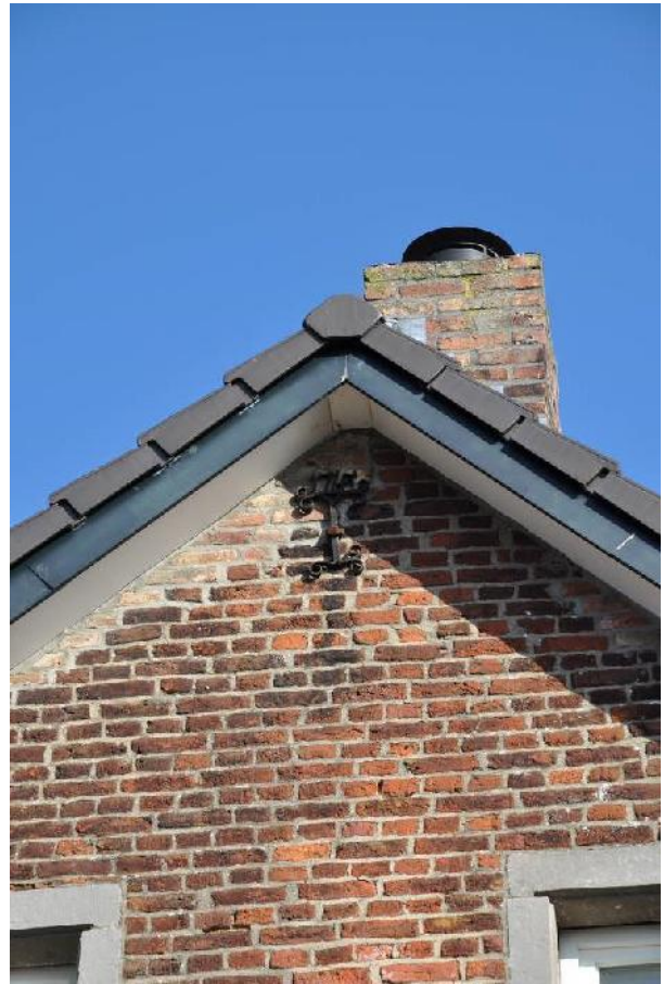
Detail van het jaaranker 1765 in de geveltop
