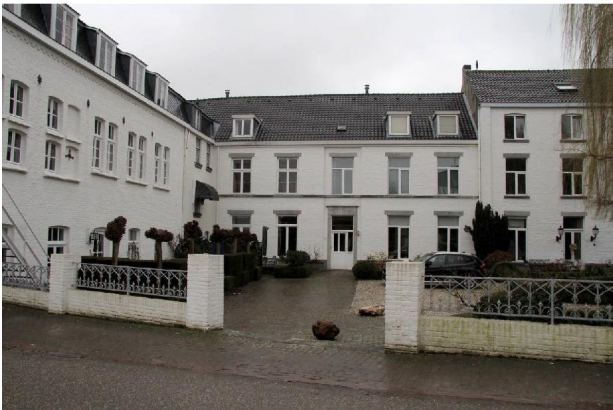
Detail van het noordelijke deel van de middenvleugel
