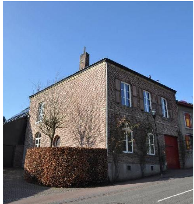
De linker zijgevel en de voorgevel
