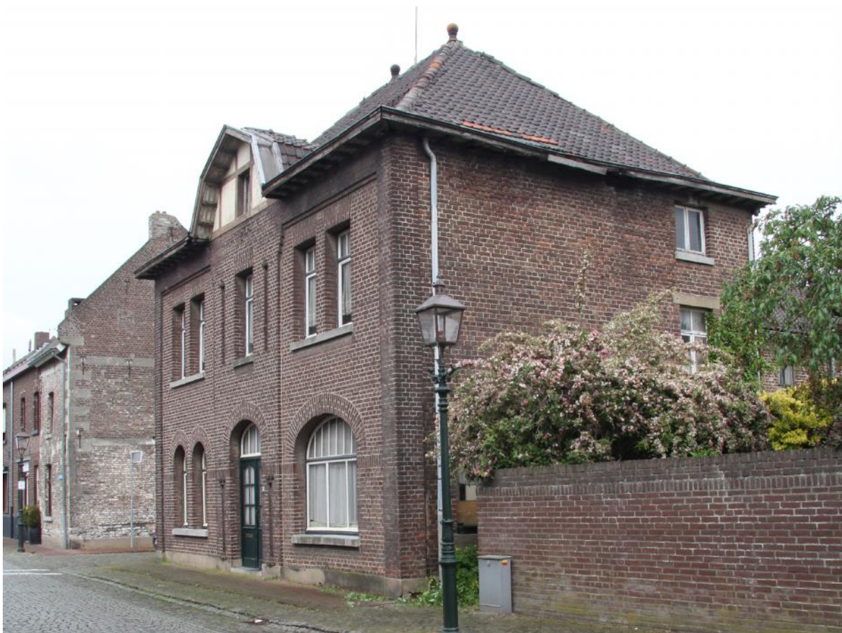
De voorgevel en rechterzijgevel van Vogelzang 1
