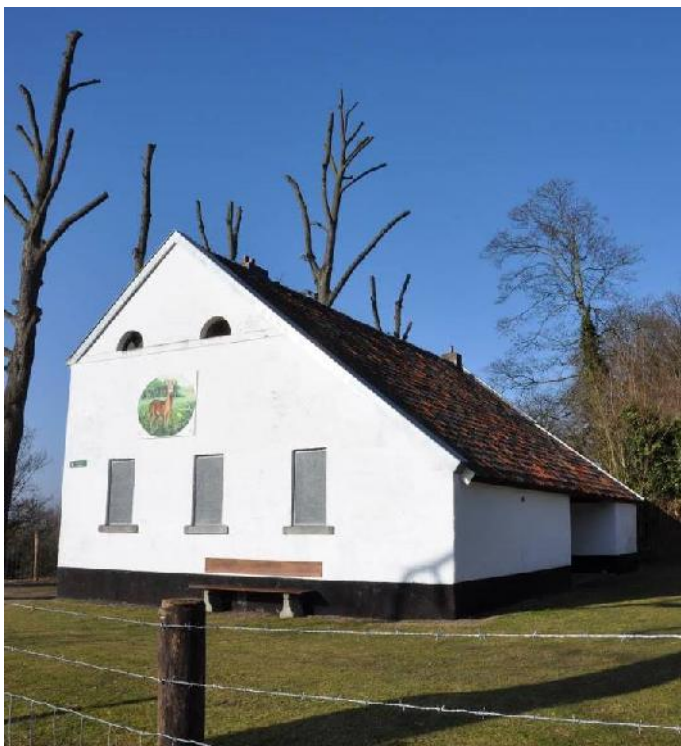
De rechter zijgevel en achterzijde
