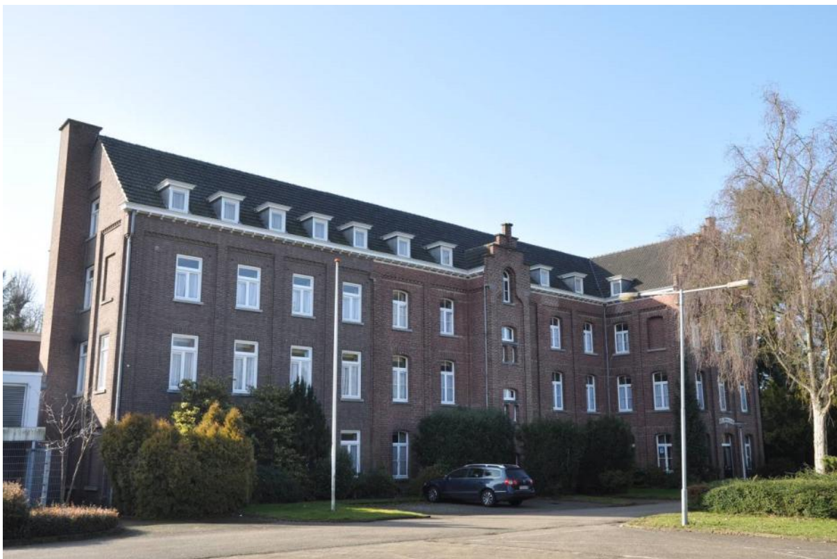
De noordzijde met links de vier traveeën uit 1937 en rechts de zes traveeën uit 1912
