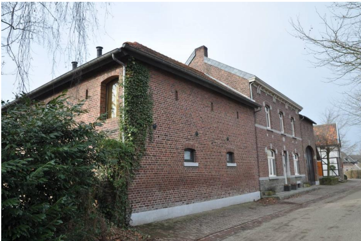
De hoeve gezien vanuit het oosten: in het midden het woonhuis en links de schuur en rechts het poortgebouw
