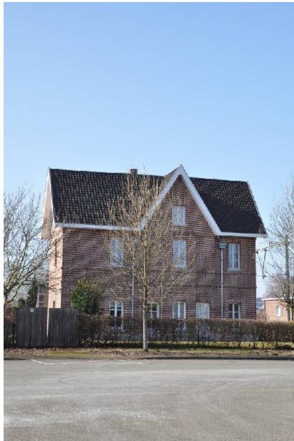
De achtergevel van het station
