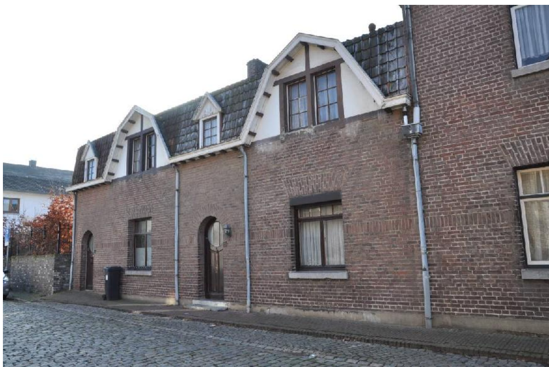
De voorgevel van Spriemenstraat 1-3
