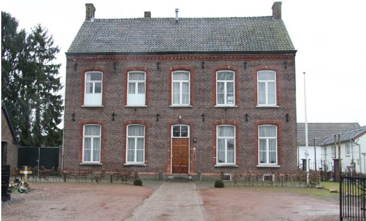
De voorgevel van de pastorie, die gericht is op de Sint Laurentiuskerk en het naastgelegen kerkhof
