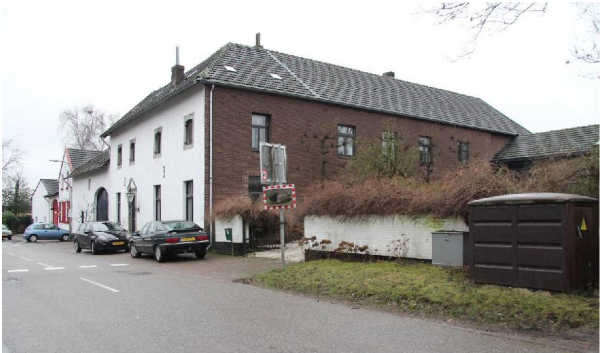
De vernieuwde zijgevel (klampmuur) uit ca.1950
