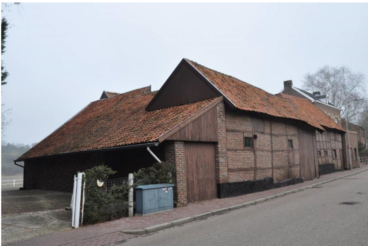
Overzicht van de hoeve vanuit het westen: links de westvleugel, in het midden de zuidelijke poortvleugel en geheel rechts de oostelijke vleugel. Op de achtergrond de dakpunt van de noordelijke woonvleugel
