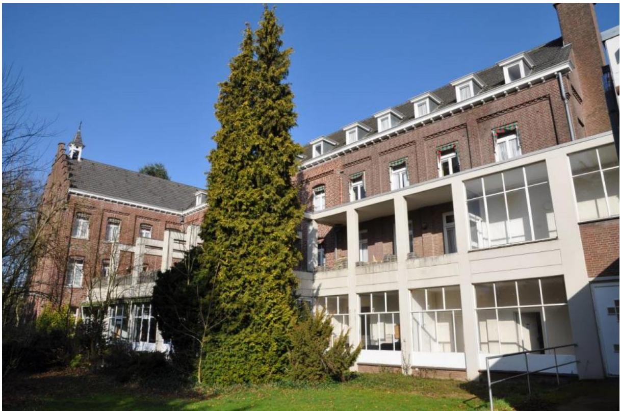
De zuidzijde met links de westelijke vleugel en rechts de oostelijke vleugel met veranda uit 1960
