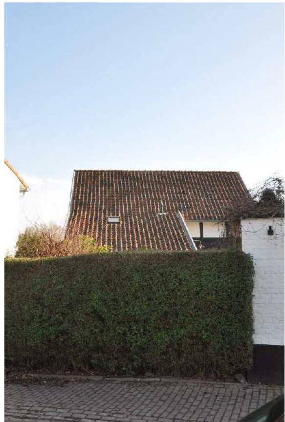
De vakwerkschuur op het achterterrein
