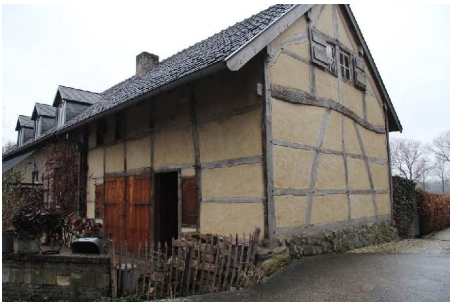
De voormalige schuur (rechts)
