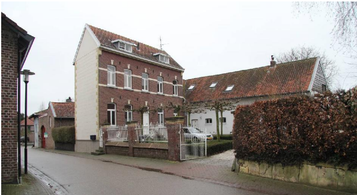
Groot Welsden 94, links het woonhuis, rechts het stal/schuurgebouw
