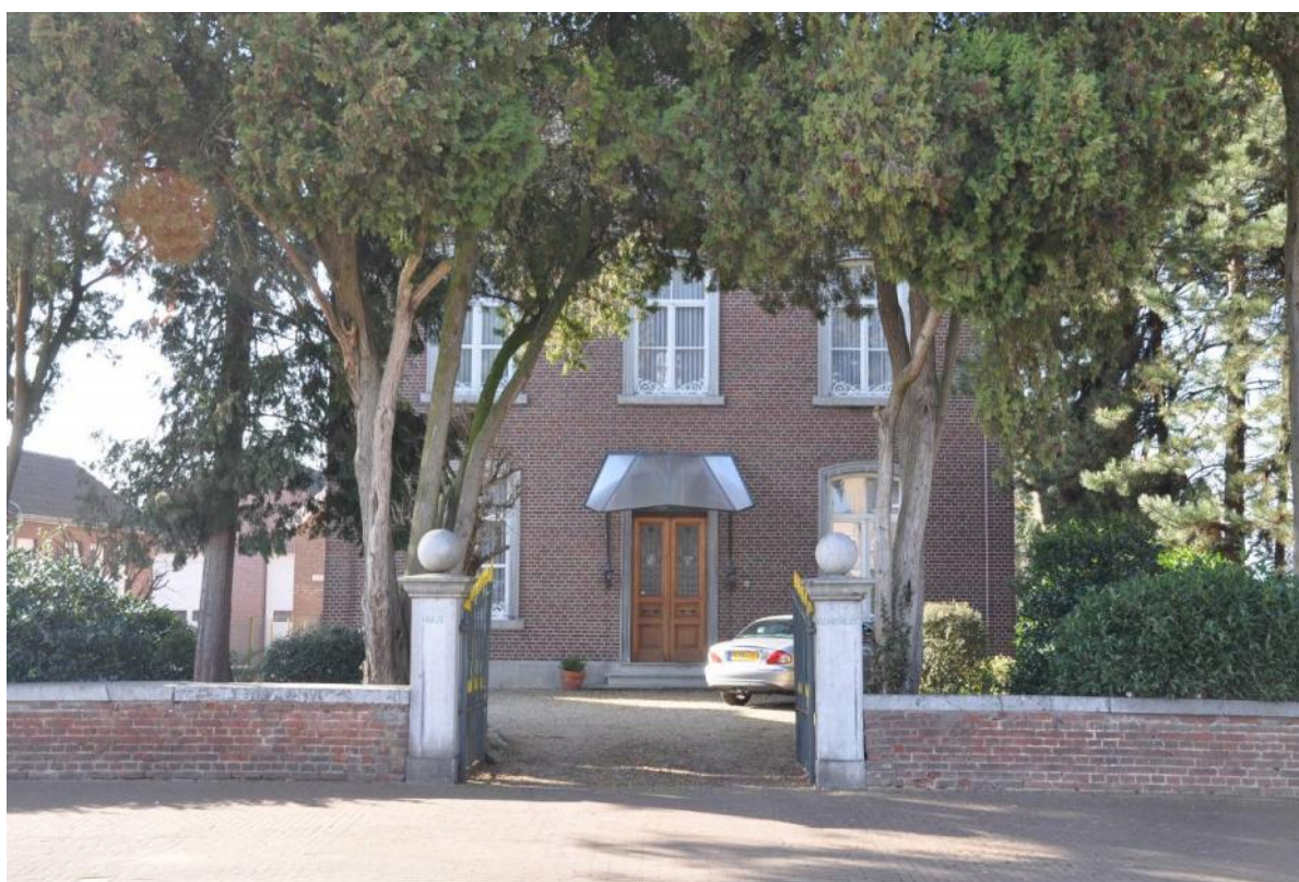
Detail van de begane grond en de tuinmuur met kolommen en hekwerk
