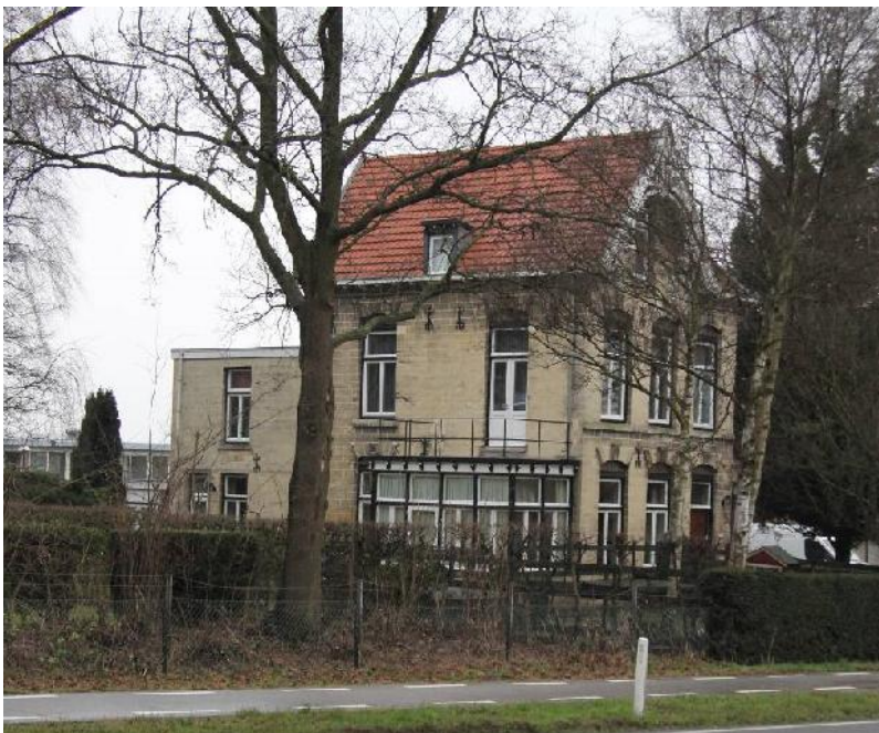
De linker zijgevel met serre en links de achterbouw
