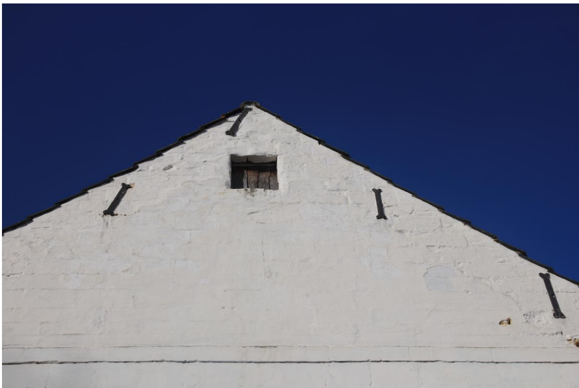
Foto 5: De pannen op de kopgevel zijn zeer strak afgewerkt tegen de buitenmuur. Ook is de afdichting van de schuur met houten planken goed zichtbaar. Dit belet vleermuizen, maar ook de kerkuil tot toegang.
