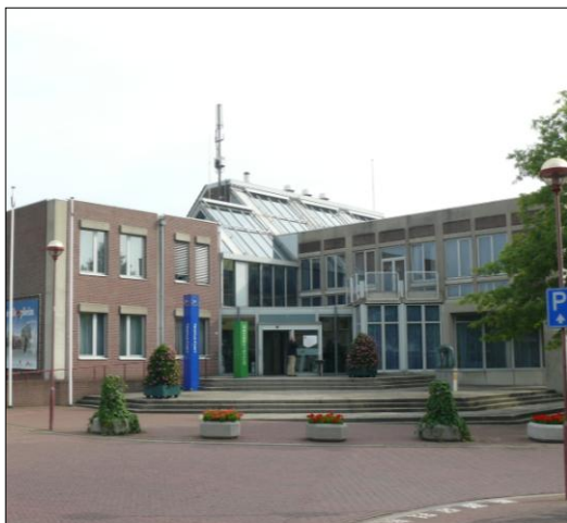
entree bestaande gemeentehuis
