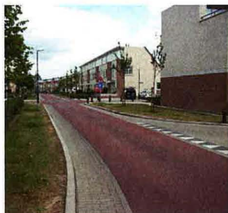
Fietsstraat Stuwmeer in Houten
