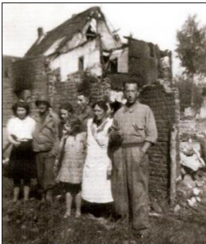
Fig.7 Op de achtergrond de op 12 september 1944 in brand geschoten woning aan de Terlinderstraat-Provinciale weg. Bron: L. Wolters, Terlinden. Portret van een gehucht (z.p. 2008) 119
