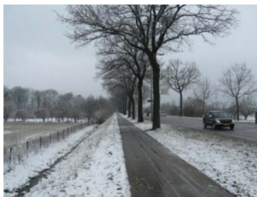
Figuur 6: Verhoogd gelegen N278 ten oosten van de Vruchtenhof, gezien in westelijke richting.
