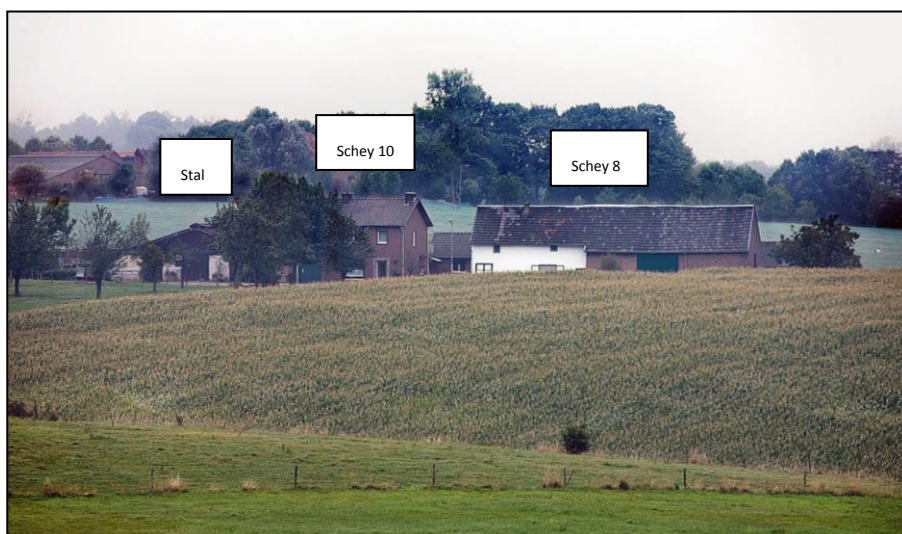
Foto bestaande situatie Schey 8-10
