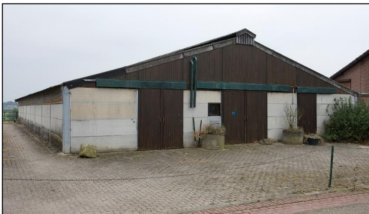
Foto te slopen rundveestal
