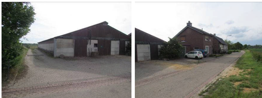
De te saneren stal (links) en de naastgelegen woningen in Opschey.
