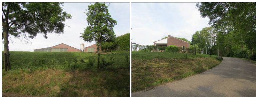
Topgevels aan de weg Vroelen; de huidige stallen (links) en de bedrijfswoning.
