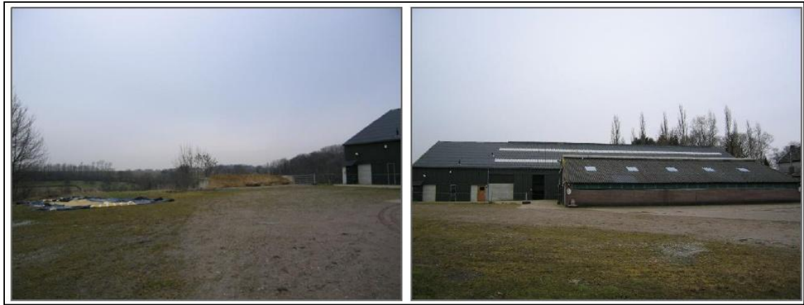
Foto's bestaande situatie
