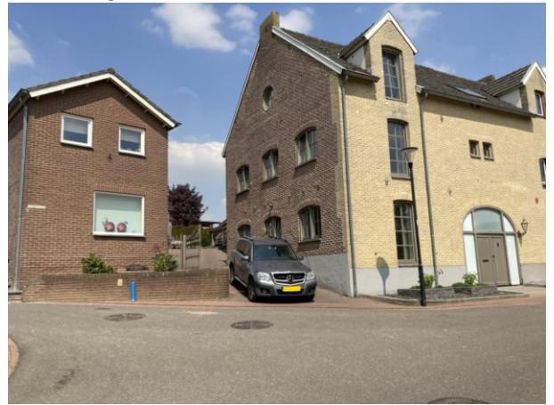
Foto 6 Aanzicht woning vanuit de straat Banholtergrubbe
