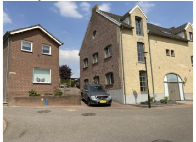
Foto 6 Aanzicht woning vanuit de straat Banholtergrubbe
