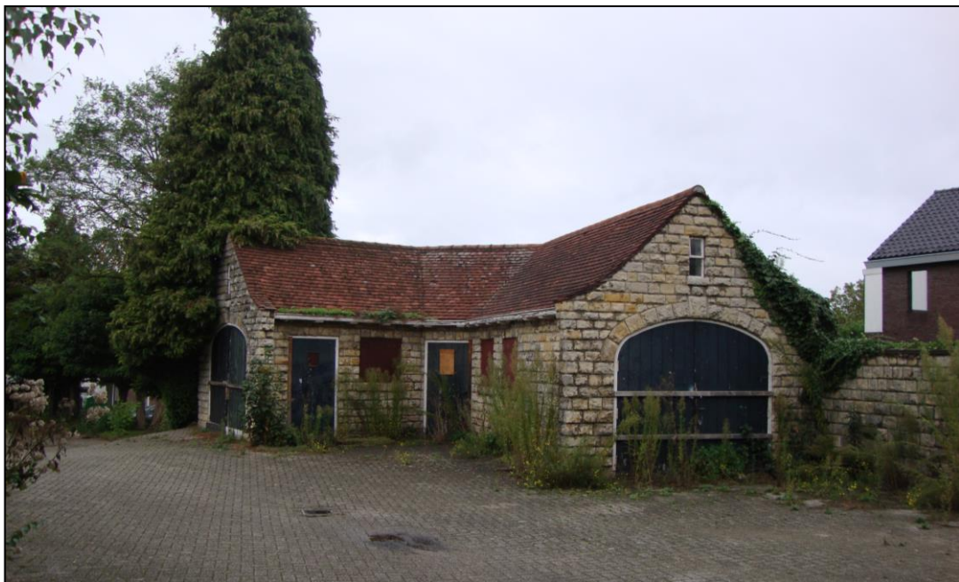
Oude schuurgebouw ter plaatse van de toegang tot het Europapark
