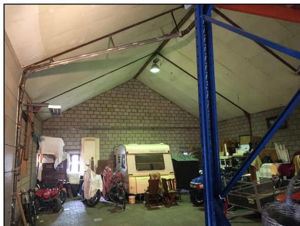
Foto 4: Binnenzijde te slopen schuur
