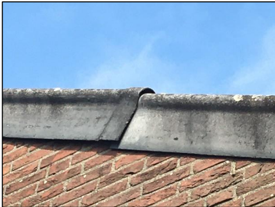
Foto 1: Opening onder dakleer (toegang tot de spouw)
