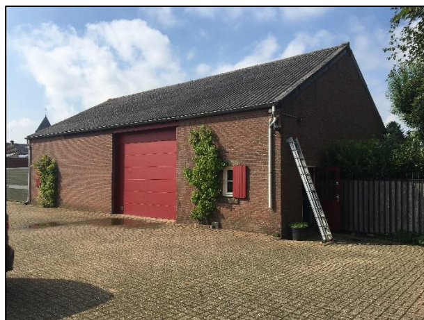
Foto 6: Te slopen schuur vanuit zuidoosten
