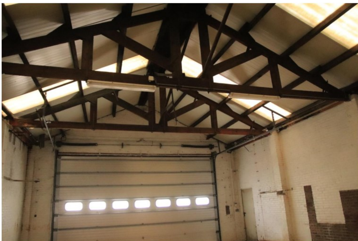
Foto 2: In de loods is het aanwezig zijn van vaste rust- en verblijfplaatsen uit te sluiten, vanwege de bouwstijl ervan. De metalen platen op het dak worden bovendien te warm om als zodanig te dienen
