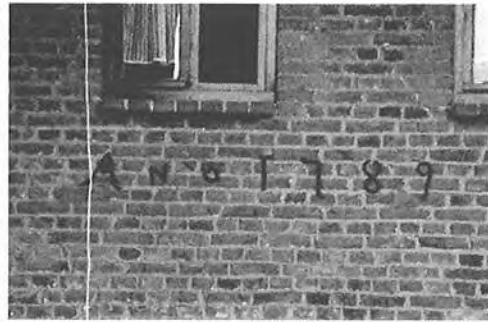
Figuur 5.41 Stallestraat 18, smeedijzeren datering
