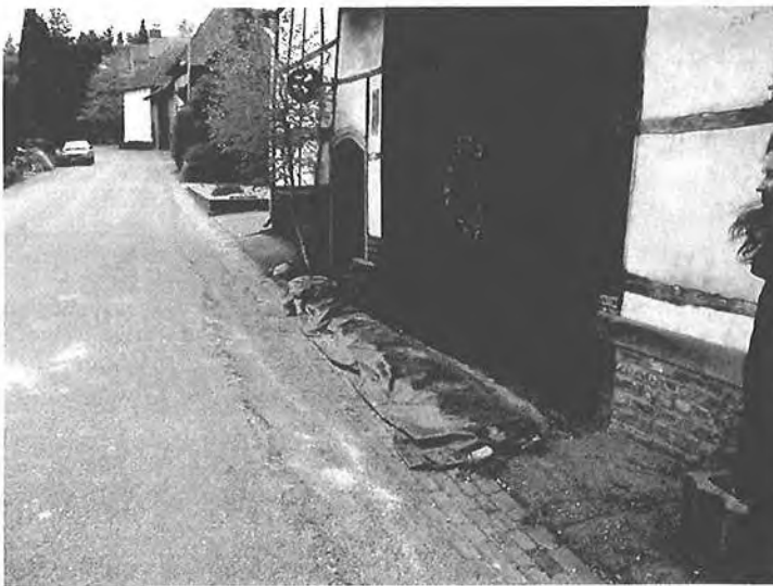
Fig. 5.13 Het profiel van de Stallestraat is in de loop der tijd van hol naar bol geëvolueerd
