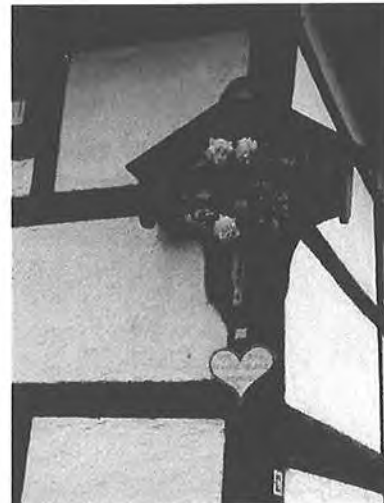
Figuur 5.31 Kruisbeeld aan de muur van Stallestraat 12
