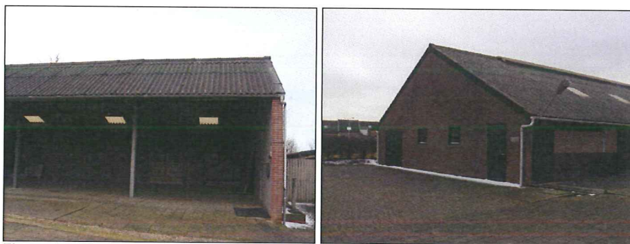
Figuur 1 en 2 impressie te slopen kapschuur en voormalige melkveestal te Cadier en Keer.
