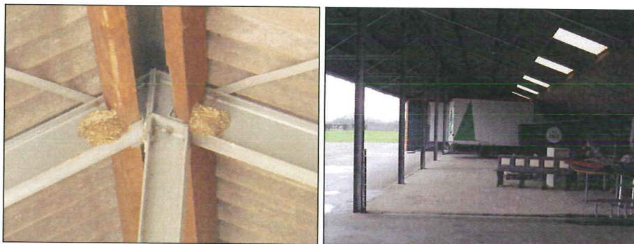
Figuur 3 en 4 nesten van boerenwaluw in de te slopen kapschuur
