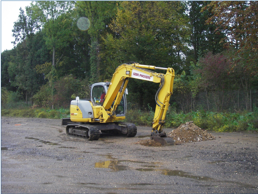
Figuur 7. Verwijdering van de dikke grindlaag in het noorden van het plangebied.
