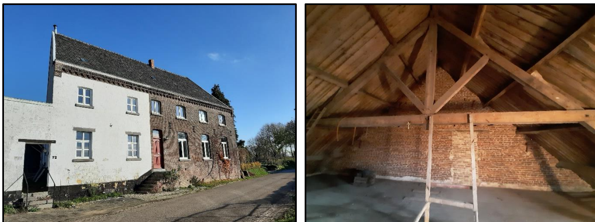
Figuur 2.5 situatie van de woning (witte deel) aan de buitenzijde en aan de binnenzijde.
