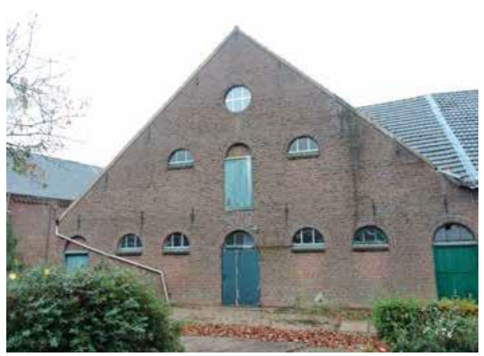
10. Zowel aan de aansluiting van het dak als aan de staande naad helemaal rechts is te zien dat de beide bouwdelen van de grote stal onafhankelijk van elkaar zijn neergezet
