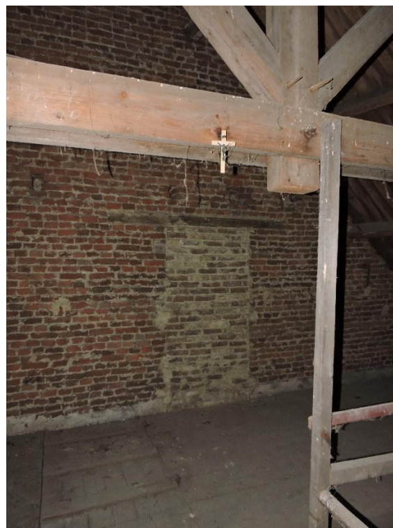
Figuur 31 Een dichtgemetselde doorgang naar no. 70
