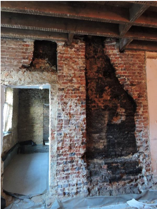
Figuur 11 De wand tussen keuken en bijkeuken met de schouw van in de muur van rond 1920. Links de secundaire schoorsteen en de nog weer latere deuropening met de betonnen lateibalk
