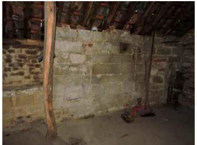
70. De eerdere deling wordt gemarkeerd door de ophoging van de tussenmuur, aanvankelijk de buitenmuur van het oude huis
