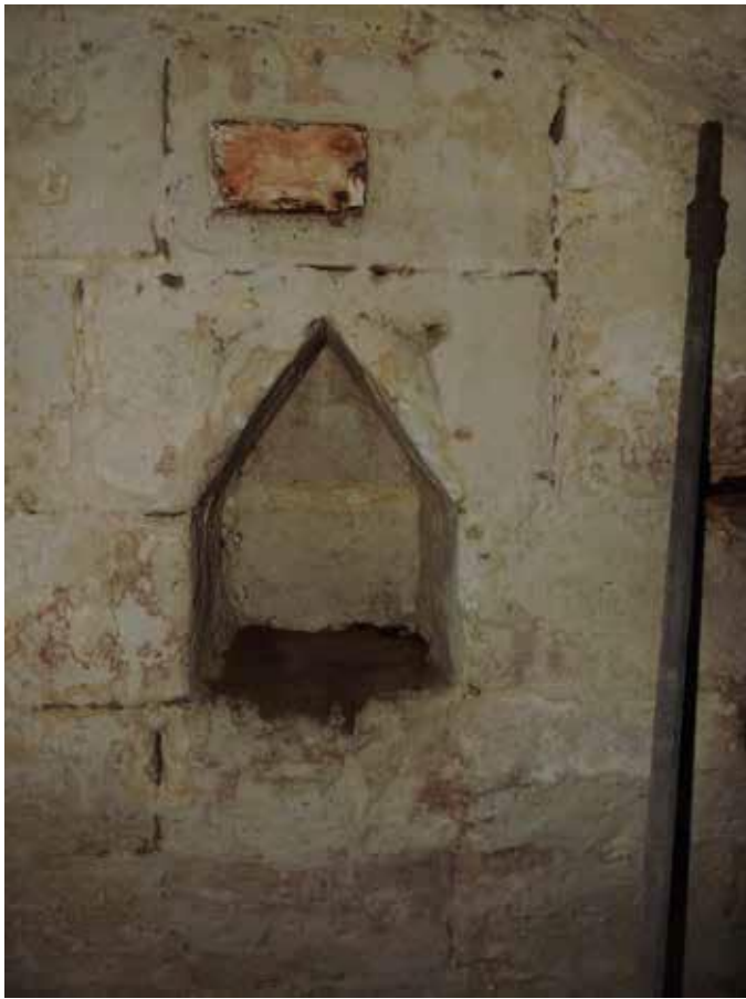
47. De lamprnissen aan beide zijden hebben een lichte versiering die laat-gotisch is, waarmee de kelder te dateren is in de late 16 de eeuw
