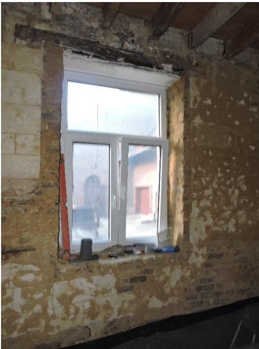
Figuur 20 Raam in de bijkeuken met duidelijke sporen van in- en aanpassing in bestaand muurwerk
