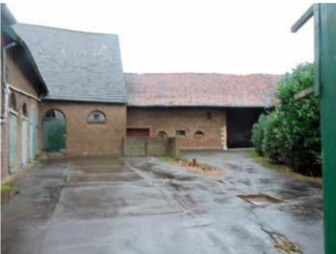
20. Op de achtergrond de oorspronkelijke stal, die gekenmerkt wordt door het restant van een hoekketting in mergel. (De foto is gemaakt in de stromende regen!)
