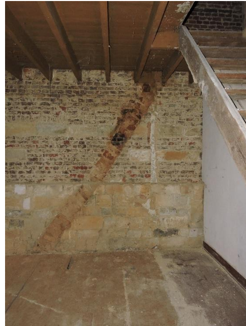
Figuur 27 Het secundaire schoorsteenkanaal in de muur aan de courzijde
