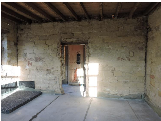
Figuur 6 Blik vanaf de straatkant naar de muur die de kamer scheidt van het halletje. Ook hier een secundaire met dito materiaal opgetrokken muur die geen verbinding heeft met de buitenmuren
