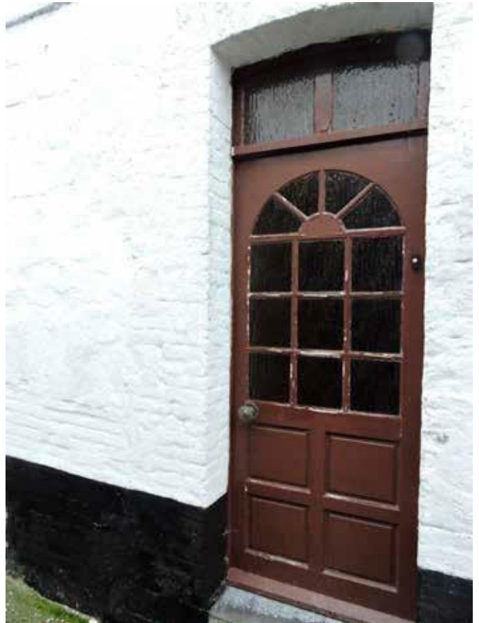
31. De voordeur die vrijwel op de plaats zit van de oorspronkelijke deur, maar zelf is vernieuwd rond 1950. De opening is vernieuwd in baksteen. De verbouwing is waarschijnlijk eigenmachtig doorgevoerd, tekeningen ontbreken.
