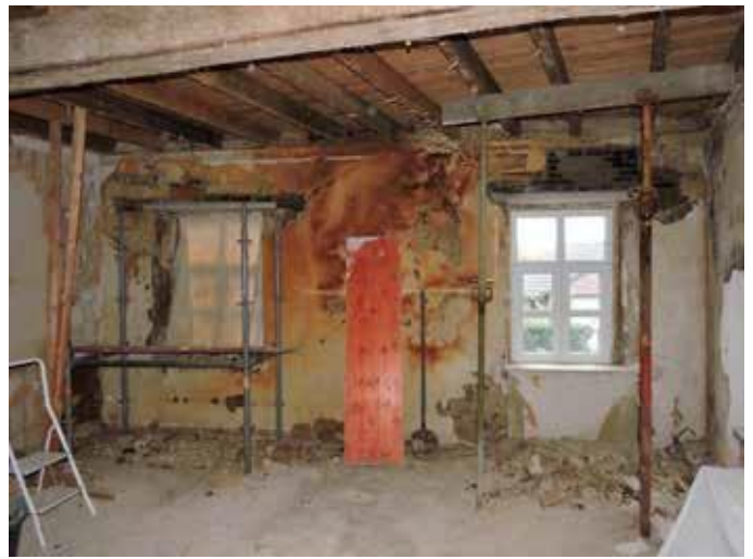
48. De kamer aan de straat die mogelijk een toevoeging is op de oudste massa en dateert uit de 19de eeuw m.u.v. het plafond en daarmee ook de vloer op de verdieping die rond 1950 vernieuwd zijn en waarbij de balklaag is vervangen in baddings. De inmiddels verdwenen haard tegen de buitenmuur is daar pas geplaatst nadat de oorspronkelijke haard als gevolg van het maken van een gang ter ontsluiting van het huis is verdwenen. Voor het plaatsten van de haard is een venster dichtgezet, en zijn twee nieuwe vensters in de gevel geplaatst
