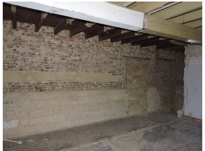
Figuur 25 De muur met de belending vanuit het middengedeelte gezien. De doorlopende mergelmuur geeft zeer waarschijnlijk de oorspronkelijke hoogte aan van de oudere massa met het dak haaks op de straat
