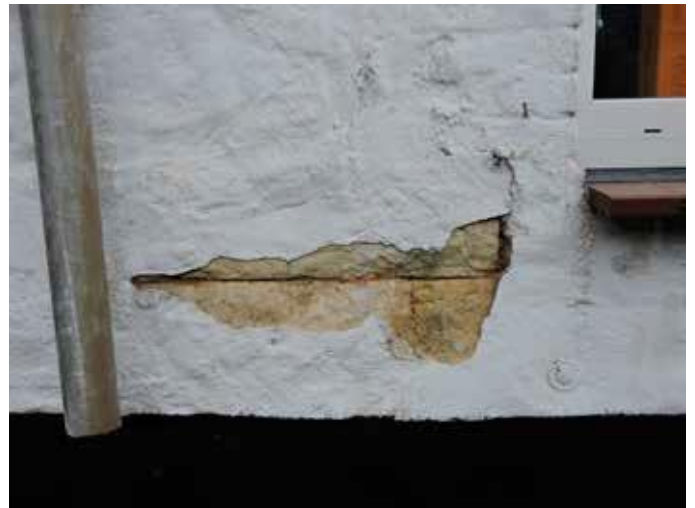
34. De mergel zelf is verstopt achter dikke lagen kalk, op plaatsen gecombineerd met cement. Daardoor zijn veel stenen aangetast
