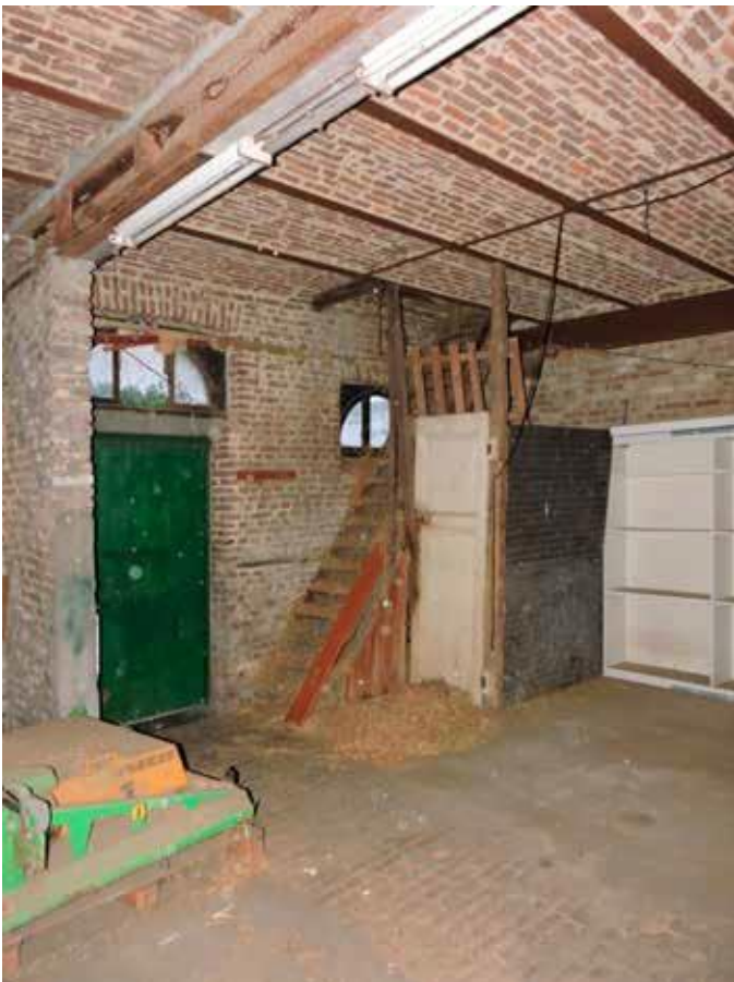
101. De trap naar de zolder ligt aan de overzijde, aan de kant van de binnenplaats
