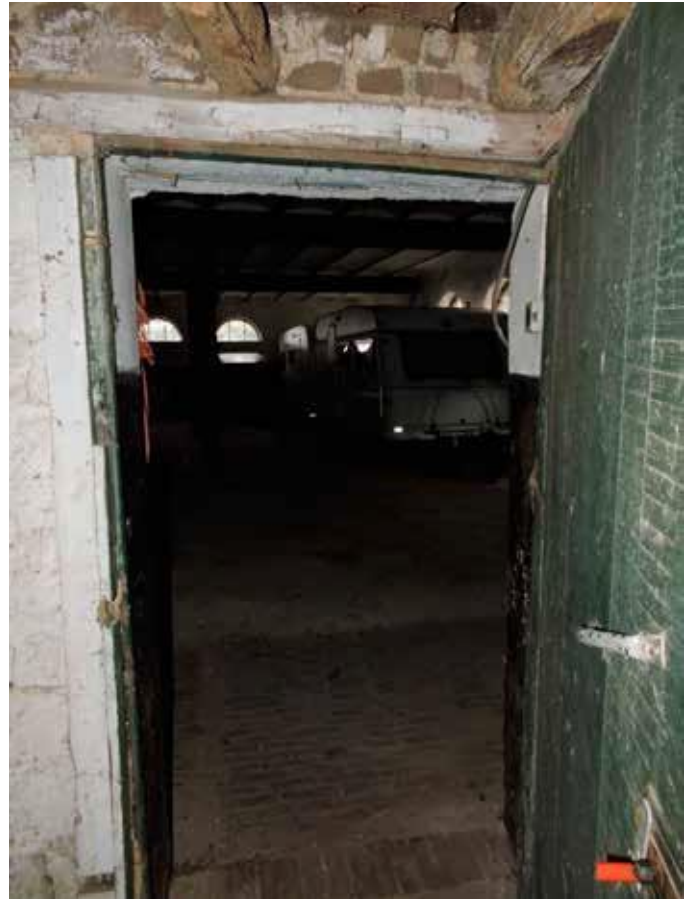
80. Doorkijk naar de grote ruimte in de hoek
