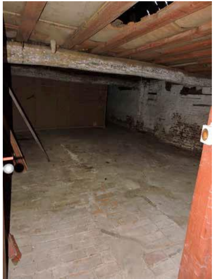
76. In de ruimte is aan de zijde van de grote stalvleugel in de hoek van het complex een van hout getimmerde ruimte afgezonderd
