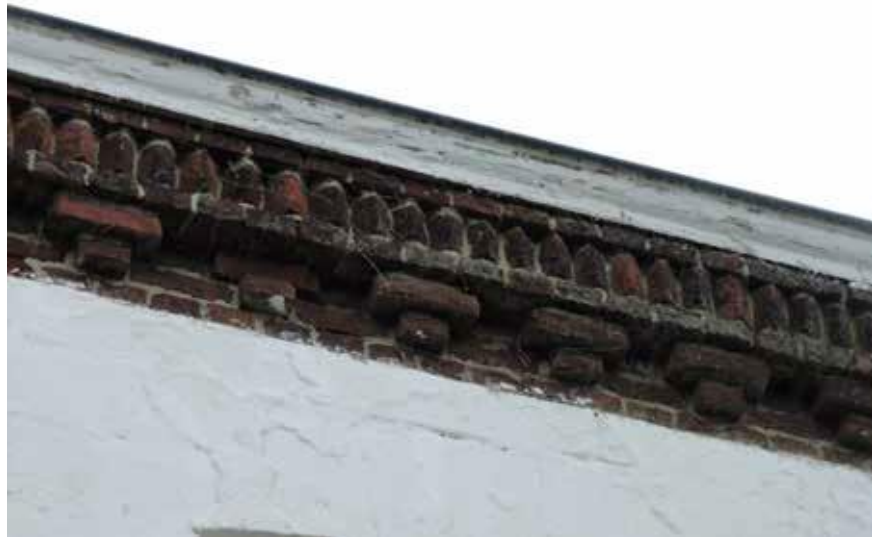
41. De sierlijst die de gevel afsluit onder de bakgoot
