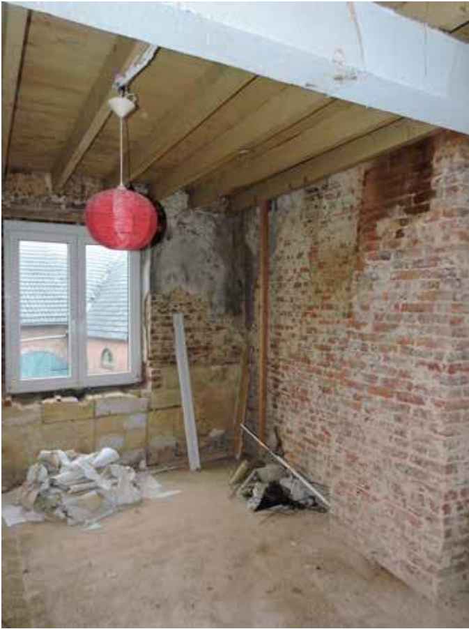
59. Muurwerk in een van de kamers rechts van de gang, deel van een eerdere modernisering
