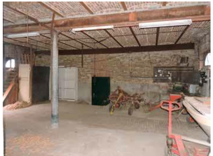
98. De middenruimte naar de courzijde gezien, met op het eind de muur van de voorste ruimte
