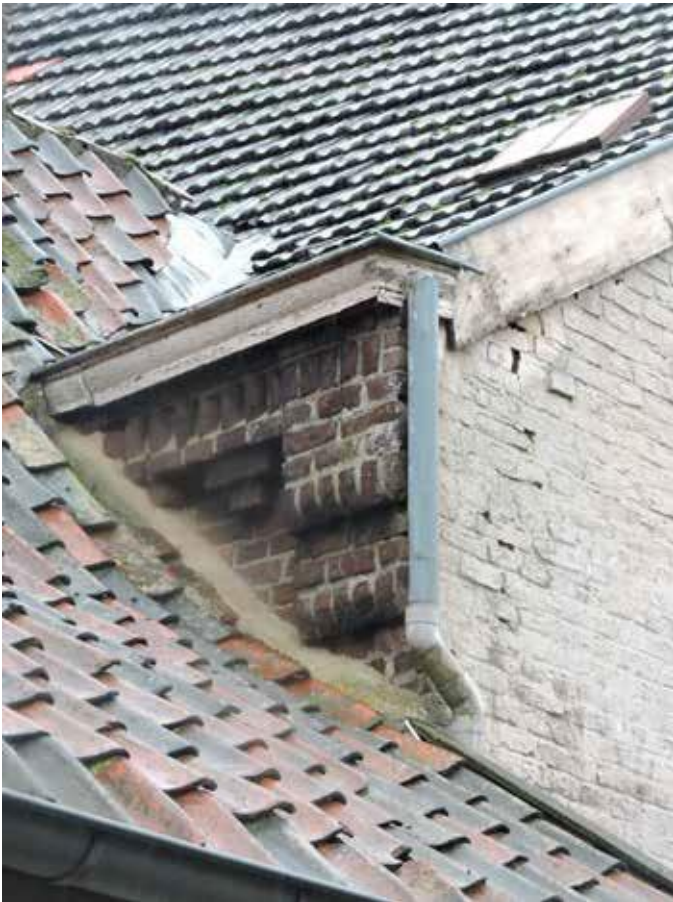
30. Bij de vernieuwbouw in baksteen, die volgens de RCE te dateren is in 1911 maar naar alle waarschijnlijkheid al uit 1887 stamt is de sierlijst die aan de voorgevel is gemaakt ook bij het vrije stukje van de nieuwe achtergevel aangebracht. Door het een kwart slag draaien van de massa vanwege het bouwen van een verlengd huis naar rechts, met als gevolg een topgevel aan de zijkant, bestaat de ophoging uit baksteen en steekt uit boven de oude dwarsgerichte massa
