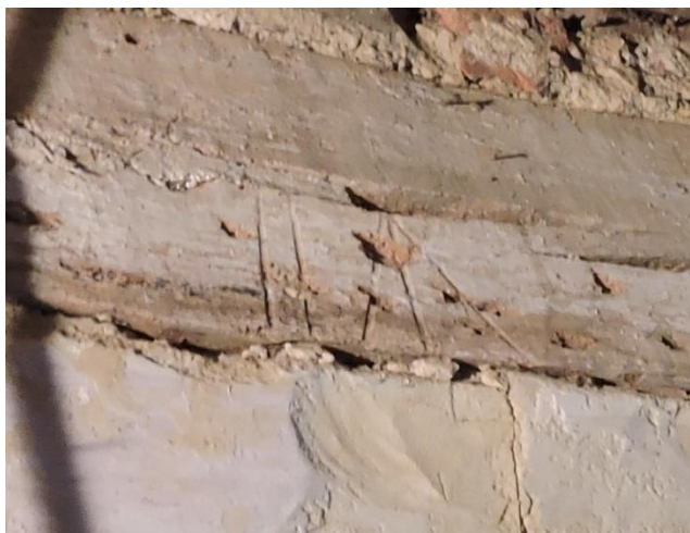
Figuur 4 Het telmerk op de balk
