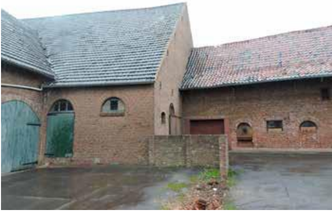
22. Het verschil in ouderdom blijkt uit de gebruikte baksteen, de gebruikte specie en de aansluiting van het lagere dak tegen de hoge bouwmasa. De beide deurtjes zijn omgevormd tot vensters en vervangen door een nieuwe grotere deur, links
