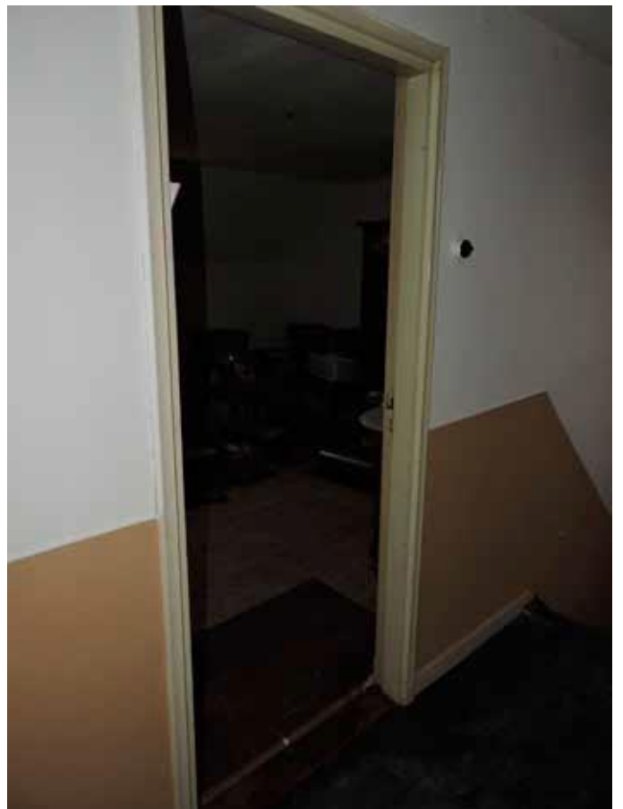
66. Terug naar de verdieping waar in de achterkamer bij de aanlanding van de trap een verbinding is met de kapruimte in het dwarse deel, dat onderdeel is van de oude(re) massa
