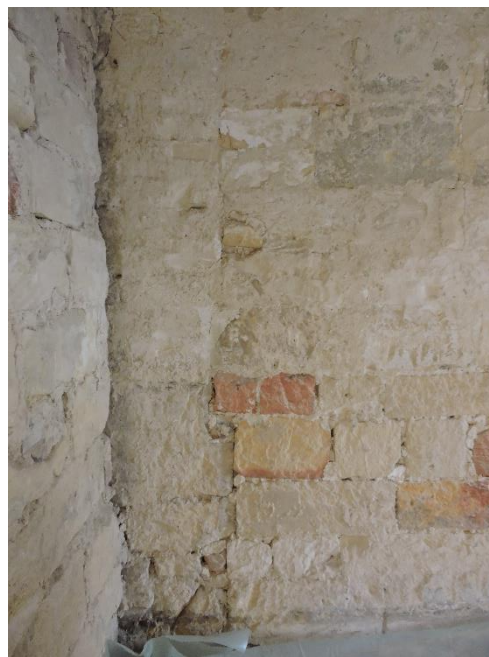
Figuur 7 Een onderbroken staande naad laat de oude opening zien
