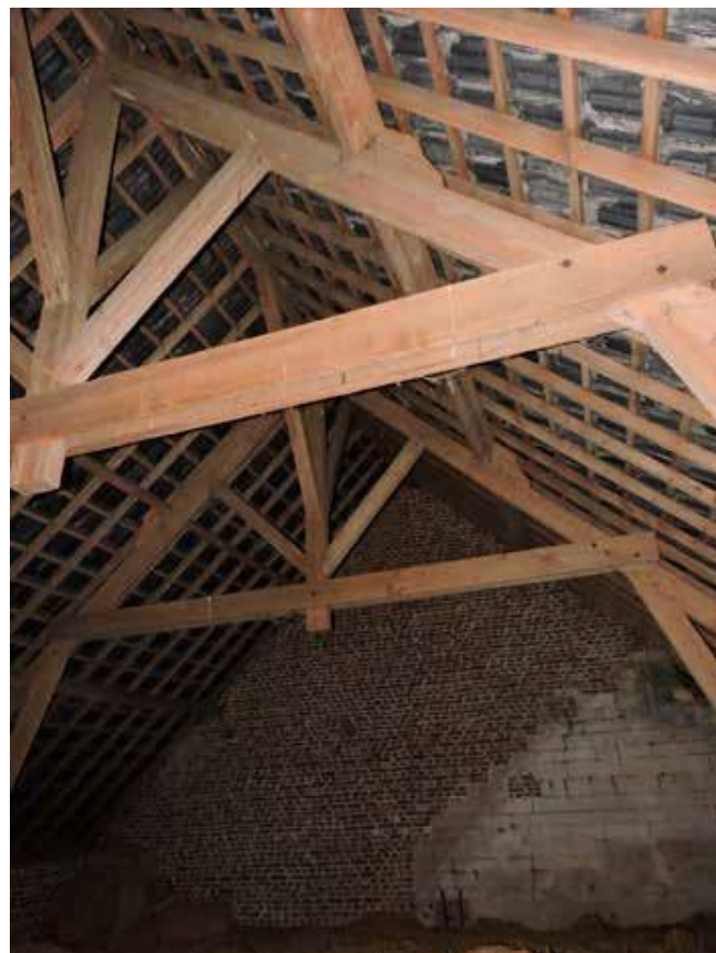
104 De opbouw van de spanten
