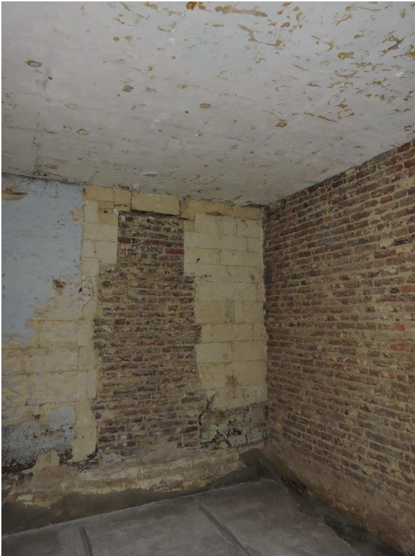
Figuur 18 In de bijkeuken is opnieuw een dichtgezette deur te zien
