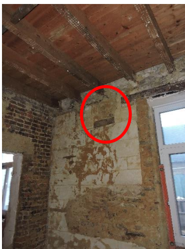
Figuur 13 In de bijkeuken is goed te zien hoe de vensters zijn uitgezaagd en verbreed, en hoe slechte stukken mergel zijn vervangen door baksteen. Tevens een locatie van dichtgezette moerbalken
