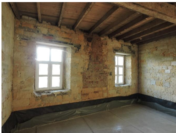
Figuur 2 De binnenzijde van de gevel aan de straat met het in onbruik geraakte schoorsteenkanaal
