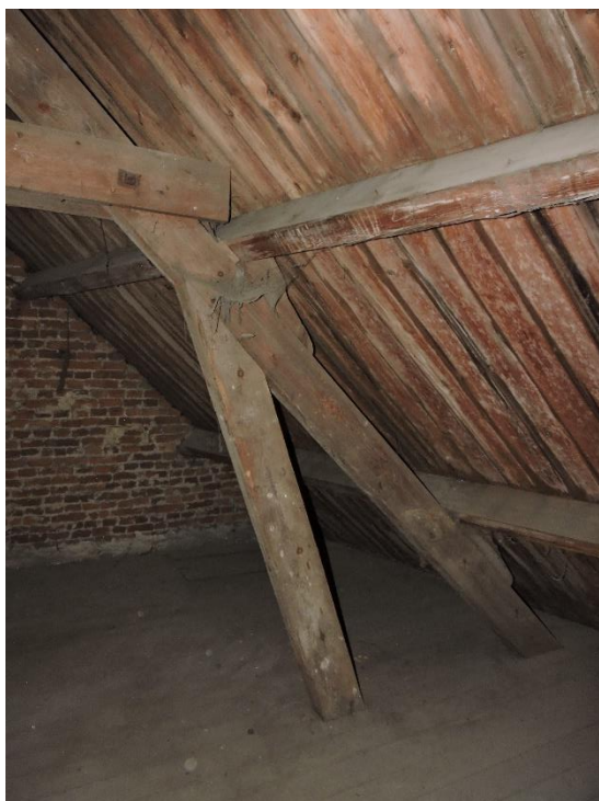
Figuur 30 De zolder met een van de spanten
