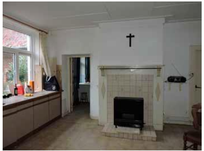
52. De schouw in de achterkeuken, van rond 1950, toen het pand opgewaardeerd is, is onderdeel van een bakstenen muur, en niet, zoals aan de straat, een van mergel. Het is niet waarschijnlijk dat dit de plaats is van de schouw in de oude massa, temeer daar een ruggelings geplaatste schouw dan heel ver van het oorspronkelijke woonhuis zou hebben gelegen. Aannemelijker is dat een mogelijke dubbele haard ongeveer ter plekke van de huidige gang heeft gestaan, maar wel aan de rand van de kelder, wat de gangbare plaats is, mede om zo het gewicht van de schoorsteen te schragen
