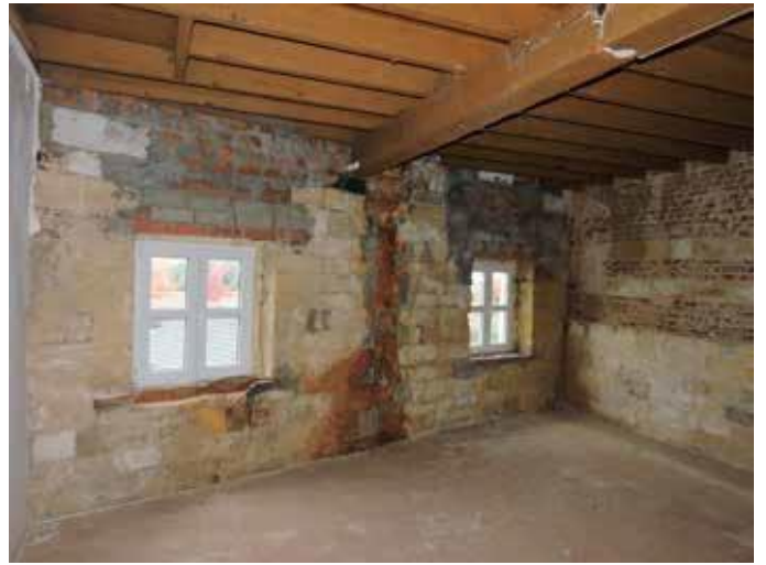
60. De kamer aan de straat. Duidelijk is de aanvankelijke aftopping en latere ophoging te zien in de straatgevel, horend bij de vernieuwbouw rond 1887
