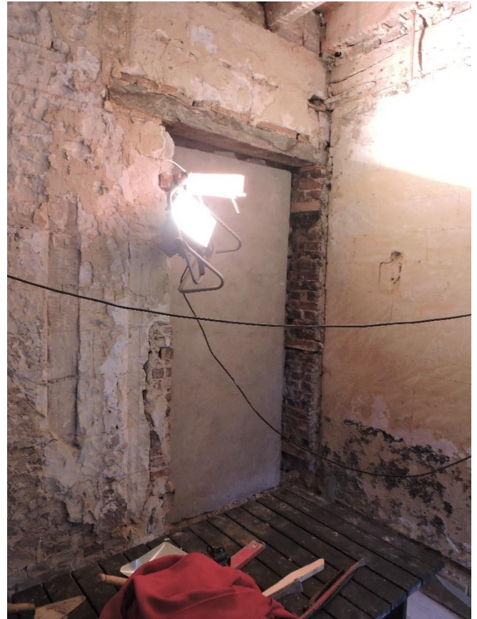
Figuur 9 De in 1951 dichtgezette doorgang naar no. 70, iets opgeschoven t.o.v. de eerdere doorgang, in het verlengde van het halletje achter de voordeur
