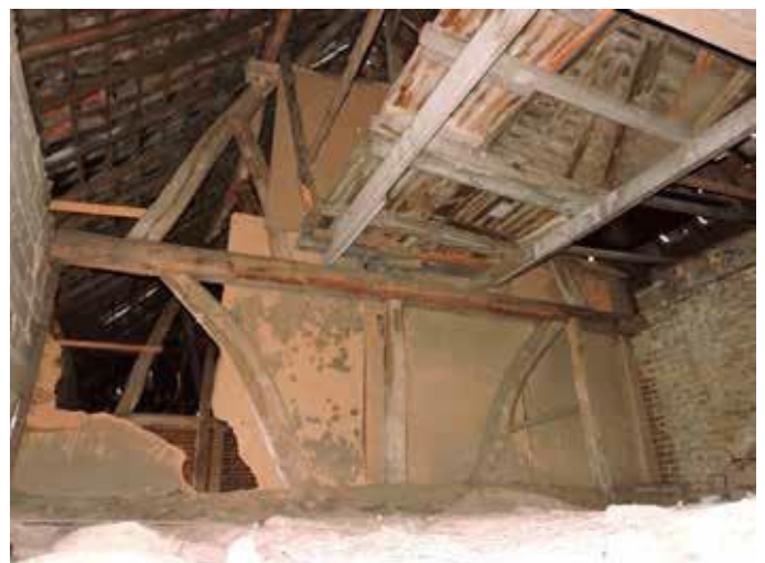
78. In het voorste stuk, bij de poort, zijn vroeg-19de -eeuwse spanten van de stalvleugel te zien
