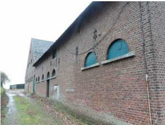
11. De stalvleugel vanaf de straat naar achter. Aan de detaillering van de rondboogjes van de vensters en de gebruikte ankerijzers is afleesbaar dat dit een andere bouwphase is, en wel die van 1857
