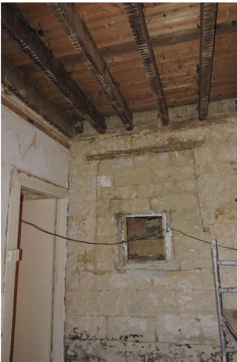
Figuur 10 Een van de twee voormalige vensters naar de buitenkant aan de zijde van het huidige no. 70, met in de dichtgezette opening een later ook weer gedicht muurkastje
