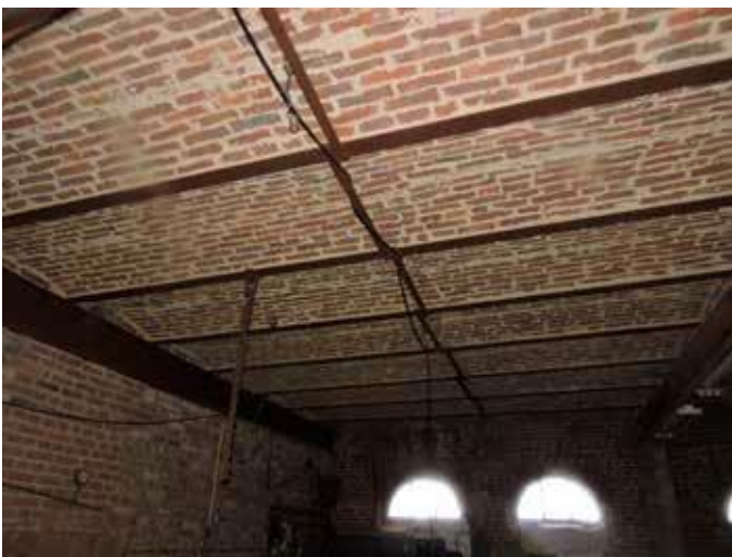
90. Ook hier gelijkaardige plafonds annex vloeren, nu zonder raaplaag
