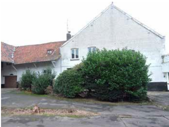
35. Van afstand is goed te zien hoe diep de vernieuwbouw is
