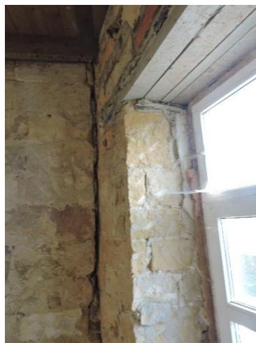
Figuur 5 De niet-ingekaste muur van de belending in de hoek met de straatgevel
