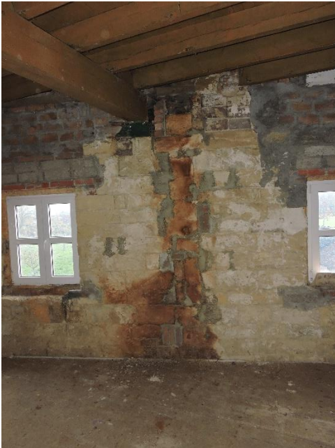
Figuur 26 De voorgevel met het spoor van het verdwenen schoorsteenkanaal. De balk die ter plekke in de muur is ingelaten wijst erop dat de vloer in elk geval is gelegd nadat de schoorsteen verplaatst is naar de zijmuur aan de binnenplaatskant
