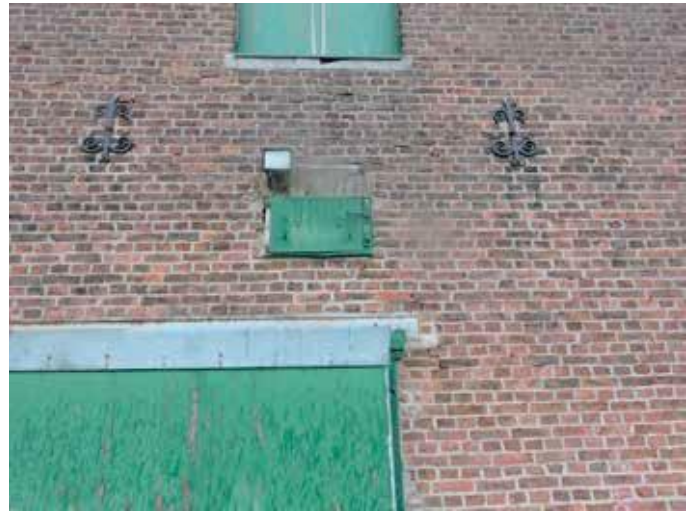
14. Detail van de topgevel
