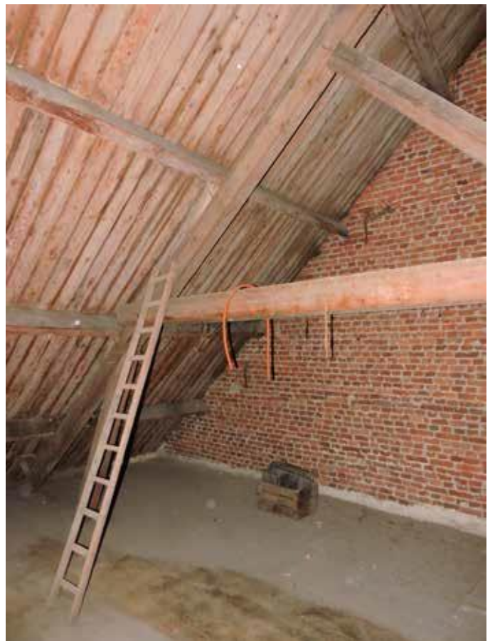
62. De tussengevel met het buurpand
