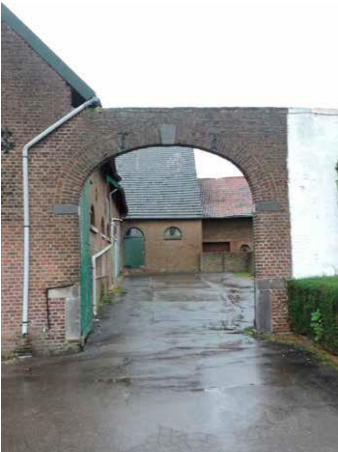
15. De poort uit 1857 met doorkijk langs de stalvleugel en zicht op de hoge bouwmassa achter. Rechts daarvan de oude stal
