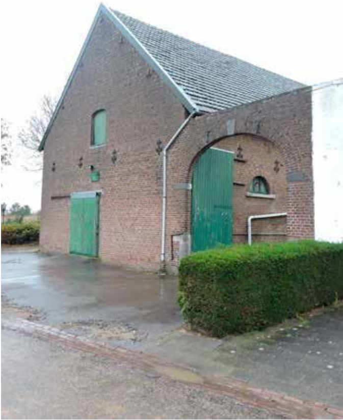
13. De topgevel aan de straat die in verband is gemetseld met de poort. Die is gedateerd in de sluitsteen, 1857. De vierkante poort is een vrij recente toevoeging
