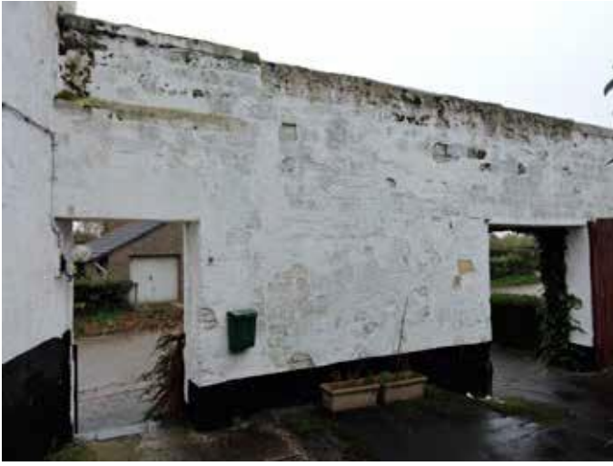
37. Een bouwnaad tussen de poortmuur en het stuk met het voetgangspoortje laat veronderstellen dat de muur secundair is en is gezet toen links, tegen de nieuwe stalvleugel, een nieuwe poortingang kwam. De kleine, vierkante poort is pas na 1975 ingebroken in de muur.
