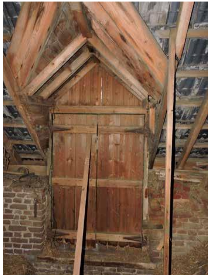
102. Meteen daar boven is de muur doorbroken door een laadluik voor hooi en stro
