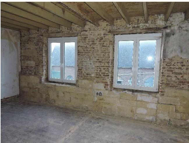
Figuur 28 Kunststoframen aan de courzijde.
