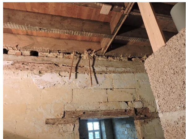
Figuur 3 De scheidingsmuur met het halletje naar de straat gezien, met de mogelijk hergebruikte balk
