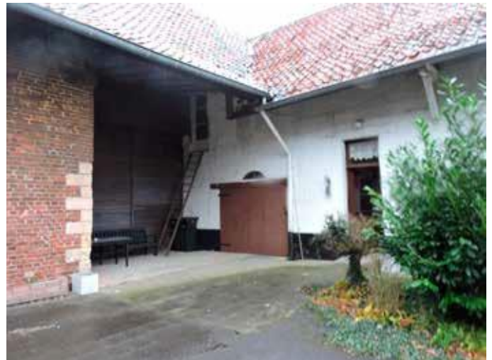
25. De voormalige doorrit naar achter en de aansluiting op de woonhuisvleugel. De ruimte onder de poort is gedeeld met de burens, die de achterste helft in bezit hebben. De afsluiting is rond 1990 gerealiseerd.
