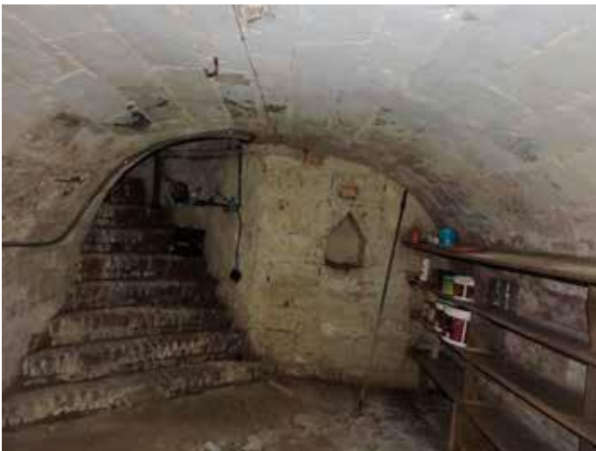
45. De kelder, opgetrokken in mergel, naar de courzijde gezien...
