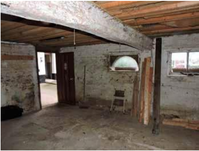
75. De ruimte zelf heeft een vloer die bestaat uit lapwerk van baksteen en beton
