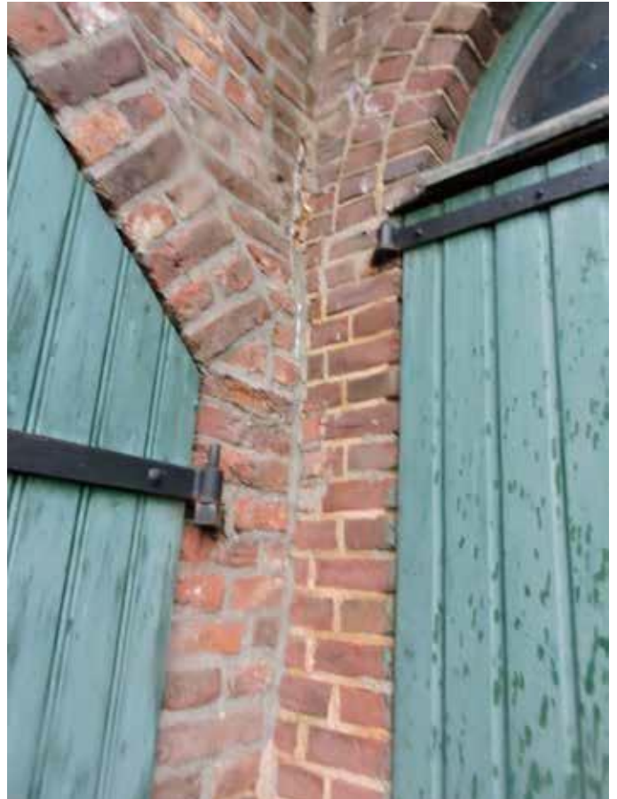
21. Detail van de aansluiting van de hoge stalvleugel met de vleugel uit 1857: de baksteenlagen lopen niet door, er heeft geen inkassing plaatsgevonden
