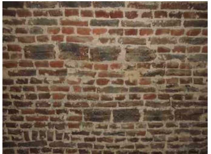
64. Voor het binnenblad van de muren zijn tweede-keusstenen en misbaksels gebruikt, een fenomeen dat veel voorkomt bij boerderijen, zeker bij schuren waar meters gemaakt moesten worden
