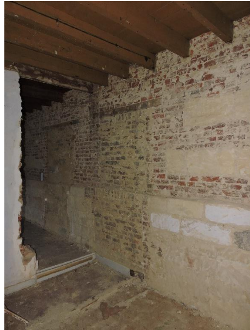
Figuur 23 In de muur met de belending zitten twee dichtgemaakte deuren.
