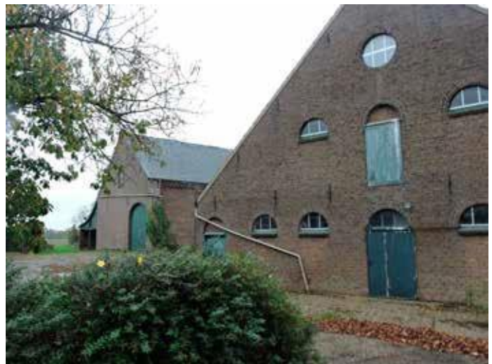
8. De vormgeving van de topgevel is opmerkelijk voor de bouwtijd, 1926, maar qua uitvoering sterk verwant aan de vleugel die vanaf de straat tot aan deze massa loopt.
