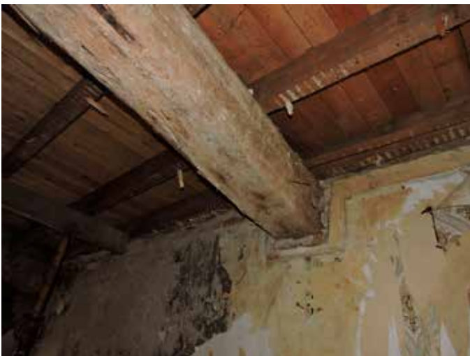
49. Ook het gebruik van olmen voor de moerbalk, die altijd omkleed is geweest, wijst op een dergelijke bouwtijd
