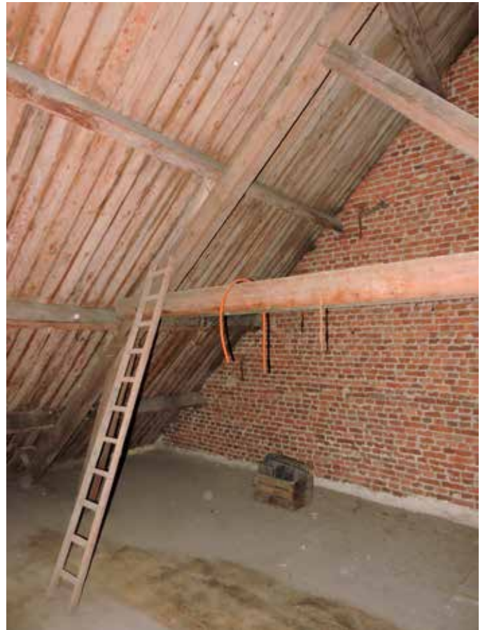
62. De tussengevel met het buurpand
