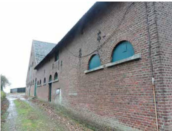
11. De stalvleugel vanaf de straat naar achter. Aan de detaillering van de rondboogjes van de vensters en de gebruikte ankerijzers is afleesbaar dat dit een andere bouwphase is, en wel die van 1857
