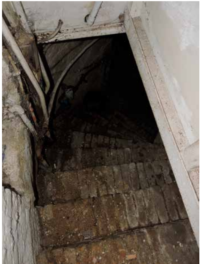
44. De trap naar de kelder bestaat uit treden van baksteen die een oudere trap vervangen. Die lag aanvankelijk meer naar binnen, naast een open haard
