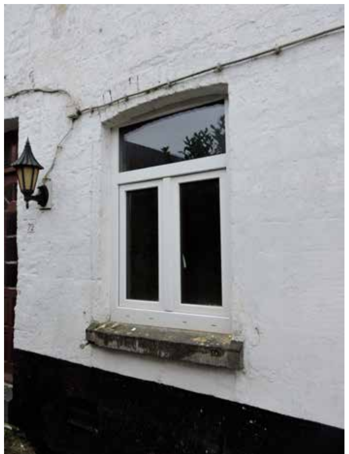
32. Ook de vensters zijn vernieuwd, rond 1920, terwijl de vleugels van rond 1950 zijn
