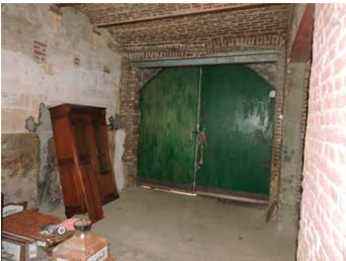
92. Daar is een deel te zien van een muur die hoort bij de aanvankelijke stalvleugel, met haaks daarop de nieuwe poort die twee oudere openingen vervangt zoals is te zien aan de twee ontlastingsbogen
