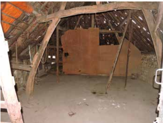
69. Naar achter toe is de ruimte geheel open. De beplating markeert de scheiding met de burens op no. 70. Het feit dat die nogal provisorisch is gemaakt duidt op voorheen familiale verhoudingen
