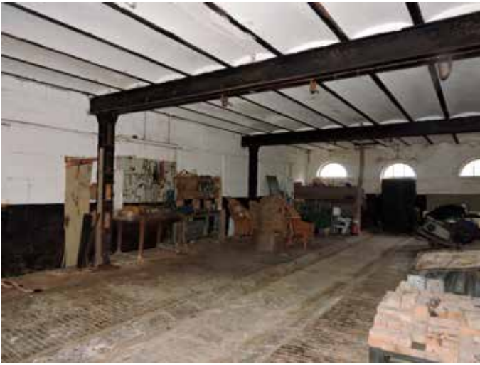
83. Overzicht over de ruimte naar de zijkant gezien. De wand links scheidt een deel af dat als stal is ingericht
