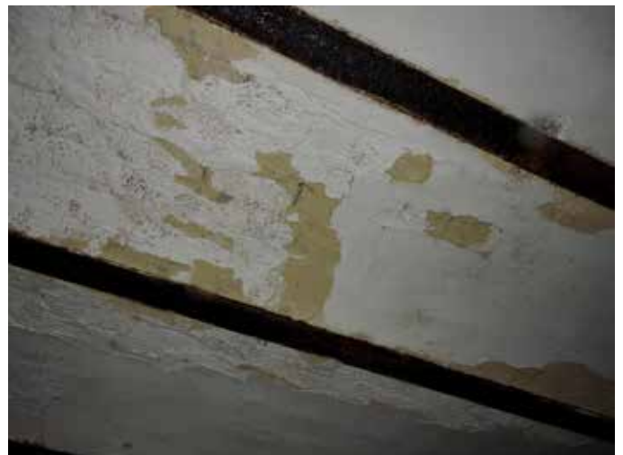
82. Het plafond annex de verdiepingsvloer bestaat uit beraapte gewelven van baksteen tussen ijzeren liggers met een H-profiel
