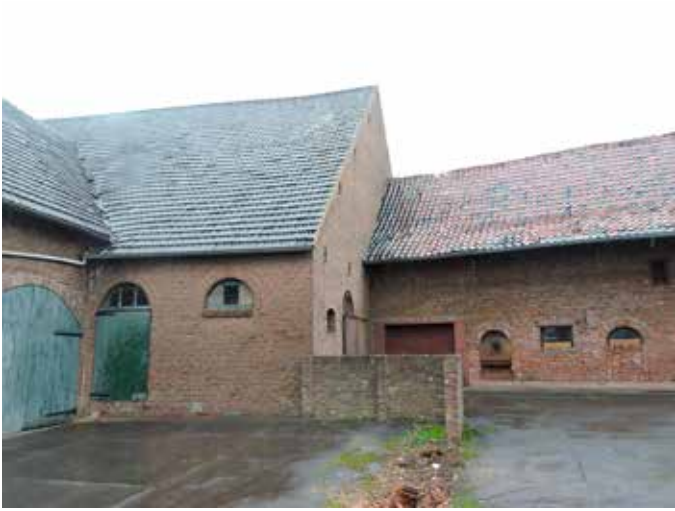
22. Het verschil in ouderdom blijkt uit de gebruikte baksteen, de gebruikte specie en de aansluiting van het lagere dak tegen de hoge bouwmasa. De beide deurtjes zijn omgevormd tot vensters en vervangen door een nieuwe grotere deur, links
