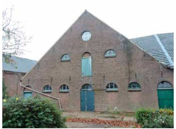
10. Zowel aan de aansluiting van het dak als aan de staande naad helemaal rechts is te zien dat de beide bouwdelen onafhankelijk van elkaar zijn neergezet
