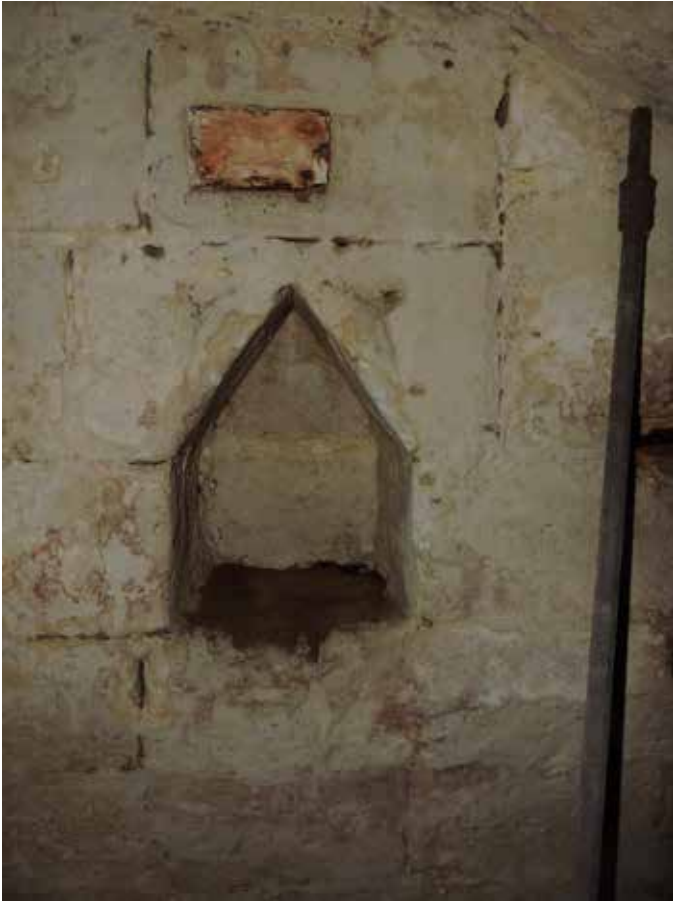
47. De lampnissen aan beide zijden hebben een lichte versiering die laat-gotisch is, waarmee de kelder te dateren is in de late 16 de eeuw
