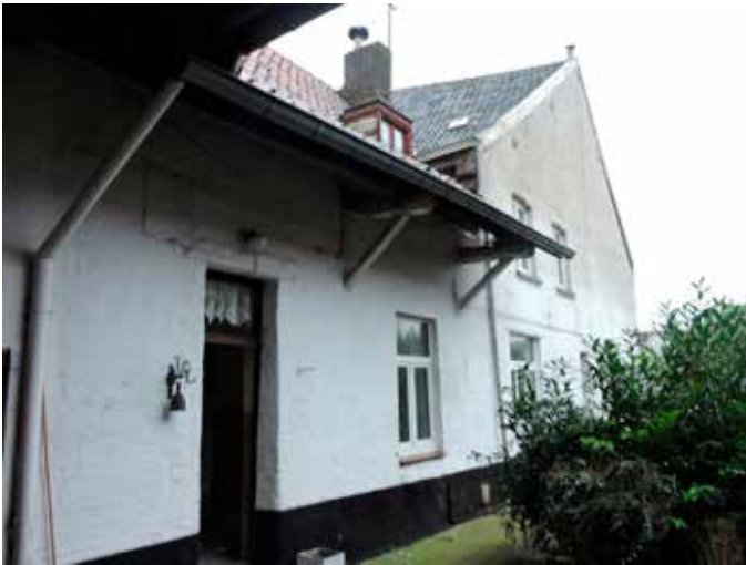
28. De woonhuis vleugel tot aan de straat. Het lage deel is deel van het oudste woonhuis, zij het met tal van wijzigingen, maar zet zich voort in het benedendeel van de kamer aan de straat, en is uitgevoerd in mergel
