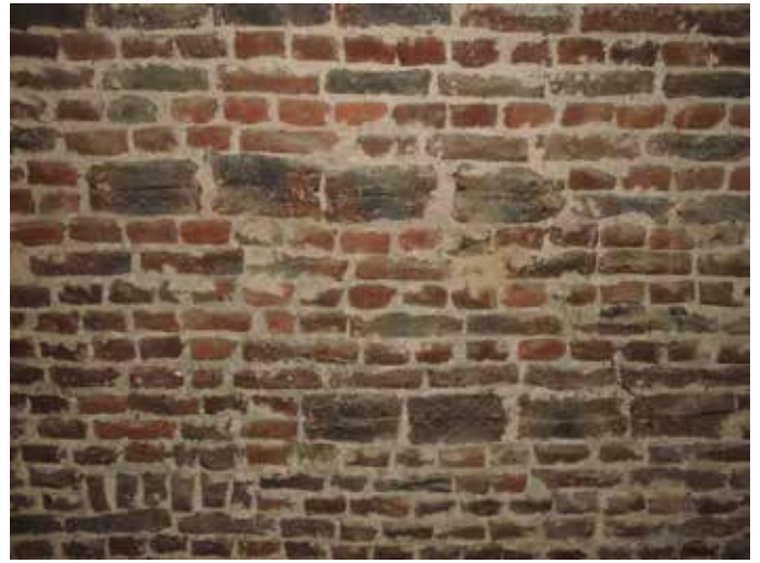
64. Voor het binnenblad van de muren zijn misbaksels gebruikt, een fenomeen dat veel voorkomt bij boerderijen, zeker bij schuren waar meters gemaakt moesten worden
