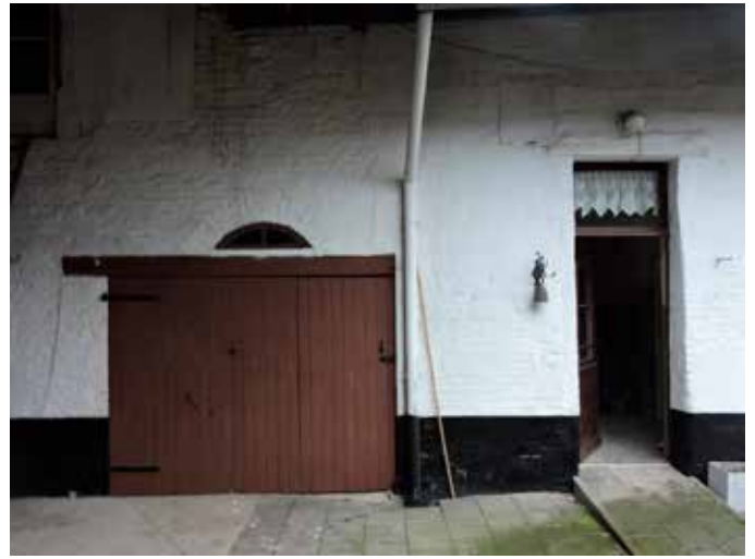
27. Het linker stuk van de woonhuisvleugel met ter plekke van de huidige brede deur de restanten van een oudere, lage en smalle deur, die naar een melkkamer leidde. De deur rechts is de 'werkdeur' naar het woonhuis
