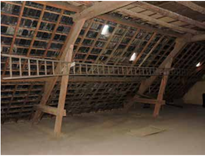
88. De opbouw van de spanten die laten zien dat het geheel eind 19 de eeuw is gebouwd
