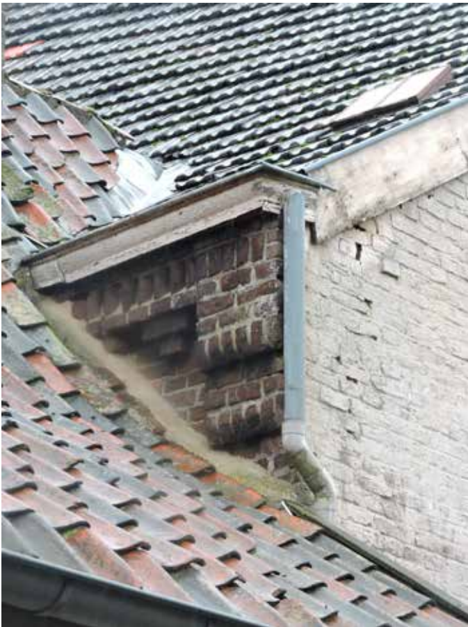
30. Bij de vernieuwbouw in 1911 is de sierlijst die aan de voorgevel is gemaakt ook bij het vrije stukje van de nieuwe achtergevel aangebracht. Door het een kwart slag draaien van de massa vanwege het bouwen van een verlengd huis naar rechts, met als gevolg een topgevel aan de zijkant, bestaat de ophoging uit baksteen en steekt uit boven de oude dwarsgerichte massa
