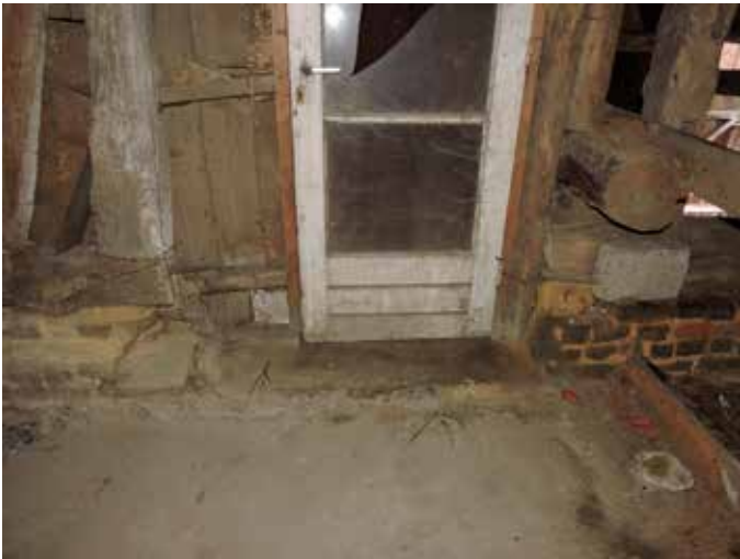
73. Vanaf de zolder ging een deur naar de zolder van de stal. Voor die doorgang is de moerbalk van het eerste spant doorgezaagd
