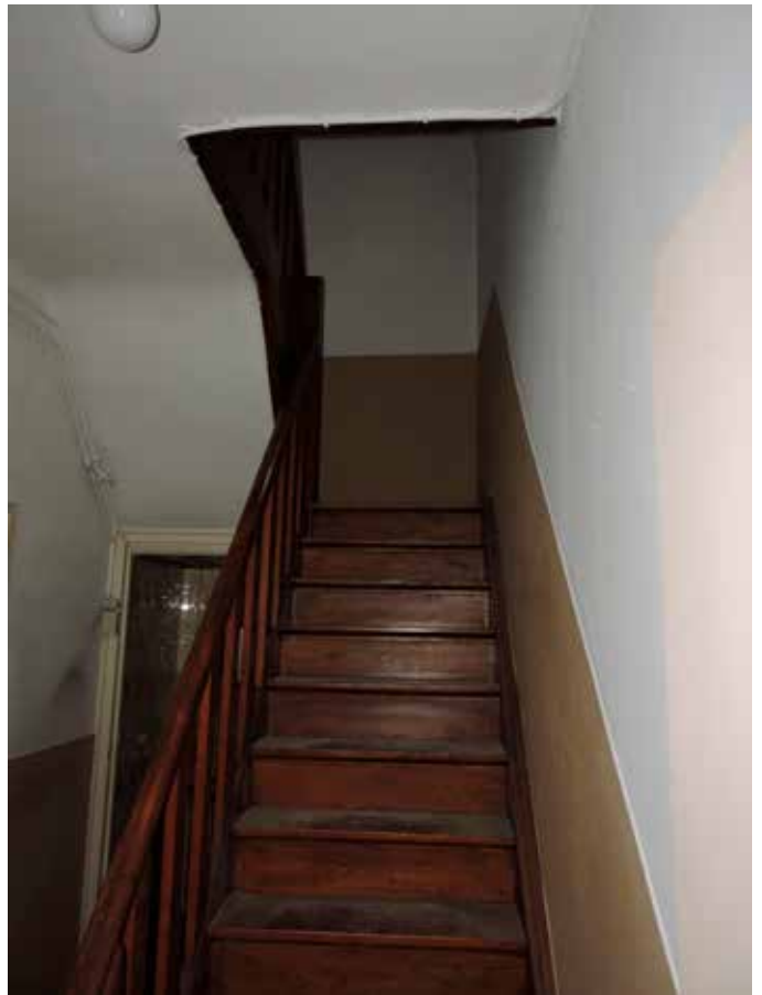
56. De trap gaat met een tussenportaal naar de verdieping, en draait 90 graden
