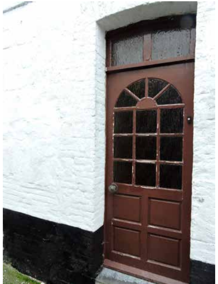
31. De voordeur die vrijwel op de plaats zit van de oorspronkelijke deur, maar zelf is vernieuwd rond 1950. De opening is vernieuwd in baksteen
