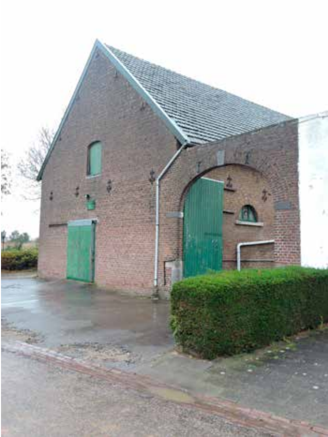
13. De topgevel aan de straat die in verband is gemetseld met de poort. Die is gedateerd in de sluitsteen, 1857. De vierkante poort is een vrij recente toevoeging
