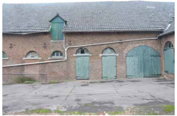
18. De gevel van de stalvleugel is meermalen gewijzigd: deuren zijn dichtgezet, het poortje rechts is toegevoegd
