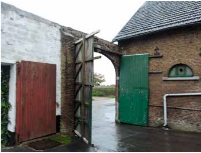
17. De poort aan de binnenzijde gezien
