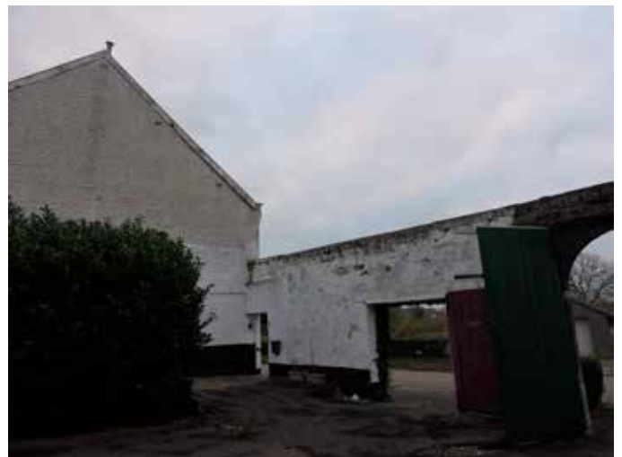
36. De aan het huis aansluitende poortmuur in mergel. De poortopening is oorspronkelijk
