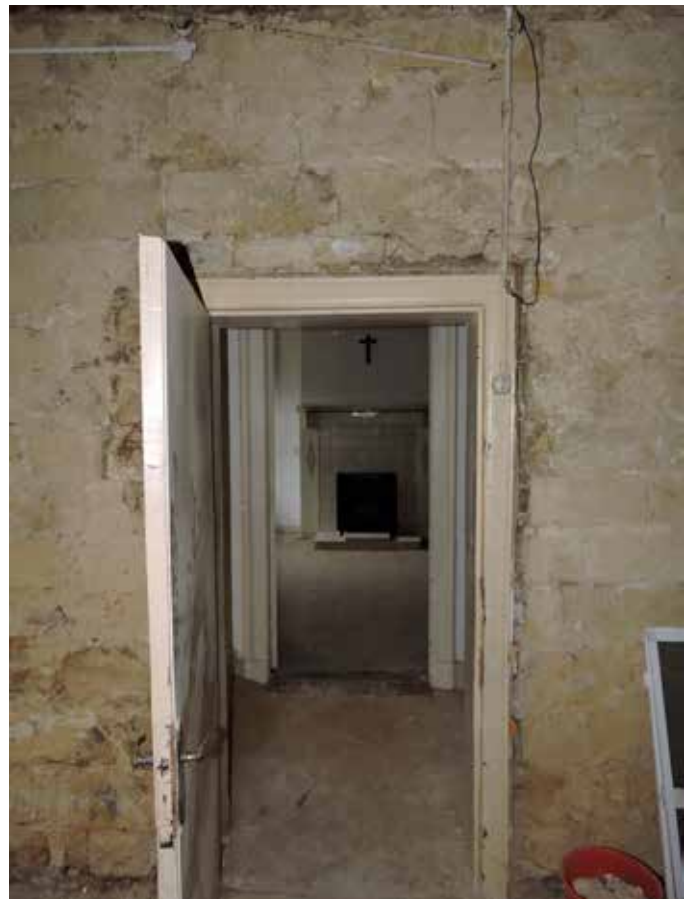
50. Doorkijk door het huis naar achter. De ruimte op het eind is eveneens een toevoeging aan de oorspronkelijke massa
