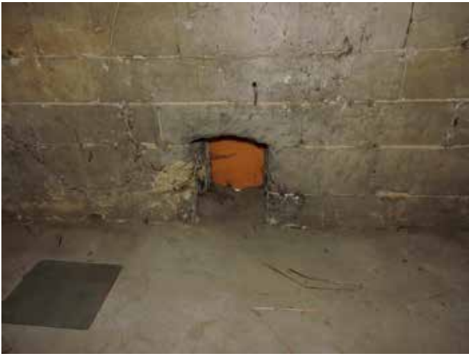
71. Aan de binnenplaatskant zit op vloerhoogte een nu dichtgezette opening. Dat was de toegang tot een kippenhok op zolder dat toegankelijk was middels een smalle loopplank vanaf de cour. Die begon een meter boven de grond waardoor kippen de sprong wel haalden, en een vos of marter niet. Op zolder was dan meestal een gedeelte afgeschoten als kippenren
