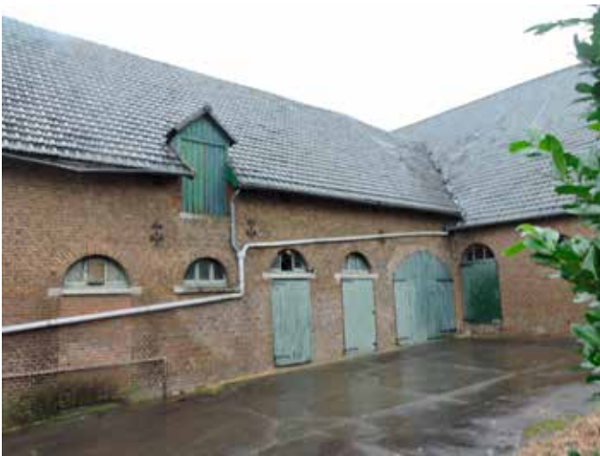
19. De aanhechting van de stalvleugel op de nieuwe stal. Opnieuw laten de details in de afwerking van de vensterbogen zien dat er sprake is van twee bouwcampagnes
