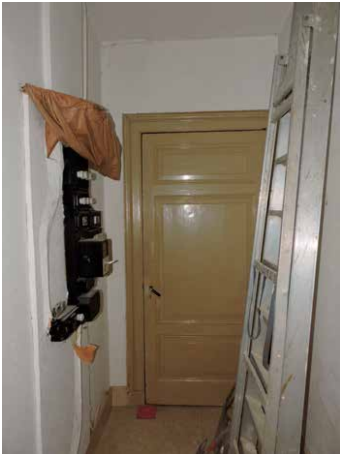
51. Tegenover de voordeur staat een deur die oorspronkelijk een verbinding vormde met de nieuwbouw rechts, uit 1911
