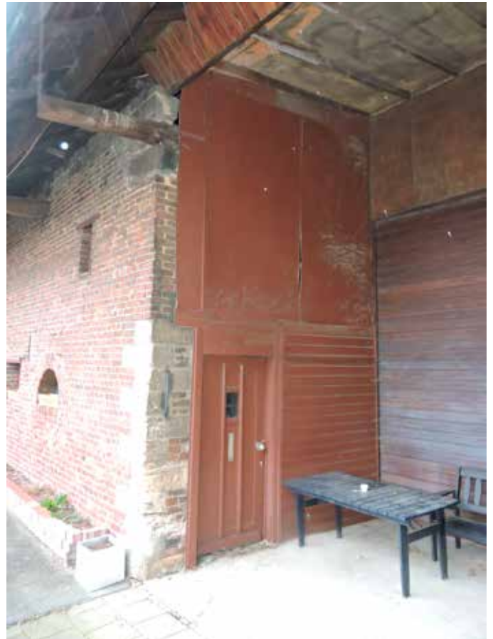
74. Die stal heeft op de begane grond een deur onder de overkapping van de poortruimte
