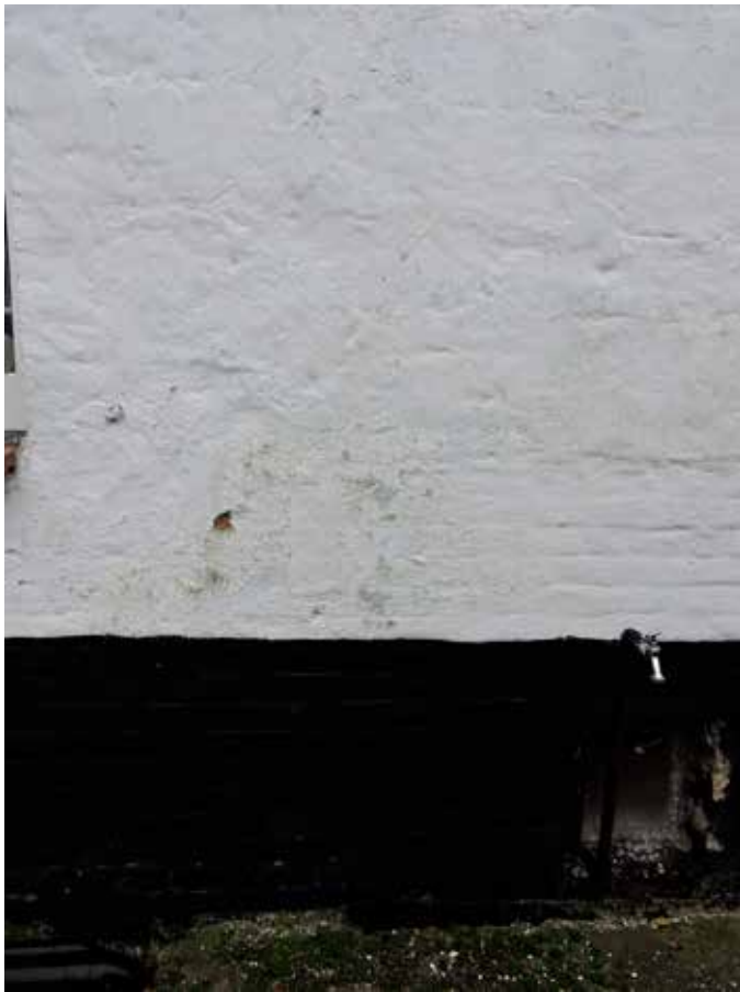
33. Op verschillende plaatsen is verweerde mergel vervangen door baksteen
