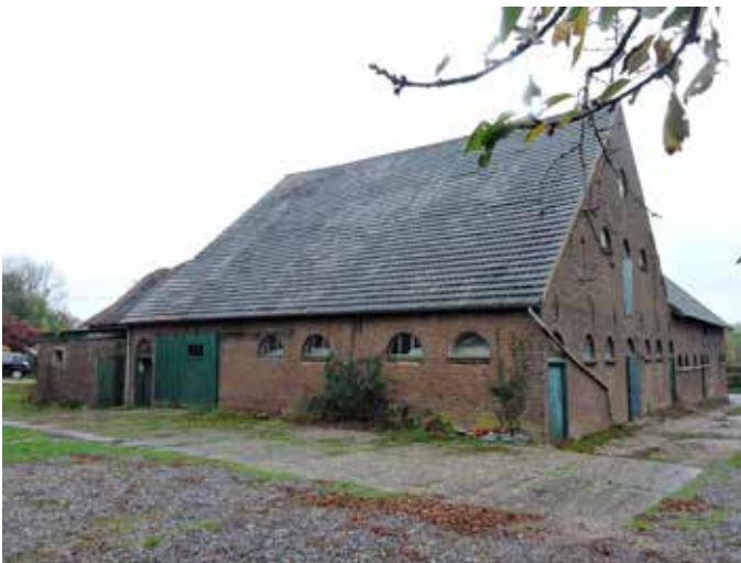
7. Die vleugel laat met zijn vele stalramen en de smalle deur zien dat dit geen schuur is: er is geen enkele poort. De lage schuifpoort in de achtergevel is secundair
