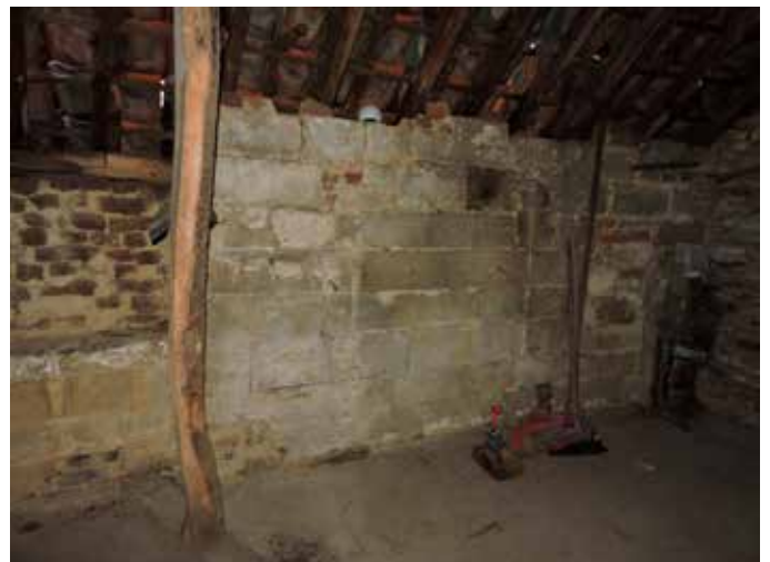
70. De eerdere deling wordt gemarkeerd door de ophoging van de tussenmuur, aanvankelijk buitenmuur van het oude huis
