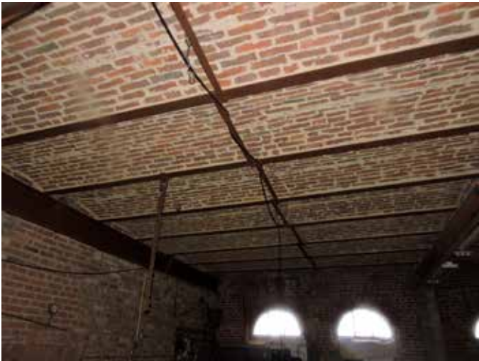
90. Ook hier gelijkaardige plafonds annex vloeren, zonder raaplaag
