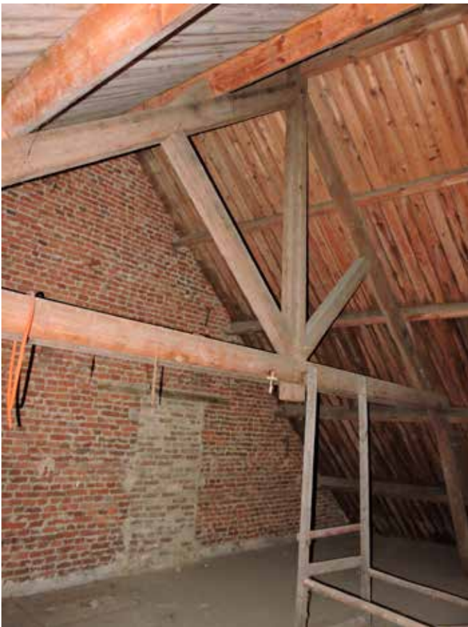
65. De brandgevel met het buurpand met een dichtgezette deur
