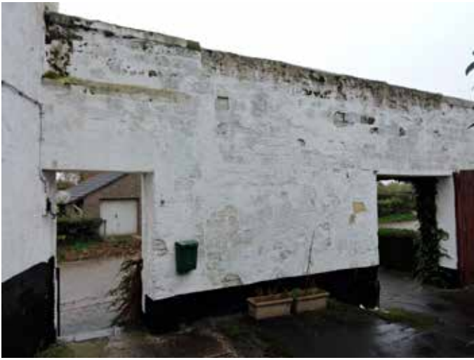
37. Wel valt op dat er bouwnaad is tussen de poortmuur en het stuk met het voetgangerspoortje. Mogelijk heeft dit te maken met het verkleinen van de poortdoorgang na het bouwen van de vleugel links met de bijbehorende poort
