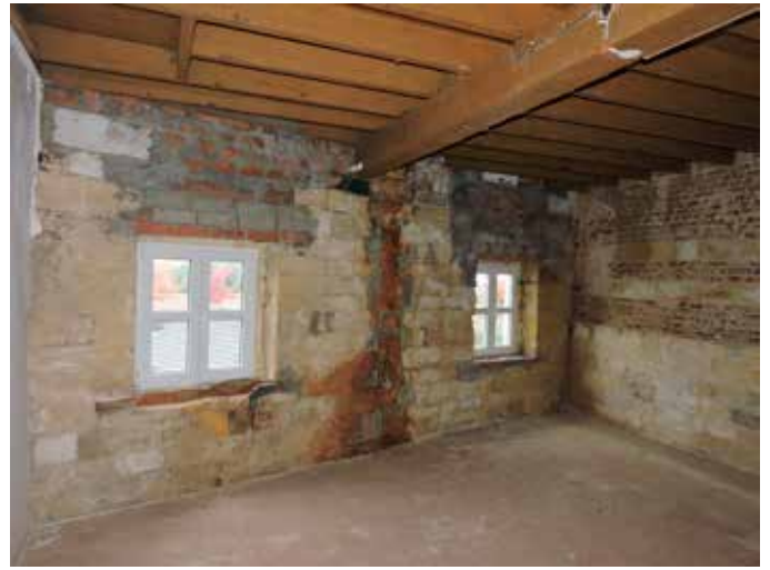
60. De kamer aan de straat. Duidelijk is de aftopping en latere ophoging te zien in de straatgevel, horend bij de vernieuwbouw uit 1911
