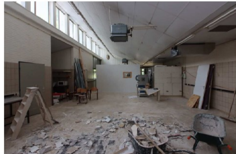
Bouwlokaal met links verschillende nevenruimten
