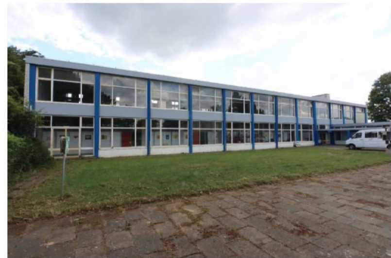
Overzicht pleingevel hoofdgebouw
