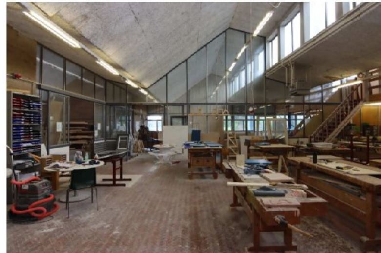
Houtbewerkingslokaal met kopshouten visgraatvloer met links nevenruimten
