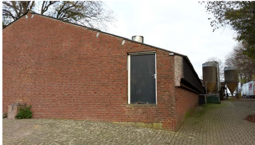
Te saneren bebouwing en erf
