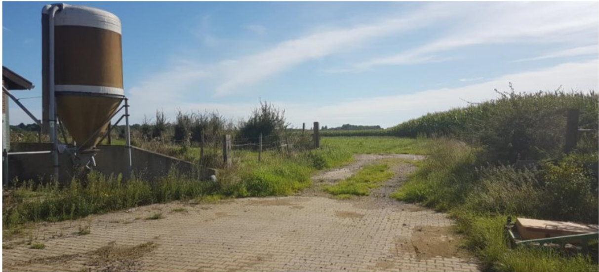
Figuur 9: Steilrand met betonnen keerwand oostzijde bedrijfsterrein. 17
