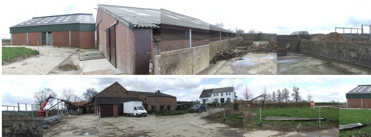
Figuur 20: Samengestelde panoramafoto vanaf het centrum van het plangebied. Foto's: A. Van de Water d.d. 2 april 2015.
