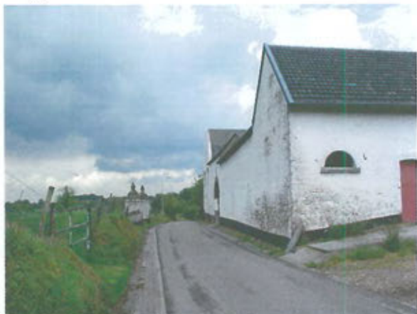
1 locatie, gezien vanaf de weg
