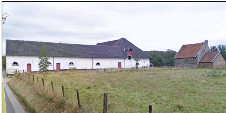
Foto's bestaande situatie
