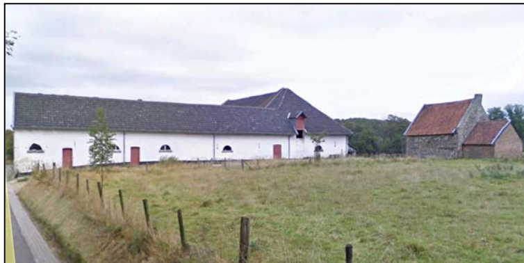
Foto's bestaande situatie
