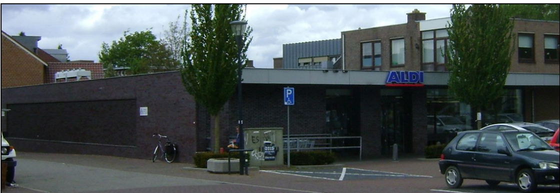
Figuur 1.5: Zicht op het deelgebied aan het Raadhuisplein te Cadier en Keer
