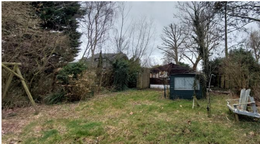
1. Diversiteit aan vervallen bouwwerken/recreatiewoningen op kavel
