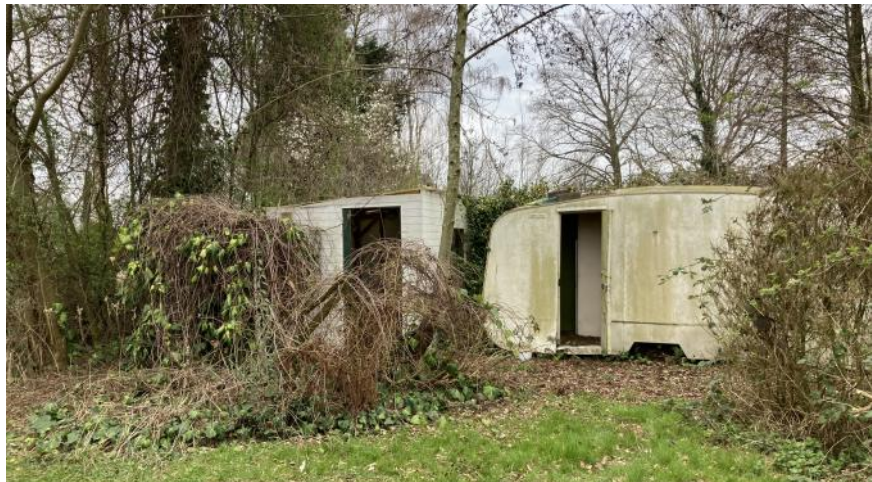
2. Diversiteit aan vervallen bouwwerken/recreatiewoningen op kavel
