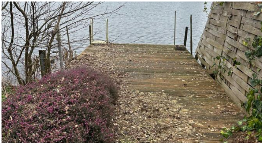
3. Bestaande vlonder aan oostzijde plangebied
