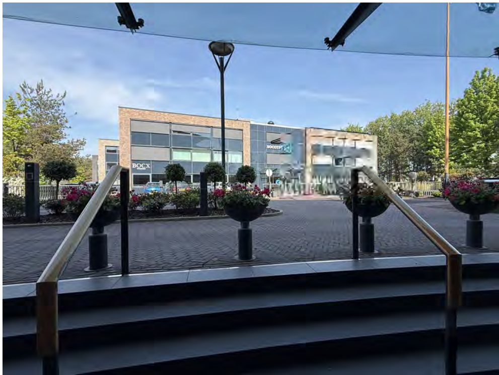
vanuit de entree van Het Baken is de toevoeging niet waarneembaar en aldus blijft de symmetrie behouden
