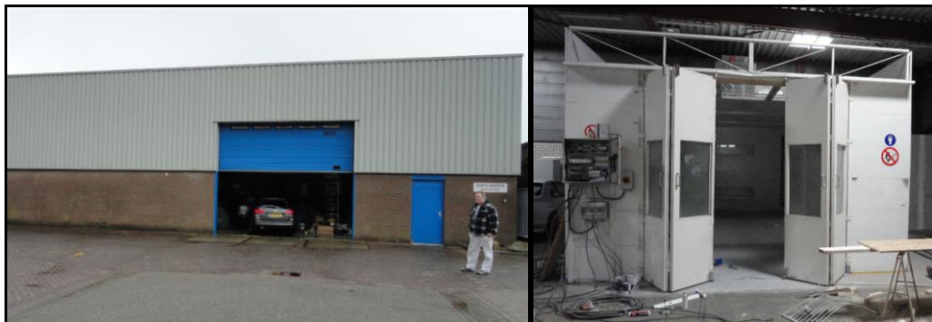
Figuur 2: aanzicht van voorgevel bedrijfspand en de spuitcabine. Bron: Zeldenrust..
