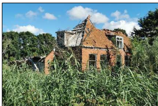
Figuur 2.2. Oostelijke gevel van de stolpboerderij.
