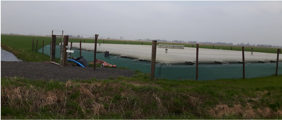
Figuur 3. Voorbeeld van een mestzak met hekwerk (bron: Mestopslagadvies)
