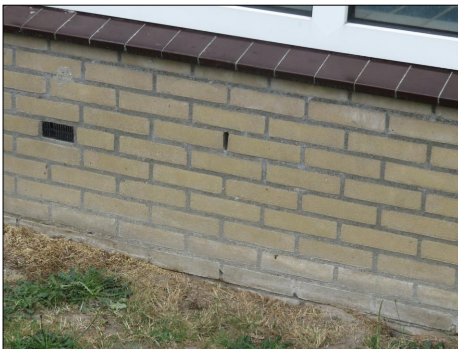
Figuur 2.5. Stootvoegen aan de westzijde van het plangebied bevinden zich te dicht aan de grond om geschikte doorgangen voor vleermuizen te vormen.
