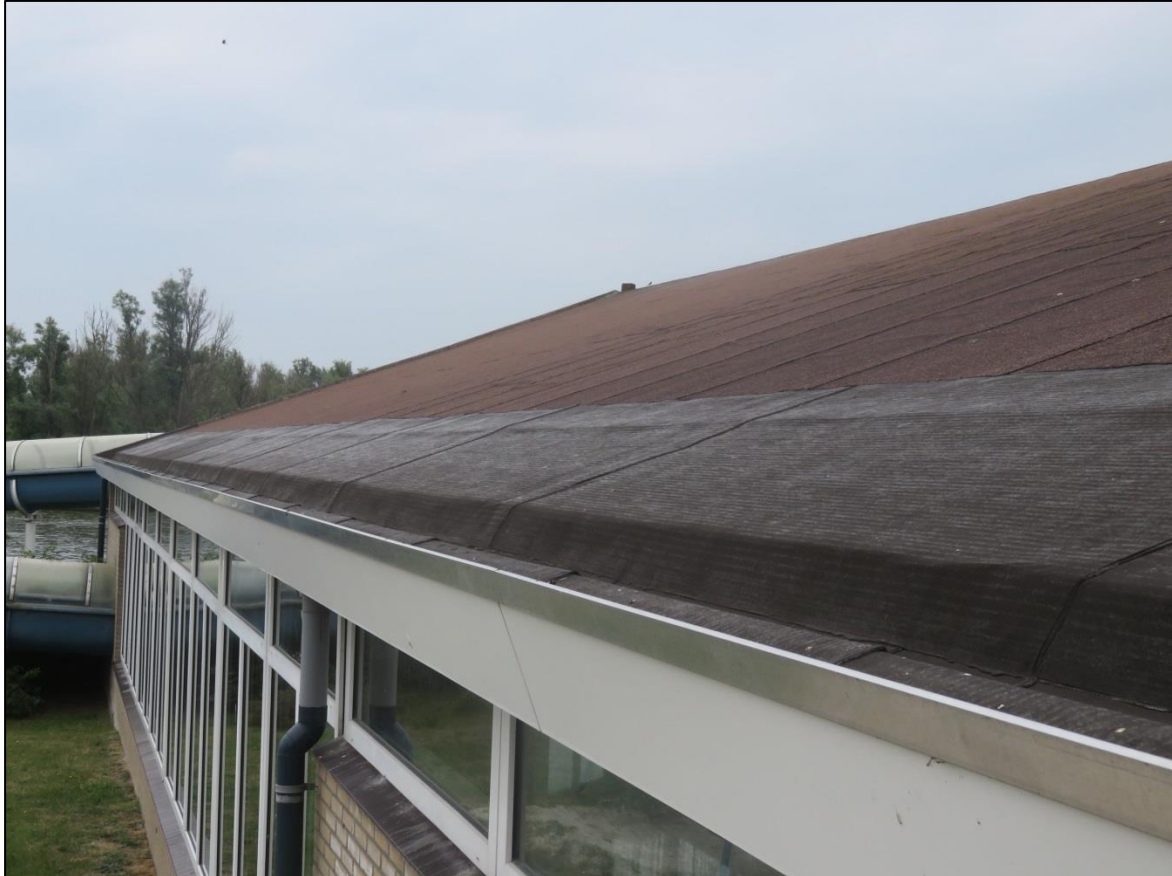
Figuur 2.2. De dakplaten van het zwembad sluiten aan op de dakgoot.
