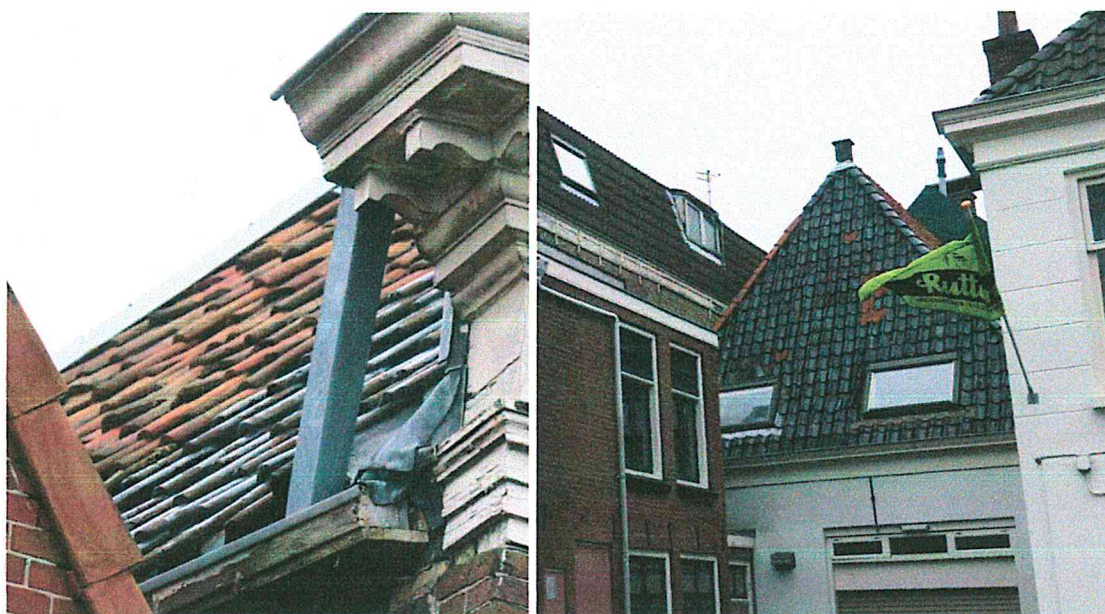
Figuur 3: Potentiële nestplaatsen Gierwaluw en Huismus in het dak van het pand aan het Grootzand 85
