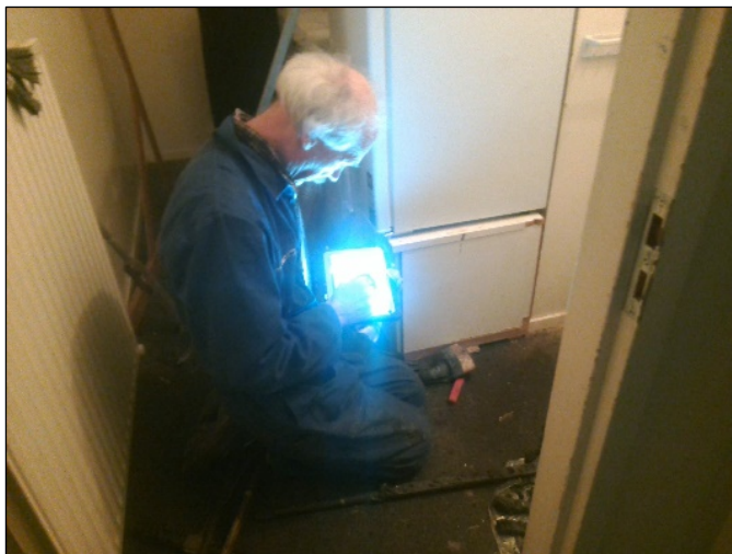
Afbeelding 10. Foto van het inpandig boren, boring 1 (bron: MUG Ingenieursbureau, afdeling milieu)
